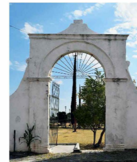
3. Vista externa del acceso norte del patio.
