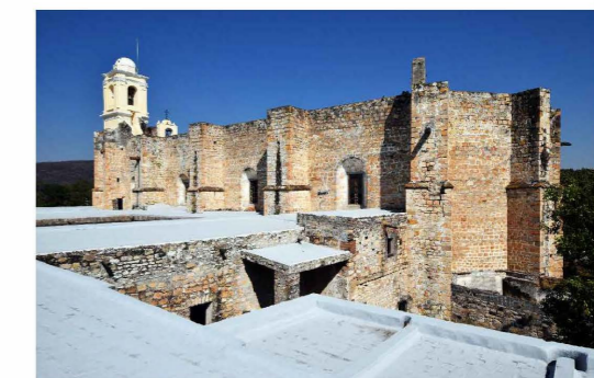
2. Vista de la parte alta de la iglesia desde el techo del lado sur del convento.
