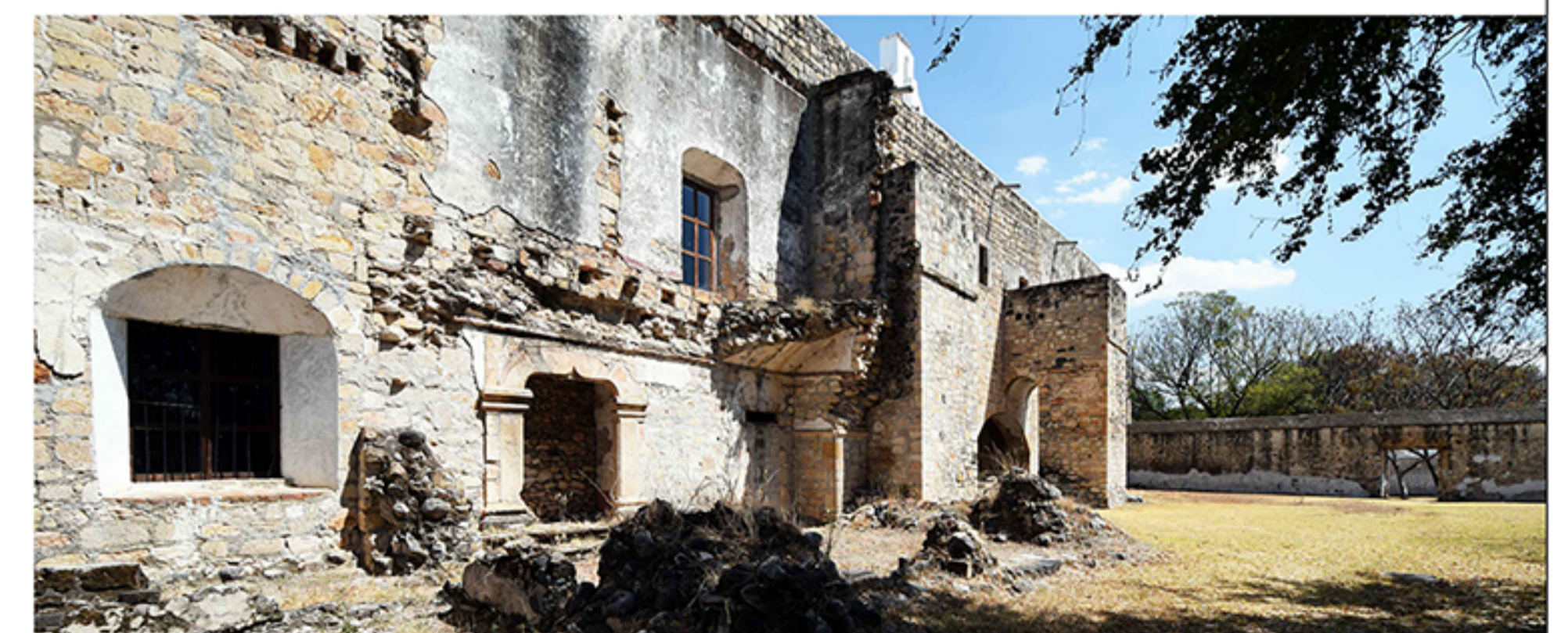
6. Vista del ala sur del convento. Las construcciones en ruinas pudieron haber pertenecido al noviciado.
