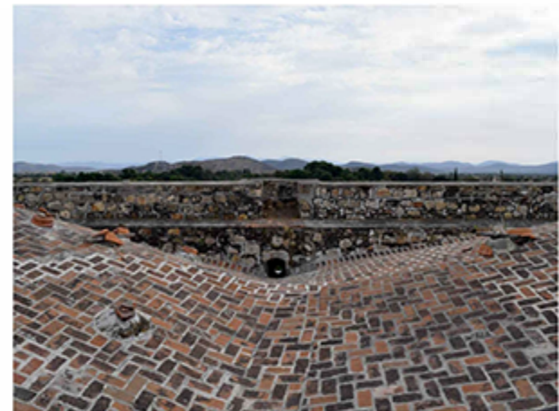
2. Detalle del extradós de las bóvedas de la iglesia.
