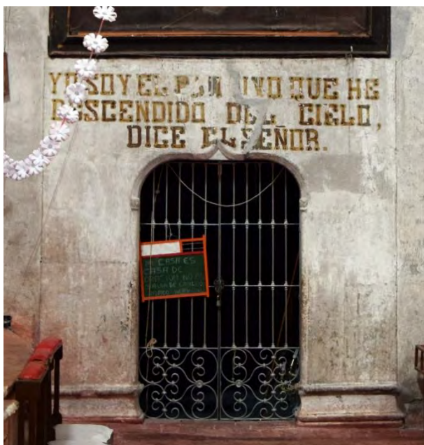
Fig. 1.8. Acceso a la sacristía desde el coro bajo.
