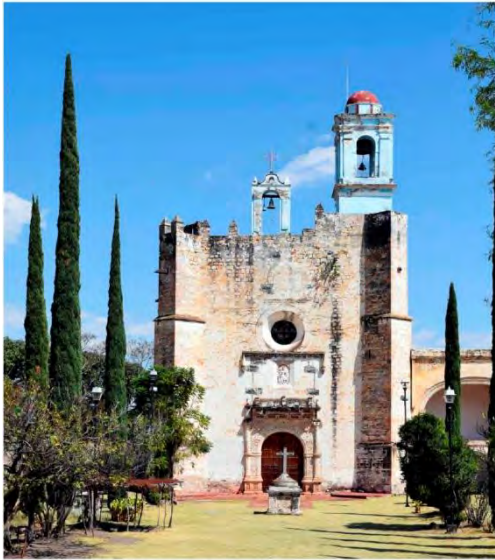
Vista de la fachada principal.
