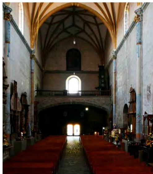
Sotacoro y coro alto vistos desde el centro de la nave.
