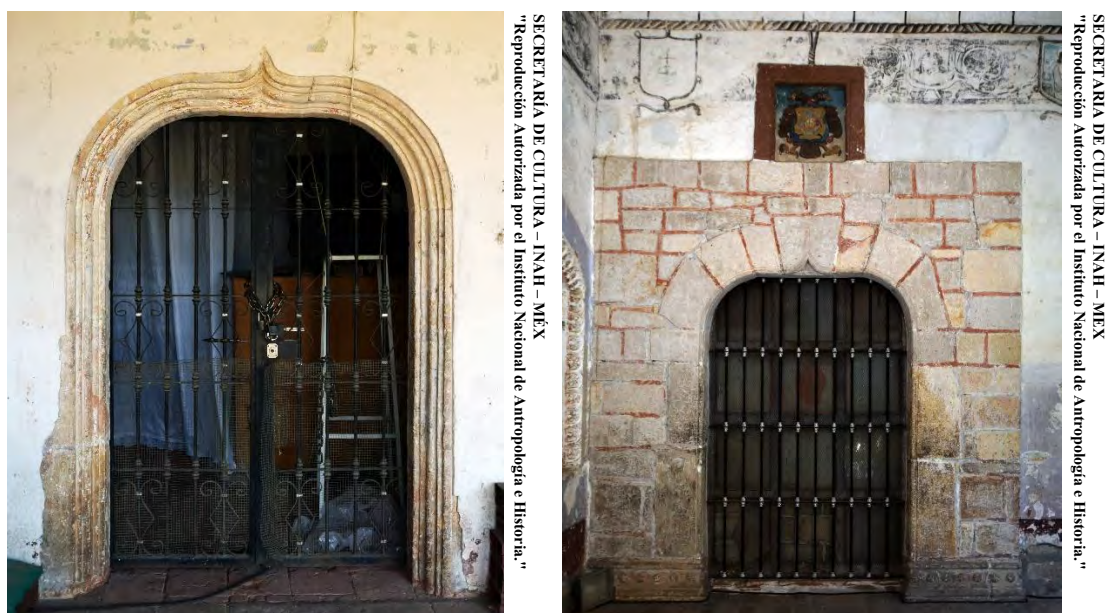
Figs. 1.11-1.12. Portal de ingreso al convento y acceso a la sacristía, respectivamente.
