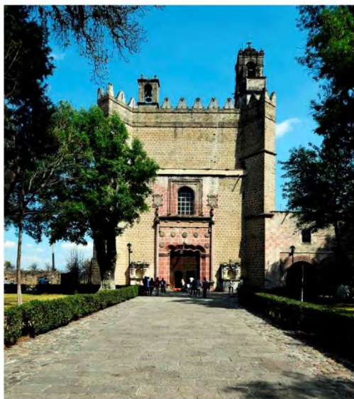
Vista de la fachada principal.
