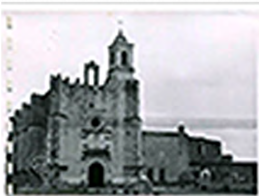
Vista del templo y monasterio desde el patio. A la derecha de la iglesia se evidencian la portería del convento y la capilla abierta antes de la intervención para recuperar su aspecto originario. (Foto CCIII-61-Fototeca Constantino Reyes-Valerio, en adelante FCR-V).
