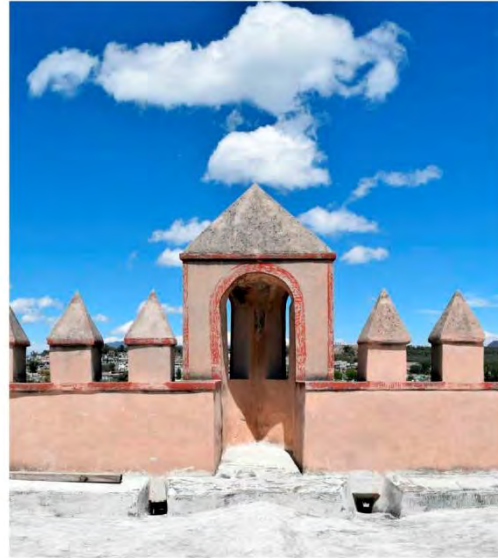
Vista de uno de los garitones desde el extradós de las bóvedas.
