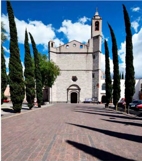
Vista de la fachada principal.
