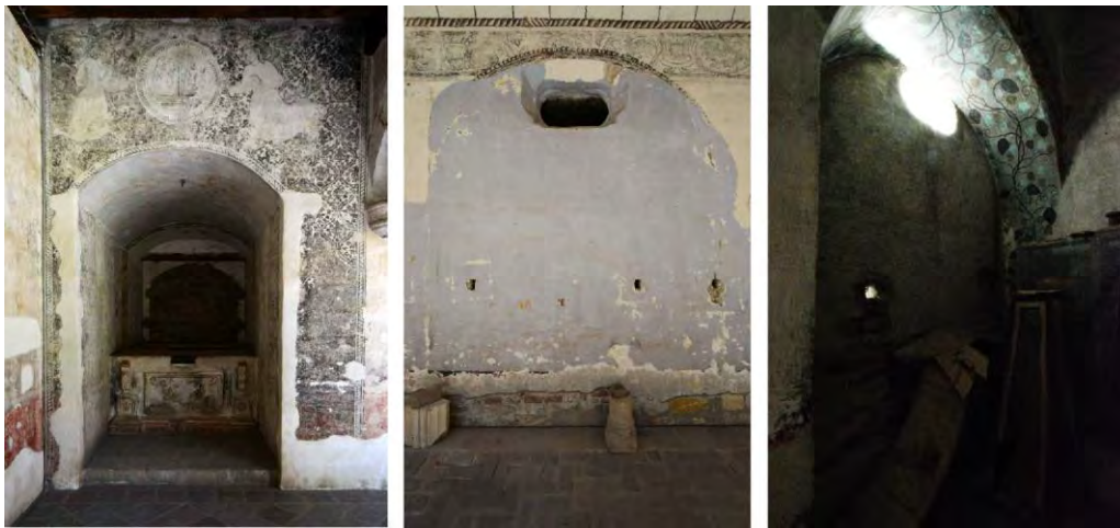
Figs. 3.5-3.6. Enlaces tapiados entre el claustro y la iglesia en los conventos de Huejotzingo y Huaquechula, respectivamente. Fig. 3.7. Enlace tapiado en el convento de Huaquechula visto desde el corredor emparedado entre el claustro y la iglesia.
