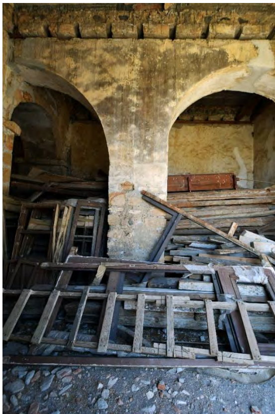
Fig. 1.17. Granero del convento.
