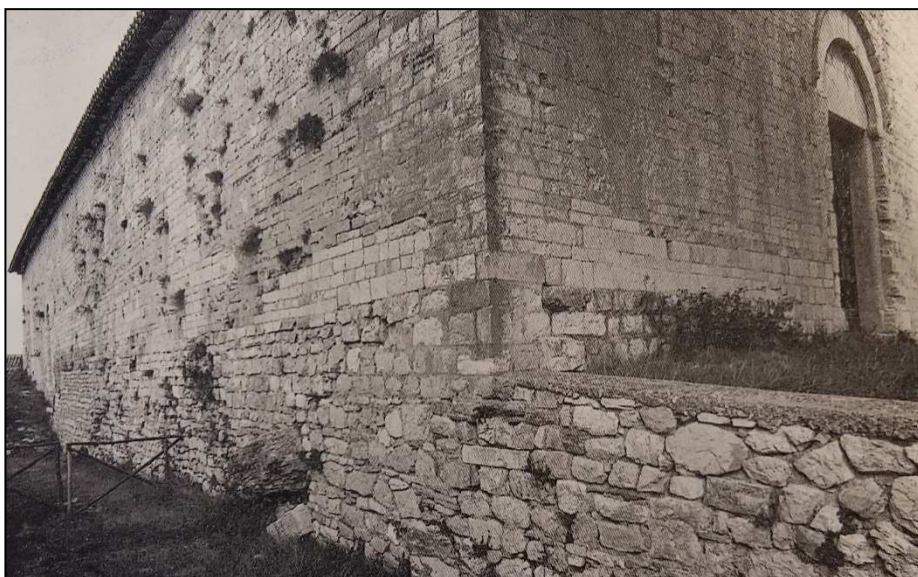
S. Giuliano. Fianco sinistro.
