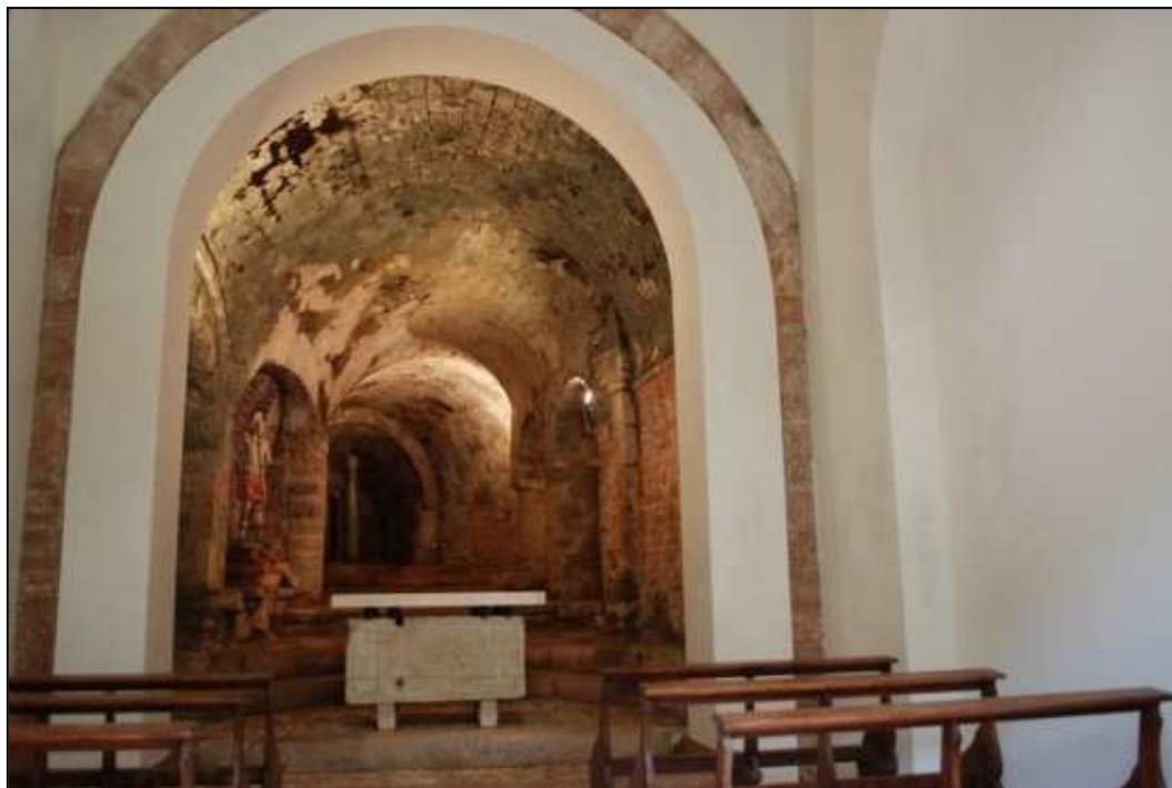
Chiesa di S. Angelo. Interno.
