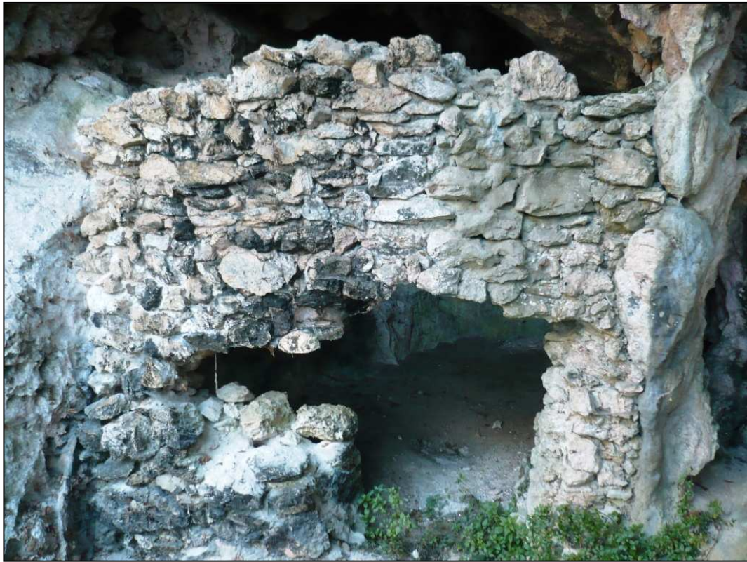
Grotta del Muro
