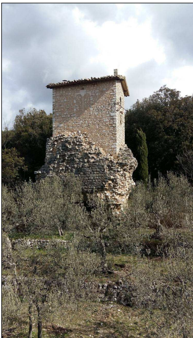
S. Antonio. Resti di struttura romana
