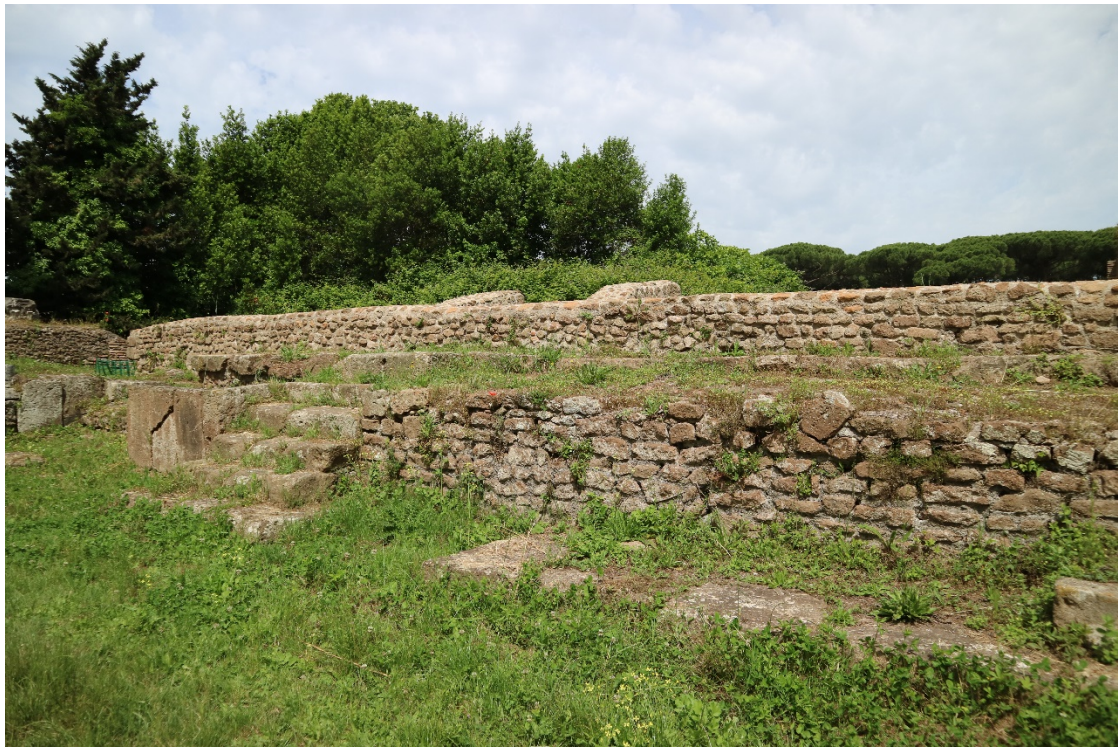
Figura 11: Basamento dei Quattro Tempietti, ripristino dell'alzato con muratura rudimentale.
