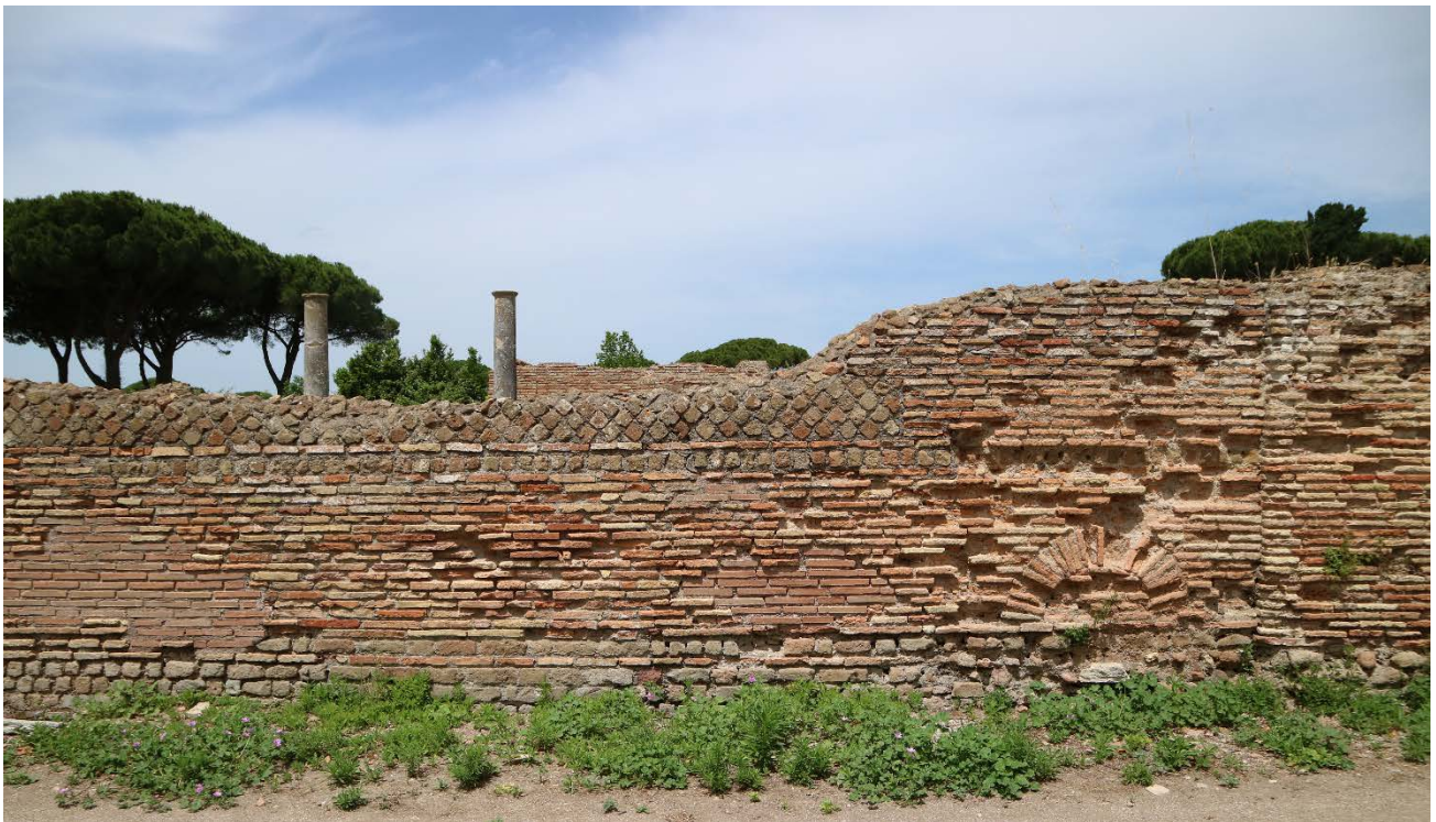
Figura 26: Domus dei Pesci. Muro perimetrale, versante esterno.
