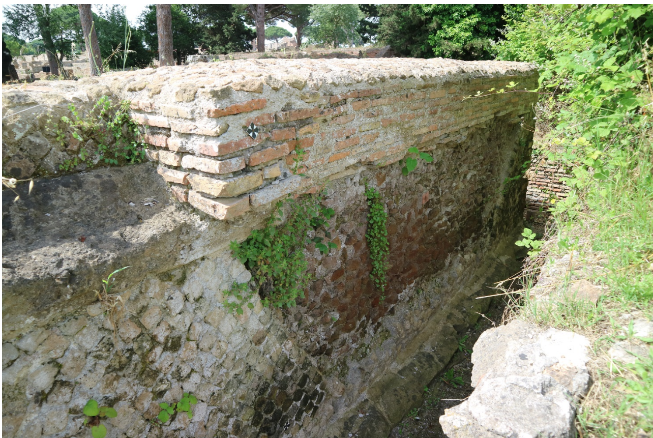
Figura 12 bis: Tempietto I. Rinforzo in opera laterizia contestuale alla costruzione del c.d. impianto industriale.
