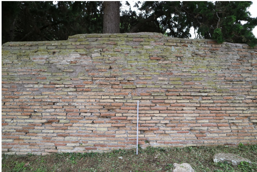
Figura 15: Integrazione della porzione superiore del muro attraverso mattoni antichi e malta violacea.
