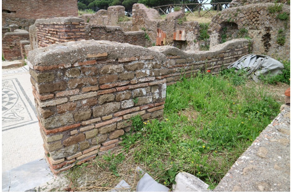
Figura 13: Domus di Apuleio. Ripristino delle creste murare attraverso coperture cementizie e restauro mimetico che rende quasi irriconoscibile la parte restaurata da quella originale.
