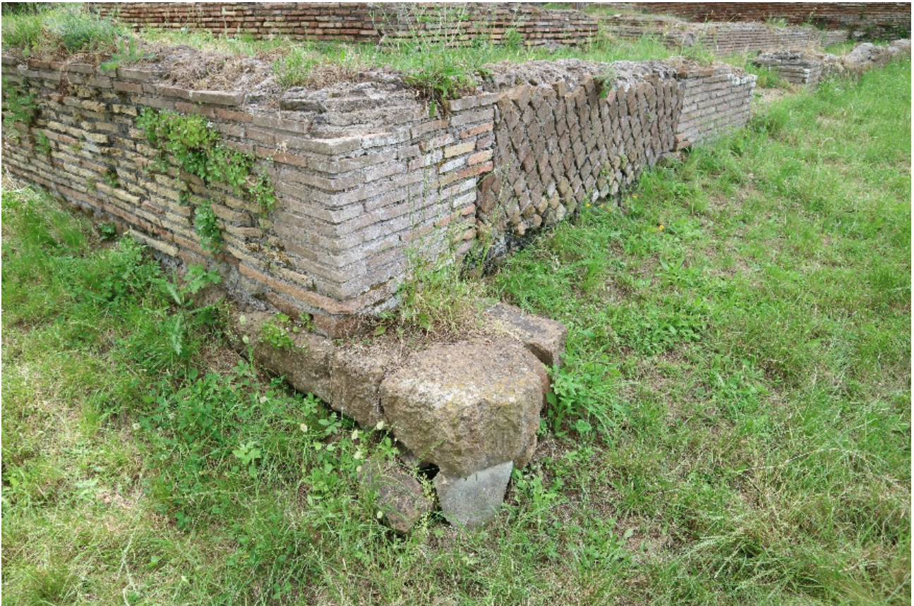
Figura 27: Angolo SE del c.d. impianto industriale. Resti di una soglia in tufo posta a quota m 1,50 slm su cui si imposta il muro successivo.
