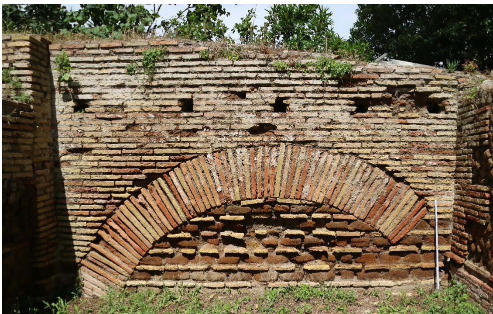
Figura 17: Muro di chiusura orientale del portico retrostante le botteghe
