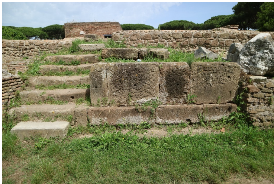
Figura 11: Particolare della scala centrale da cui avviene l'accesso al Tempietto III. A destra si notano i blocchi tufacei probabilmente riutilizzati per realizzare delle vasche.
