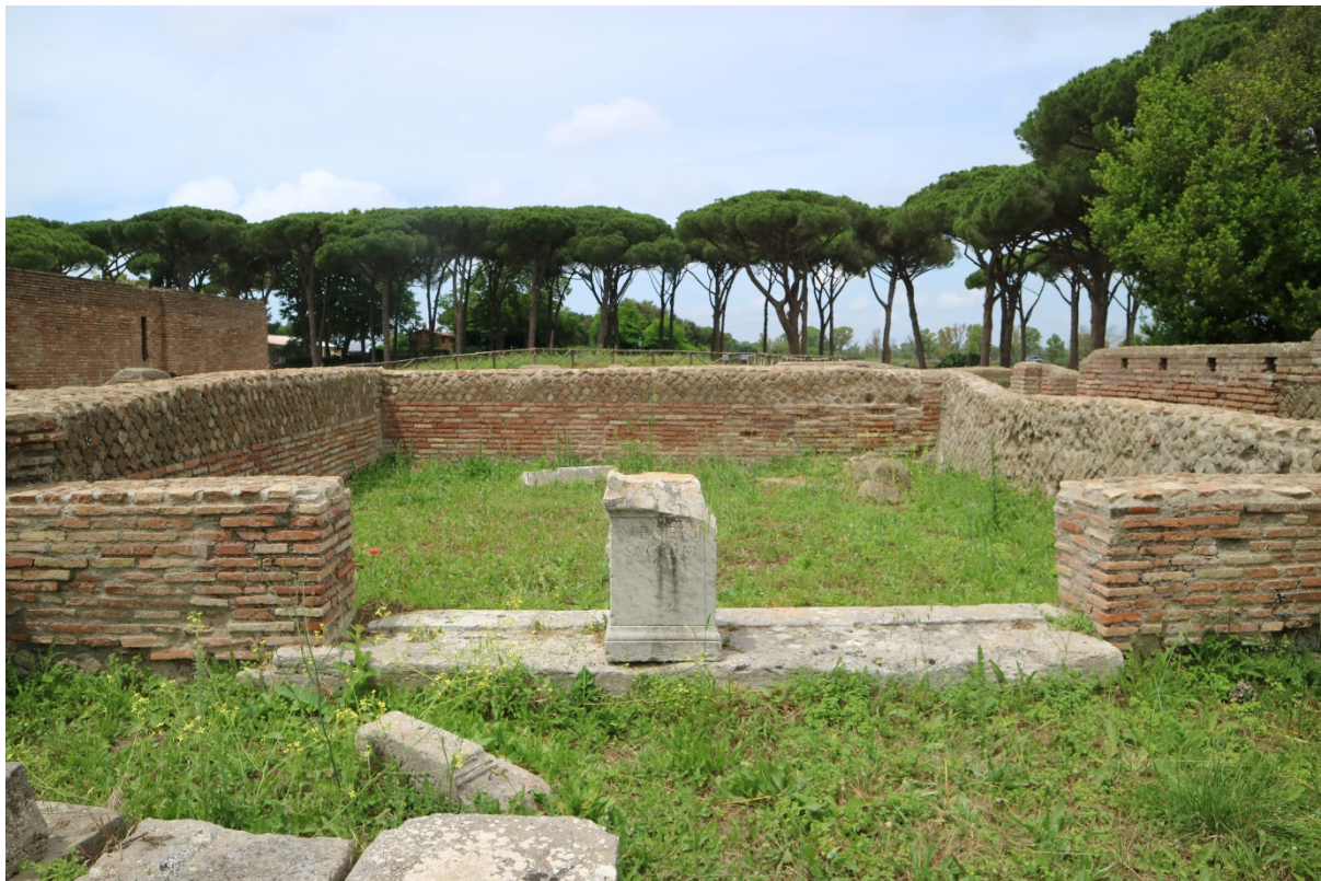
Figura 6: Tempietto IV. Particolare della cella rifatta in opera mista.
