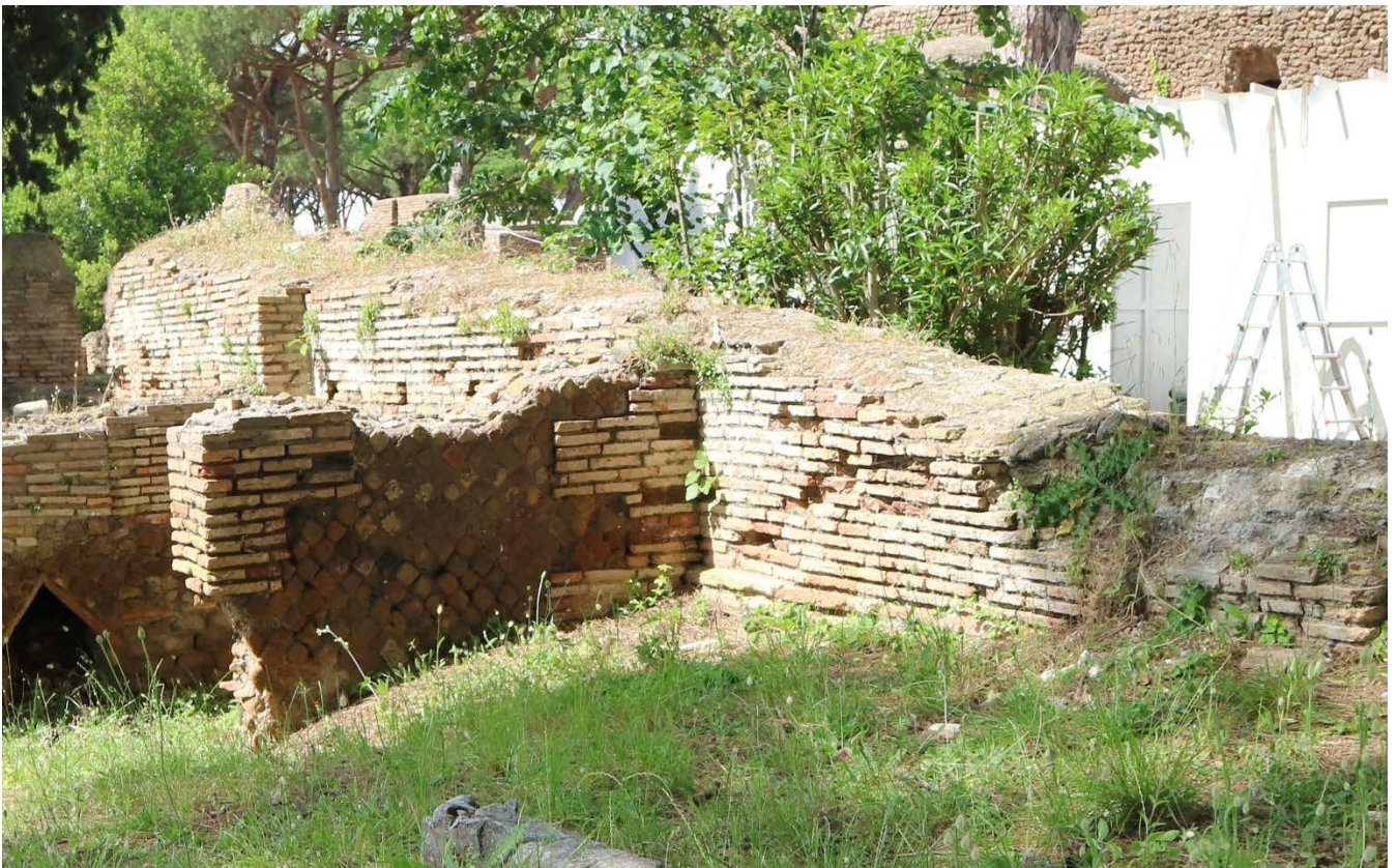
Figura 5: Angolo nord est della bottega A. Si notino i bipedali utilizzati come marcapiano a quota m 2,90 slm.
