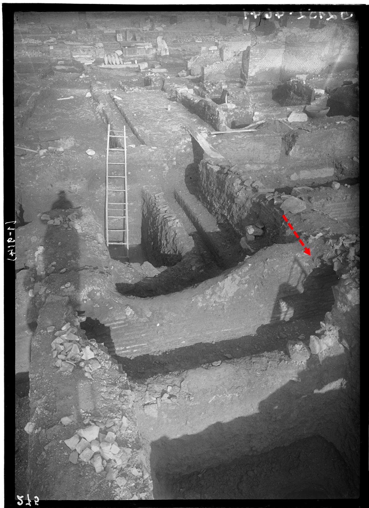
Figura 7: Scavo del piazzale, vista da sud. La freccia indica la spalletta in muratura del condotto fognario che attraversava tutte le botteghe da est ad ovest, interdicendo anche il passaggio dal corridoio meridionale (Parco Archeologico di Ostia Antica-Archivio Fotografico, n. B2152).
