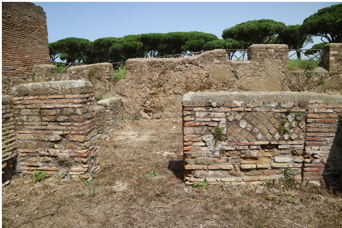
Figura 27: Muro meridionale dell'ambiente O della Domus di Apuleio.
