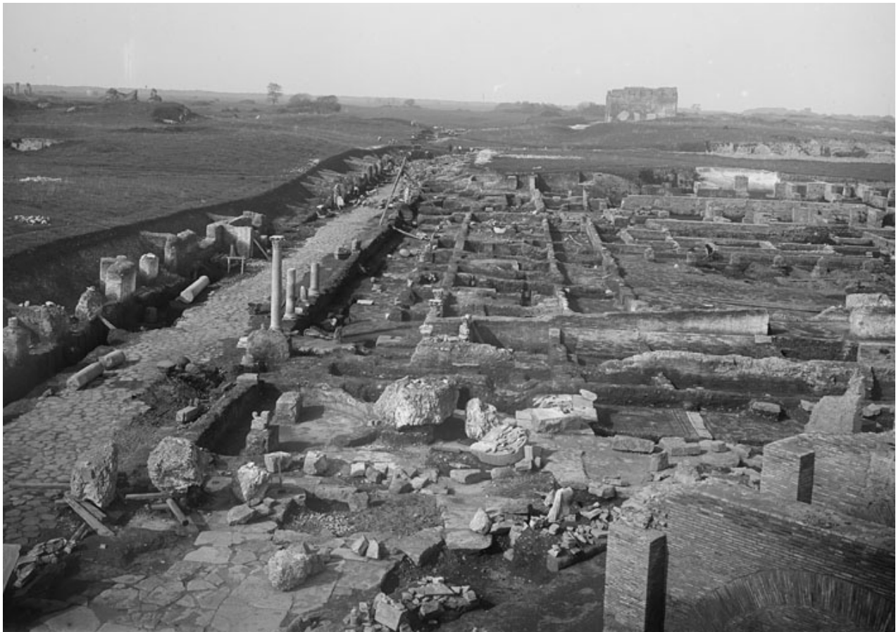
Figura 6: Scavo delle strutture tra il Piazzale e il teatro, vista da est (Parco archeologico di Ostia Antica- Archivio Fotografico, n. B2091).
