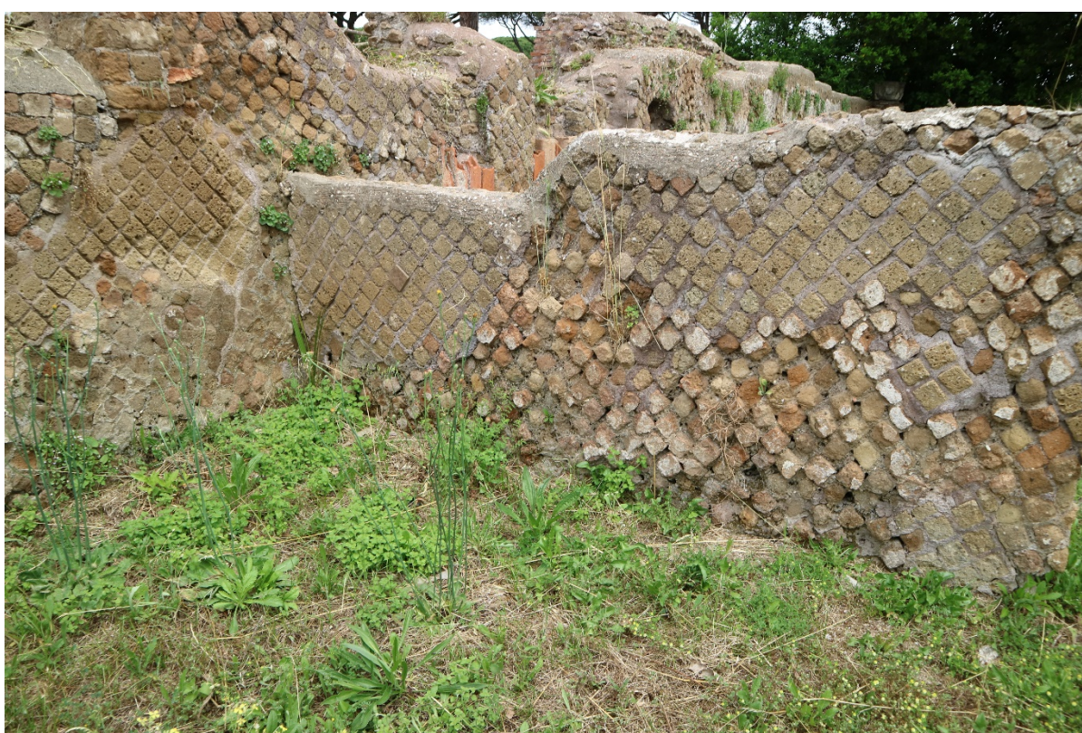
Figura 5: Amb. N. Resti in opera reticolata addossati al muro di fondo della Domus.
