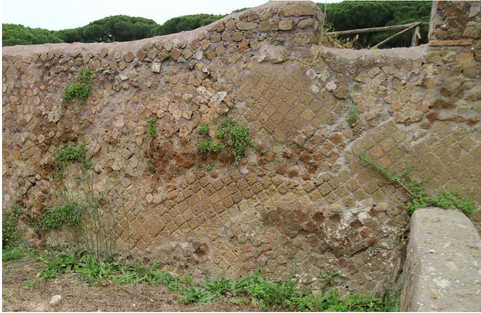
Figura 18: Particolare del muro di fondo della Domus di Apuleio. Integrazione dell'opera quasi reticolata con tessere tufacee moderne, leggermente in sottosquadro, ed imitanti la regolarità dell'opera reticolata (Restauro anni '50).
