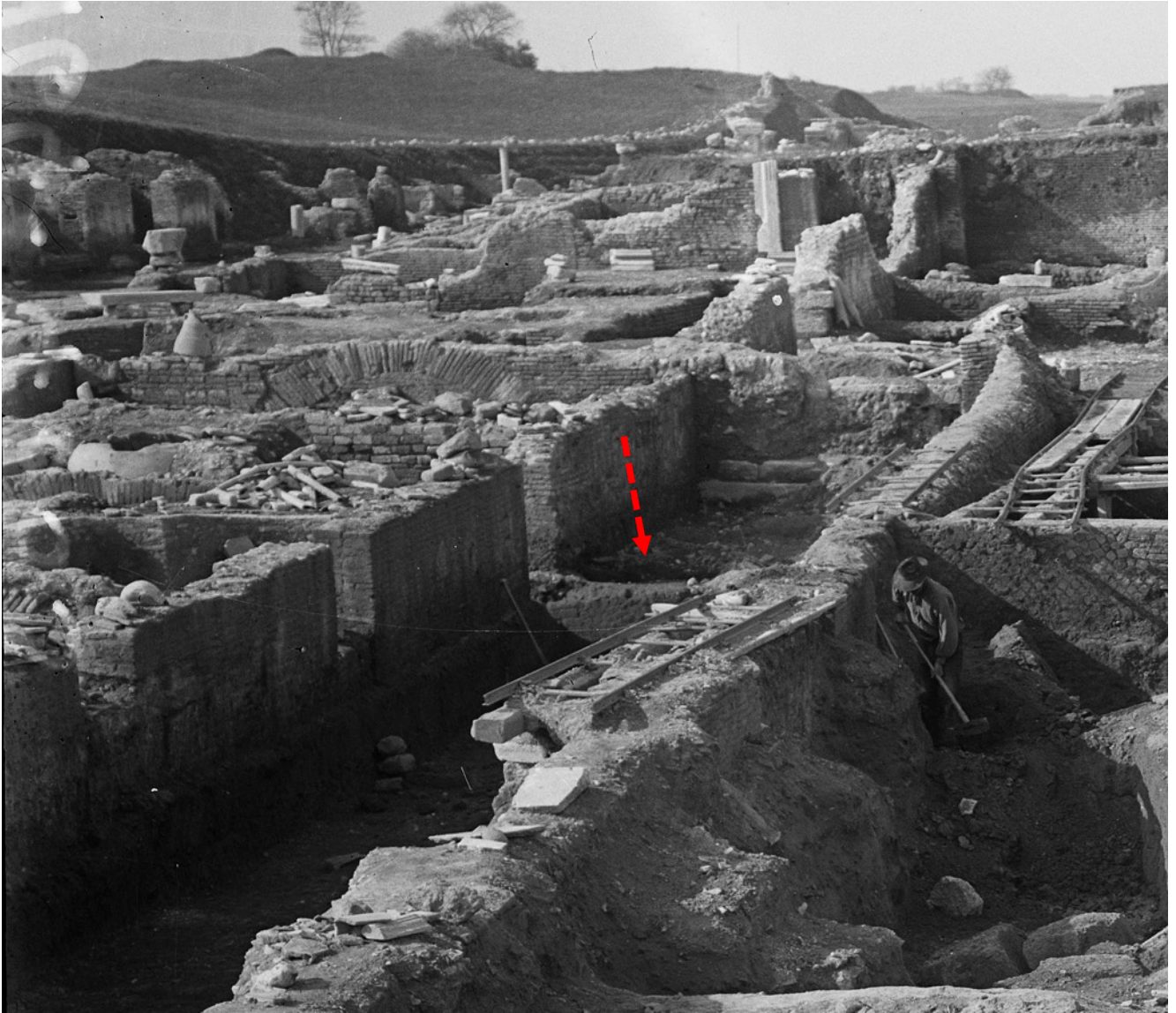
Figura 30: Particolare del lato meridionale c.d. stabilimento industriale e delle botteghe in fase di scavo. La freccia indica i muri in opera quasi reticolata (Parco archeologico di Ostia antica - Archivio Fotografico, n. B2164).
