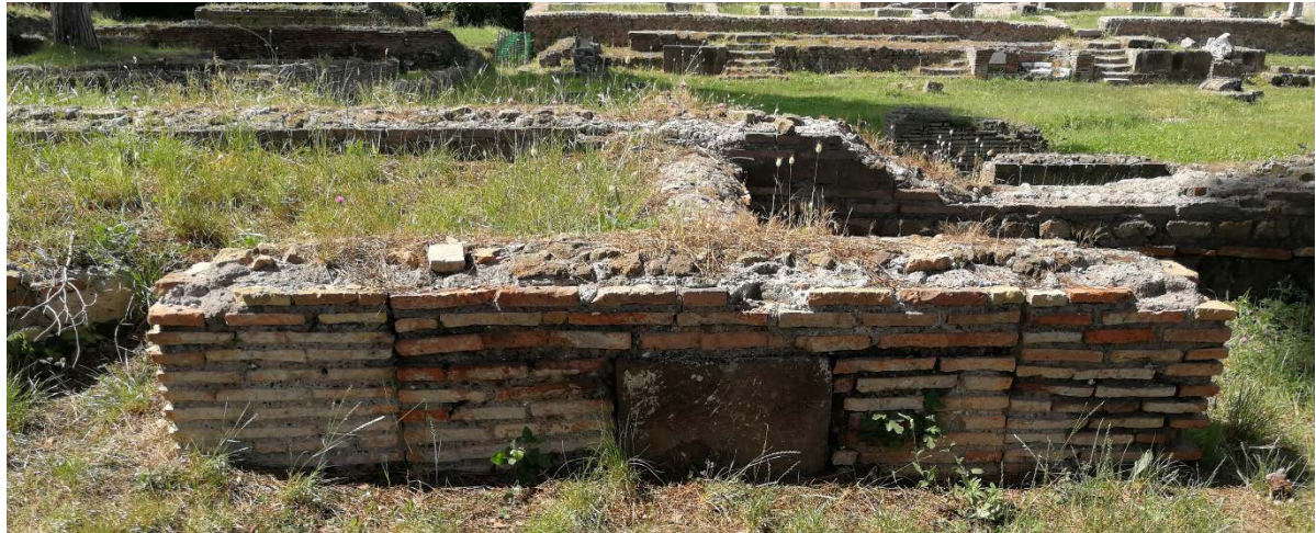
Figura 9: Testata degli amb. E ed F, con interventi di consolidamento e restringimento dell'apertura.
