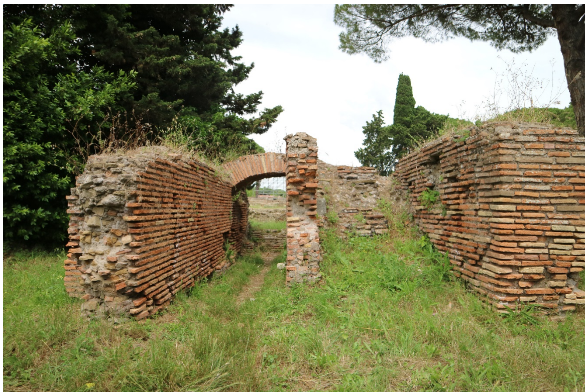
Figura 11: Veduta frontale del corpo scala del blocco 2.
