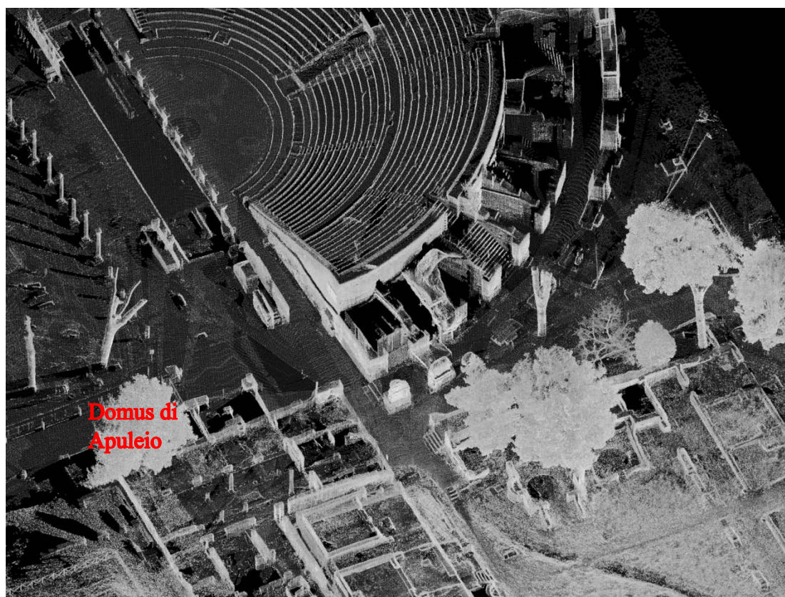
Figura 12: Rilievo laser scanner. Particolare del settore occidentale del teatro.
