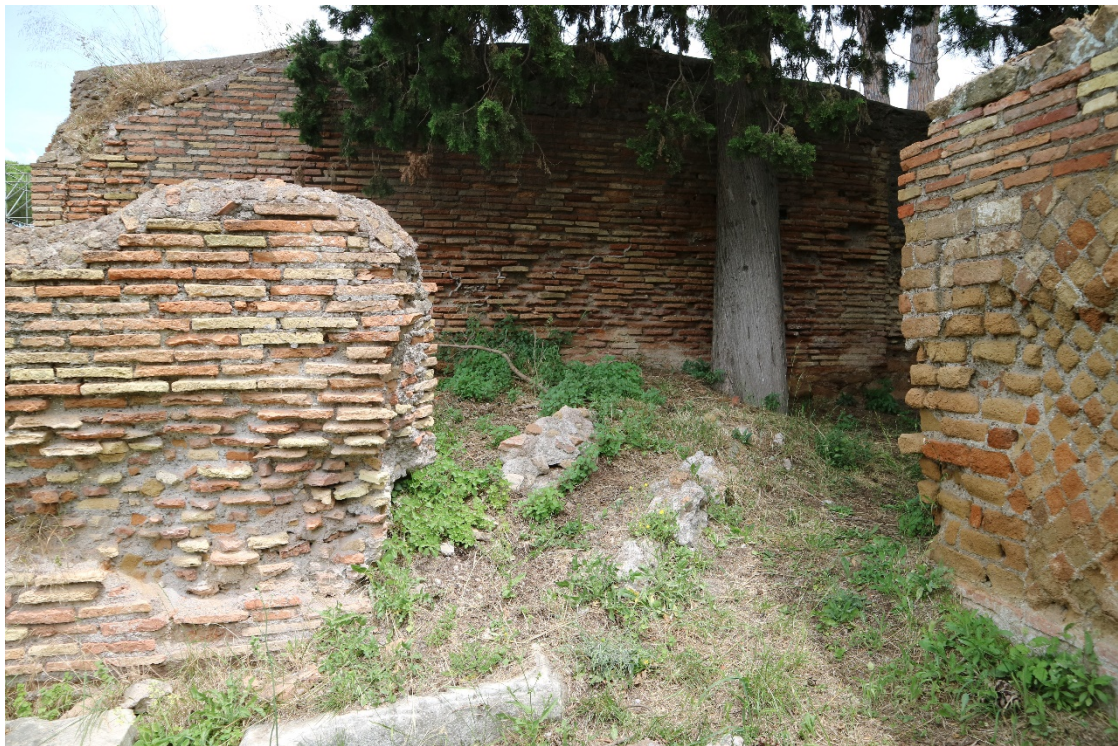
Figura 21: Area retrostante il Ninfeo. Resti del muro in opera vittata oggi quasi completamente rasato.
