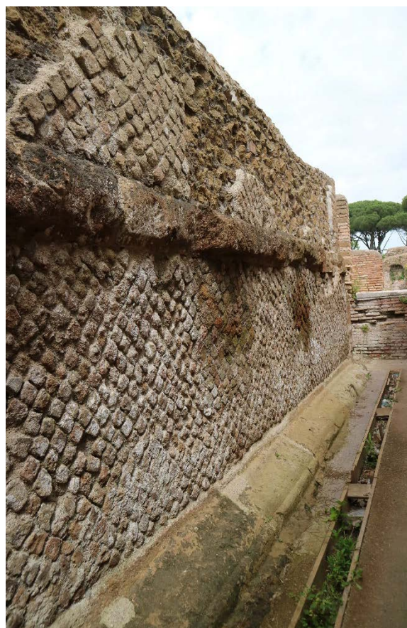
Figura 2: Podio dei Quattro Tempietti: coronamento e basamento in blocchi tufacei modanati. Particolare del lato nord.
