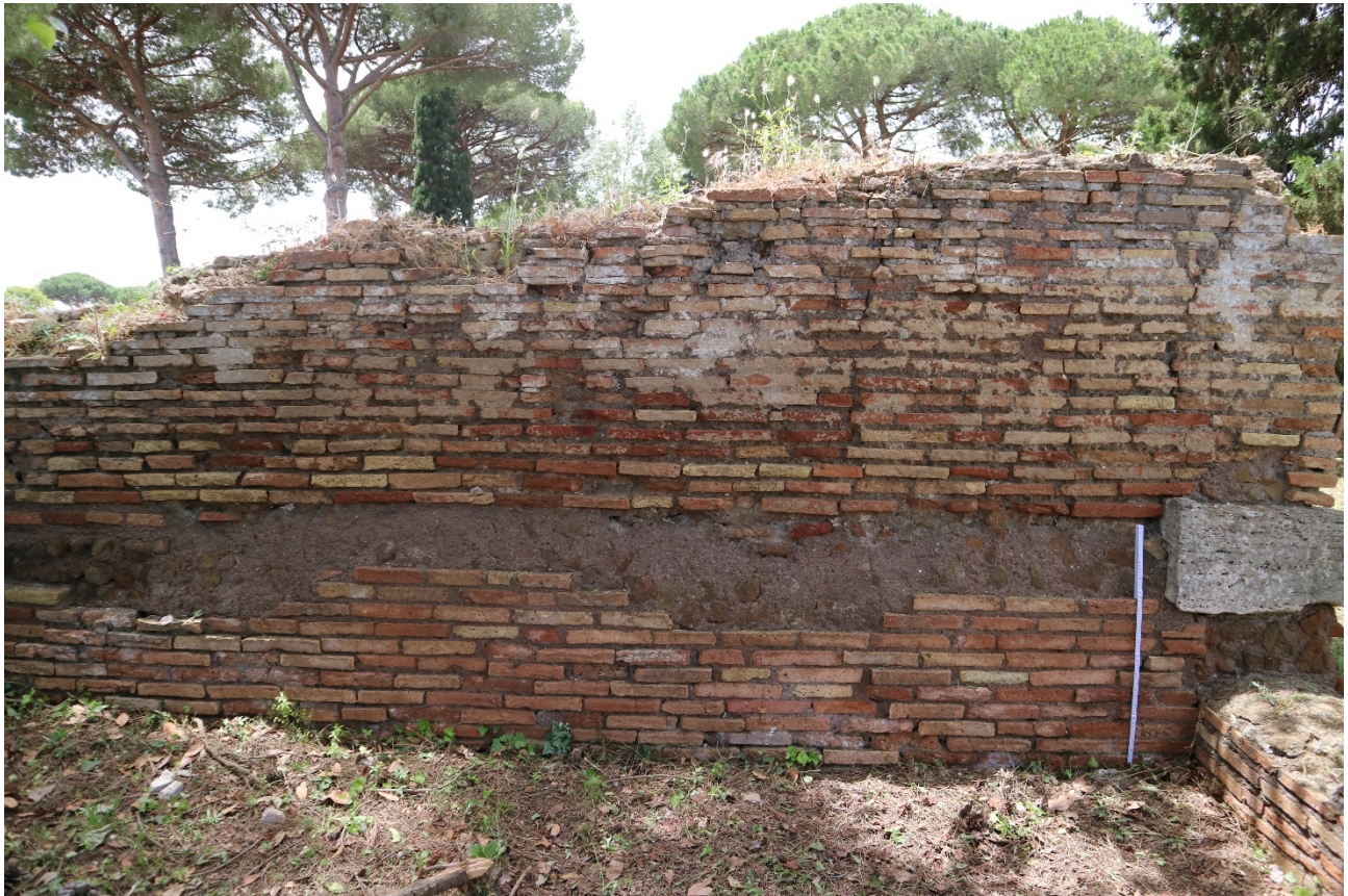
Figura 5: Resti ancora affioranti pertinenti alle strutture tra il Piazzale ed il teatro (cortina di restauro)
