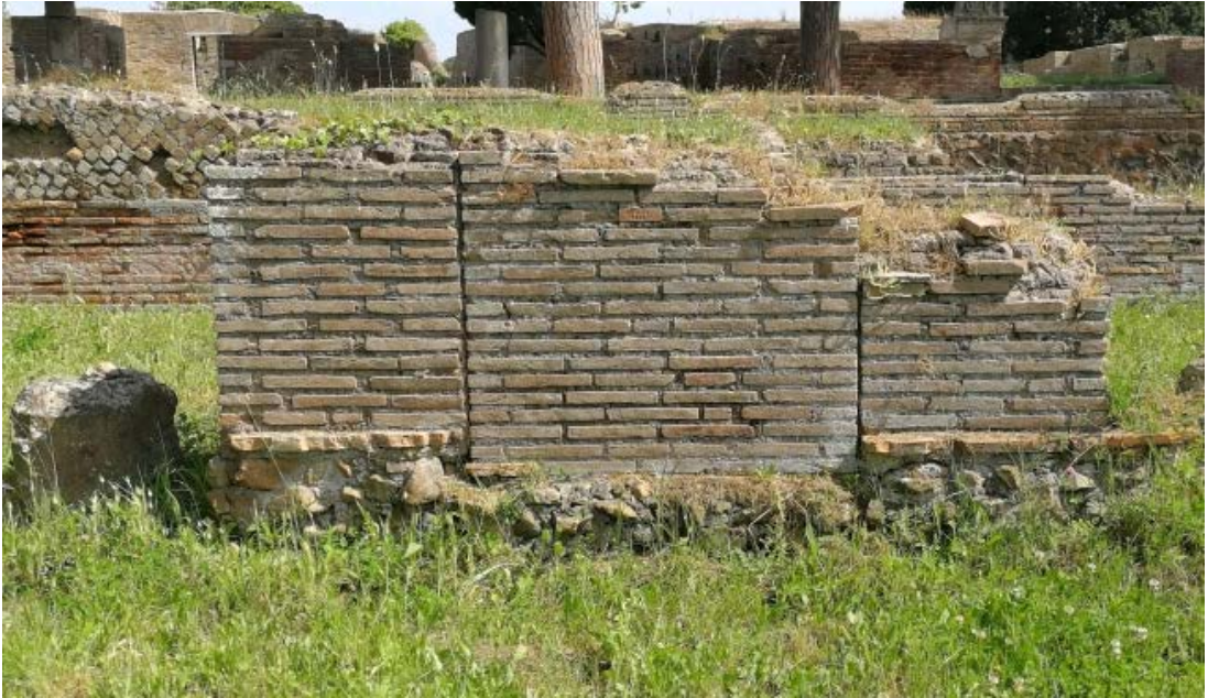
Figura 16: Resti del portico a pilastri dell'area dei Tempetti. Restauro integrativo del 1958 tramite mattoni moderni.
