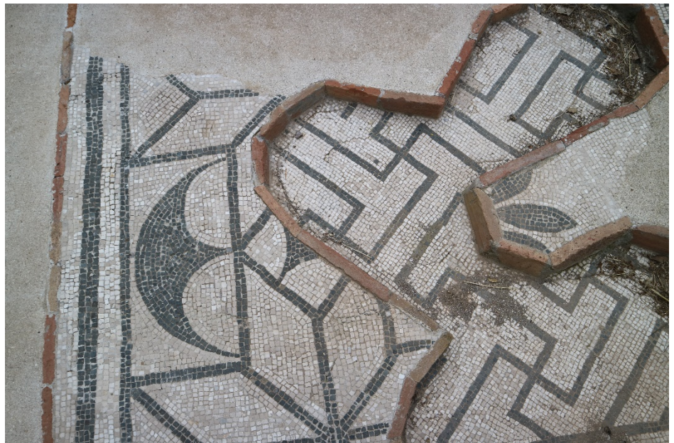
Figura 14: Bloccaggio dei mosaici della Domus con mattoni posti di taglio.
