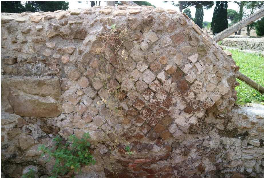
Figura 8: Muretto di chiusura del corridoio centrale in opera reticolata/mista. Particolare del versante esterno.
