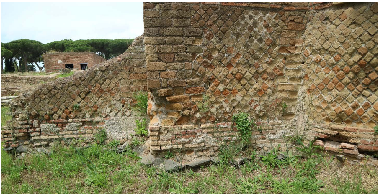
Figura 5: Particolare della fondazioni a vista del Ninfeo
