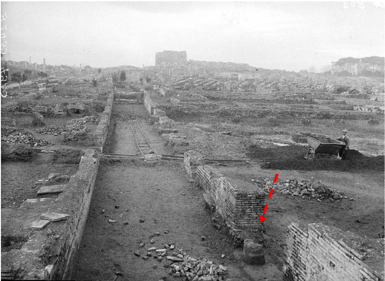
Figura 28: sistemazione del portico e della zona retrostante alla fine degli scavi, vista da est. La freccia indica una base di tufo in cui è inserito un rocchio di colonna, sempre in tufo.
