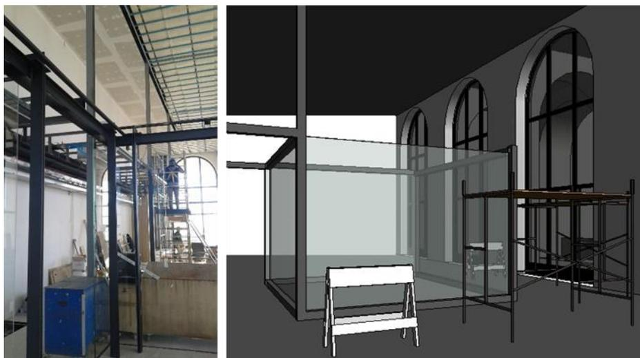
**Figura 54.** Confronto tra il momento della progettazione virtuale della sicurezza e la sua applicazione in campo reale. In questo caso la dimensione 4D del BIM viene impiegata per la verifica delle sovrapposizioni operative (Fioravanti et. al, 2018).
