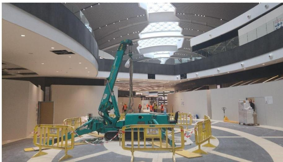
**Figura 45.** Riunione settimanale di cantiere. Il tema specifico riguardava la definizione dei percorsi dei materiali per il rifornimento dei piani superiori, e la contestuale verifica delle interferenze del raggio di azione del braccio meccanico.
