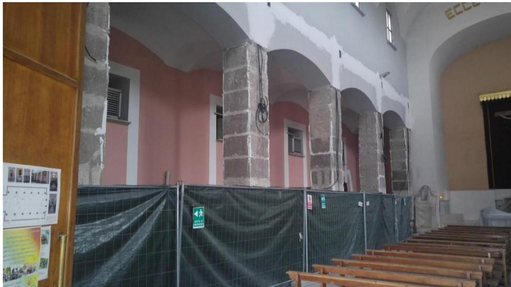
*Figura 100. Progressione dei lavori, completamento della rimozione delle lastre in marmo. Caso 2*
