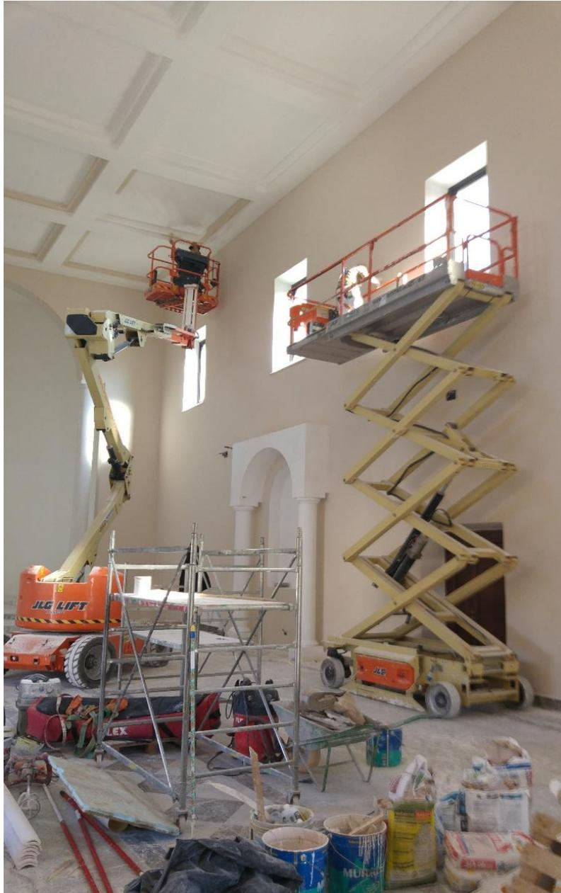
**Figura 94.** *Finiture e completamento, in un momento di alta occupazione delle aree. Si noti la presenza in continuità di due squadre lavorative a ridosso dell'area logistica di cantiere. Caso 1*
