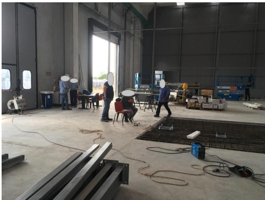
**Figura 53.** Un cantiere durante una ispezione. Le misure correttive adottate in seguito consisteranno nella migliore ubicazione delle attrezzature e il ricollocamento della forza lavoro, in numero eccessivo rispetto alle reali esigenze della micro-fase in corso. Cantiere di realizzazione di un nuovo sito industriale, 2017.
