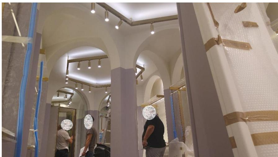
*Figura 50. Aggiunta di corpi illuminanti dopo la chiusura delle lavorazioni, a seguito della verifica dell'insufficienza dei Lux presenti. (Roma, 2016).*
