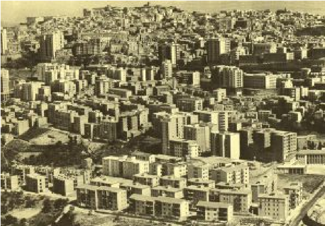
[Fig. 4 – Veduta di Agrigento verso la Valle dei templi. Fonte: Commissione di indagine sulla situazione urbanistico-edilizia di Agrigento, Relazione al Ministro, on. Giacomo Mancini, Ministero dei Lavori pubblici, Roma, 1966.]
