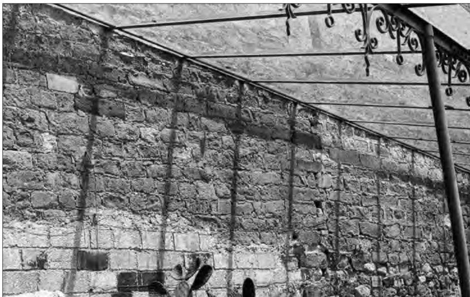
Fig. 5. - Città del Vaticano, tratto di mura medievali (XIV secolo) sul tracciato della cinta leonina con integrazioni moderne (in basso).
