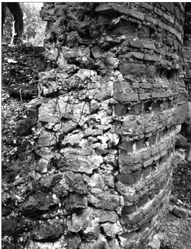
Fig. 6. - Tivoli, resti di edificio religioso a Colle Ripoli: particolare della sezione della struttura muraria dell'abside (XI-XII secolo).
