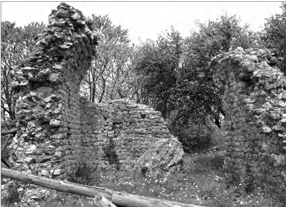
Fig. 12. - Palombara Sabina, Castello di Castiglione: particolare del paramento interno della muratura di un edificio adiacente alla torre interna alle mura (XIII secolo).
