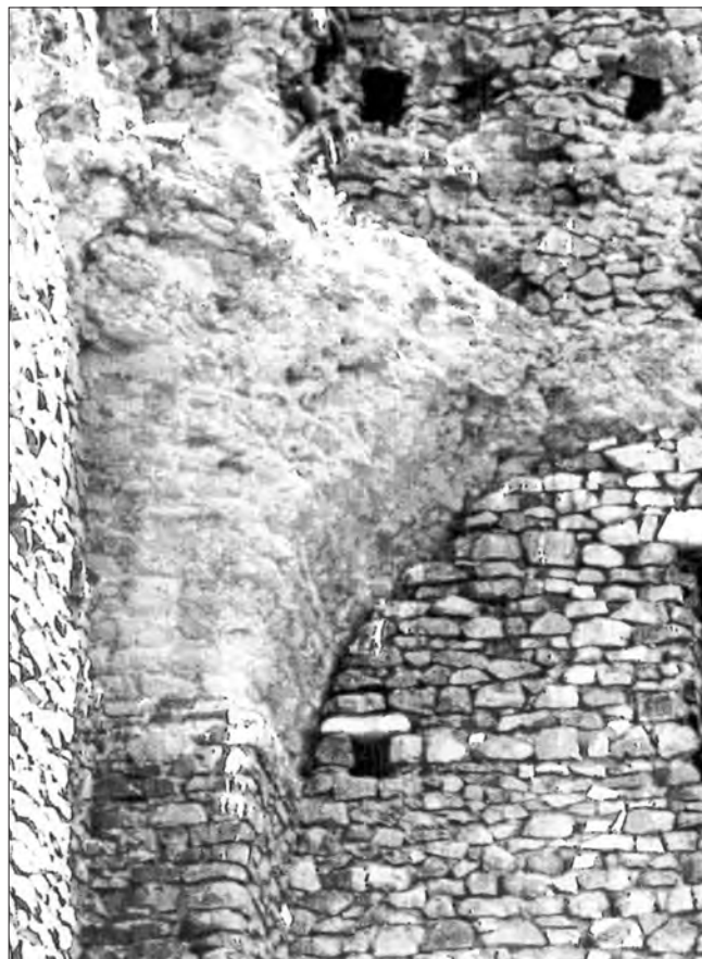
Fig. 2. - Roma, Tor Chiesaccia sulla via Laurentina: particolare del resto della volta in conglomerato cementizio.
