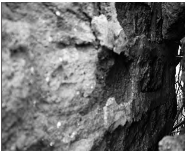
Fig. 8. - Roma, Casale dei Gallicano sulla via Tiburtina: particolare della finitura superficiale del muro in elevato di un edificio (XIII secolo) presso la torre (XII secolo).
