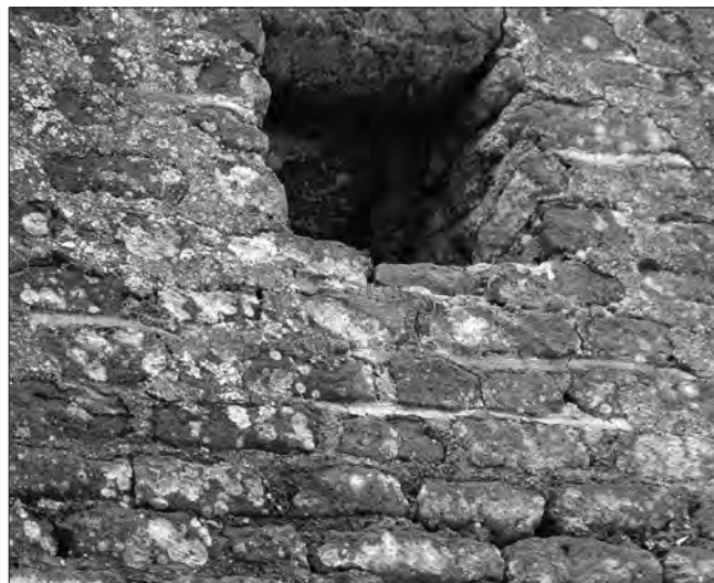
Fig. 9. - Cisterna di Latina, Castello di Ninfa: particolare della finitura ‘a scivolo’ dei giunti del paramento di un edificio del XIII secolo presso la chiesa di S. Maria Maggiore.
