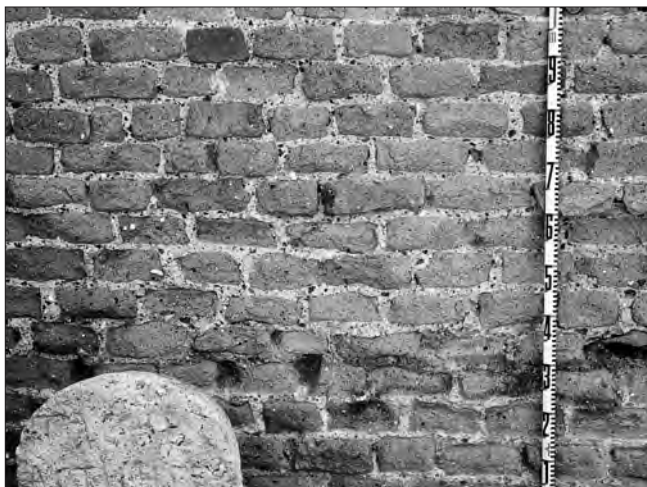
Fig. 1. - Roma, Palazzo del Castrum Caetani a Capo di Bove sulla via Appia antica: particolare del paramento (prima metà XIII secolo) in blocchetti di tufo litoide.
