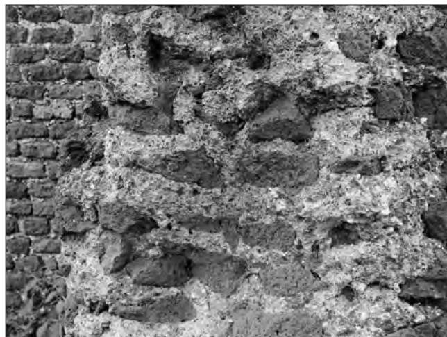
Fig. 3. - Roma, Casale dei Gallicano sulla via Tiburtina: particolare della sezione muraria della muratura con paramenti in blocchetti lapidei a corsi orizzontali.
