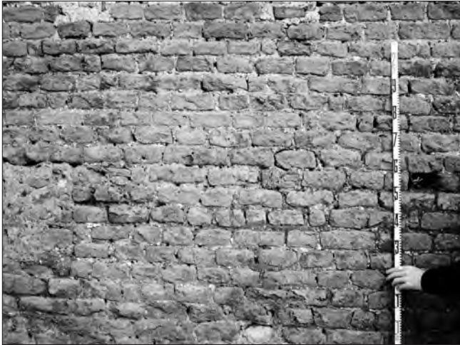
Fig. 10. - Roma, Rocca Savelli, cinta muraria: particolare del paramento in blocchetti di tifo litoide lionato (seconda metà XIII secolo).
