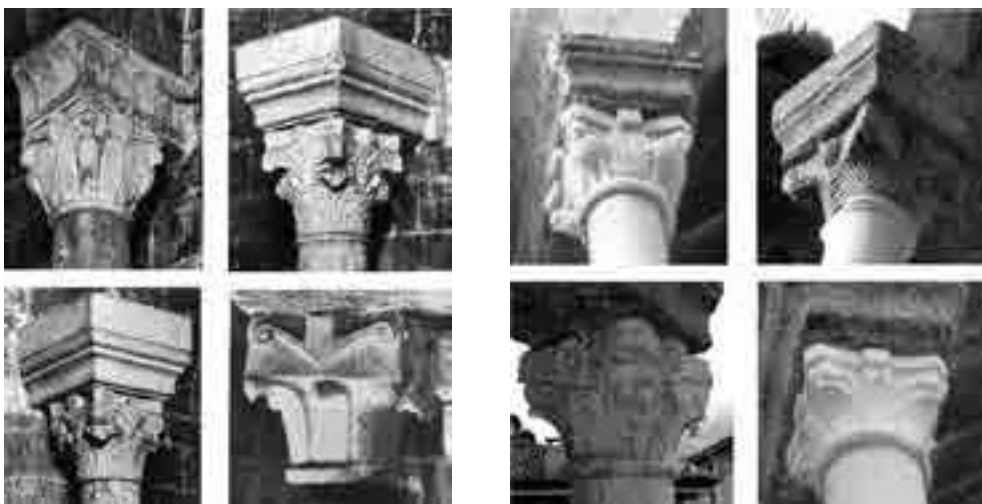
Figura 6. Gravedona (CO), Santa Maria del Tiglio, capitelli della galleria interna e dell'abside, da ZASTROW 1978, pp. 111-112. Figura 7. Como, San Fedele, capitelli della galleria absidale esterna (foto di M. Tabanelli, 2012).
