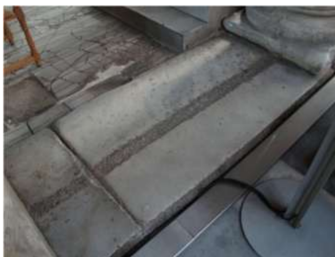
Fig. 93 Particolare di una parte dello stilobate con ben visibile la traccia lasciata dalla transenna di divisione, RAPTIS 2016, fig. 188
