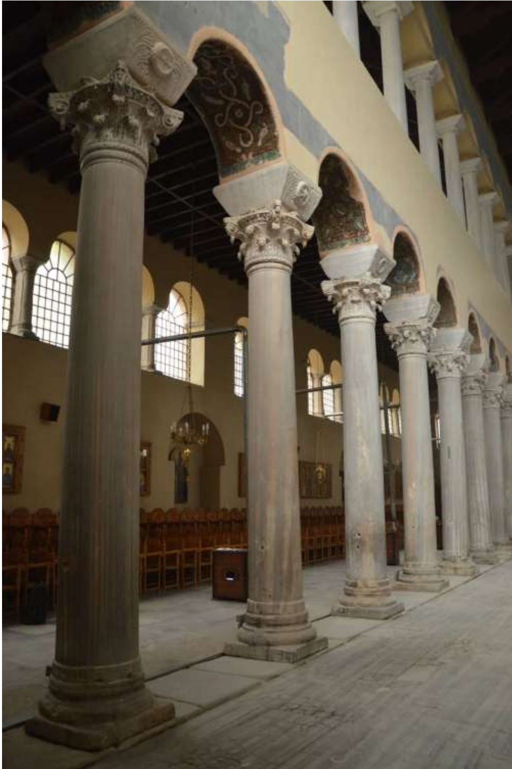
Fig. 94 Le tracce dell'ancoraggio delle transenne alle colonne di divisione tra la navata centrale e la navata settentrionale, RAPTIS 2016 , fig. 182
