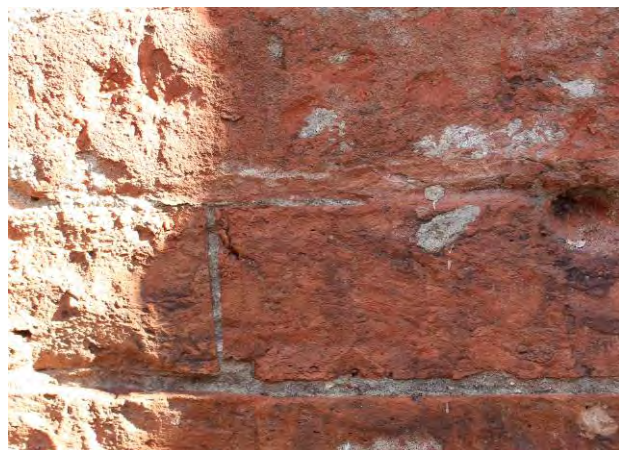
Dettaglio della finitura dei giunti rilevata sulla facciata della Chiesa di San Nicolò
