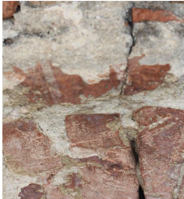
Traccia della finitura rilevata a nel prospetto Nord della Chiesa di San Francesco
