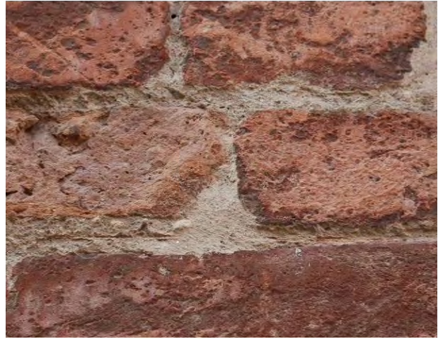
Dettaglio della finitura dei giunti rilevata sul prospetto dell'Abside della Cattedrale
