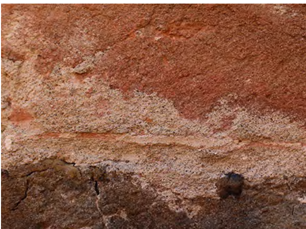
Dettaglio della finitura dei giunti rilevata sul prospetto sopra la loggia di Palazzo Tassoni
