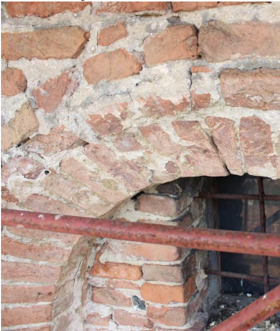
Traccia della finitura rilevata a nel prospetto Nord della Chiesa di San Francesco
