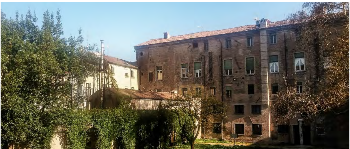
Dall'alto, vista del fronte Est della Via Coperta; al centro vista dell'attuale Piazza del Municipio; sotto vista interna del Giardino delle Duchesse.
