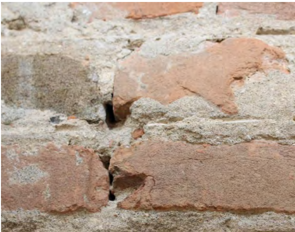
Dettaglio della finitura dei giunti rilevata sul prospetto Nord della Chiesa di San Francesco
