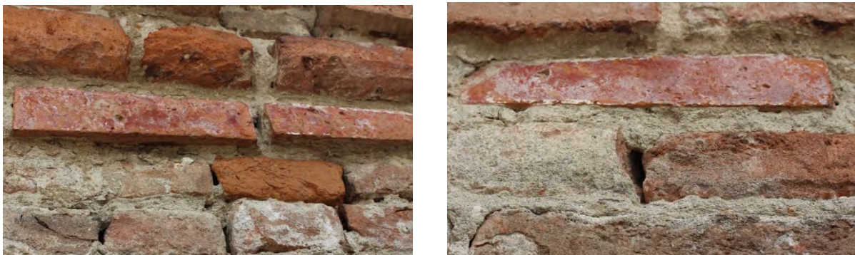
Chiesa di San Francesco: dettaglio della muratura del transetto
