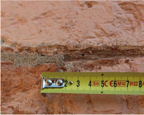
Dettaglio della finitura dei giunti rilevata sul prospetto principale della Basilica di Santa Maria in Vado
