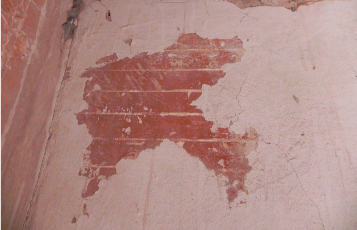
Traccia della finitura rilevata a Palazzo Tassoni
