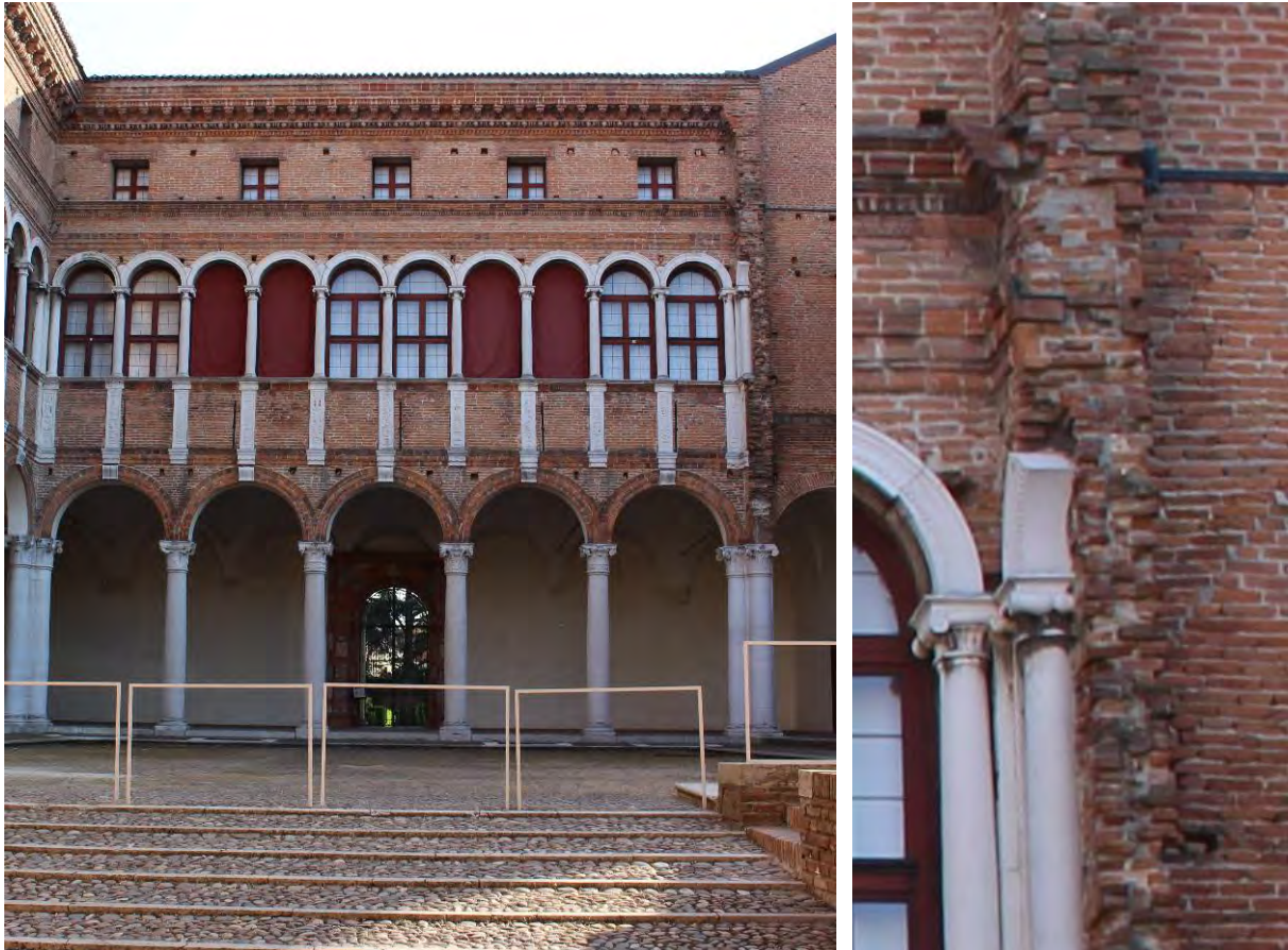
Vista della sezione muraria presente sul prospetto del cortile di Palazzo Costabili
