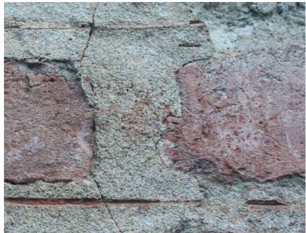
Dettaglio della finitura dei giunti rilevata sul prospetto Sud della Chiesa di San Francesco
