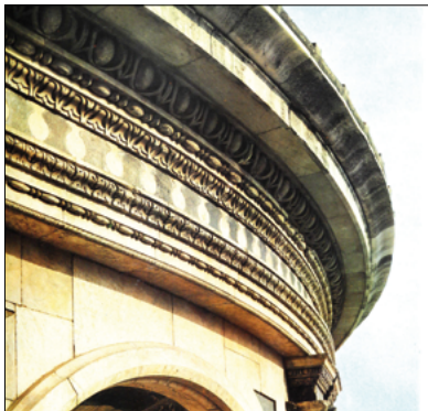
Filippo Brunelleschi, Architrave a conci dentati, tribune morte di S. Maria del Fiore, Firenze 1438
