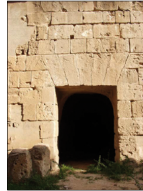
Piattabanda a conci dentati, entrata orientale dell'Anfiteatro di Sabratha, Libia, II secolo d.C.
