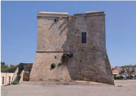
Fig. 3- Torre di S. Pietro in Bevagna. Esterno ripreso da sud (Foto. L. Pentasuglia).
