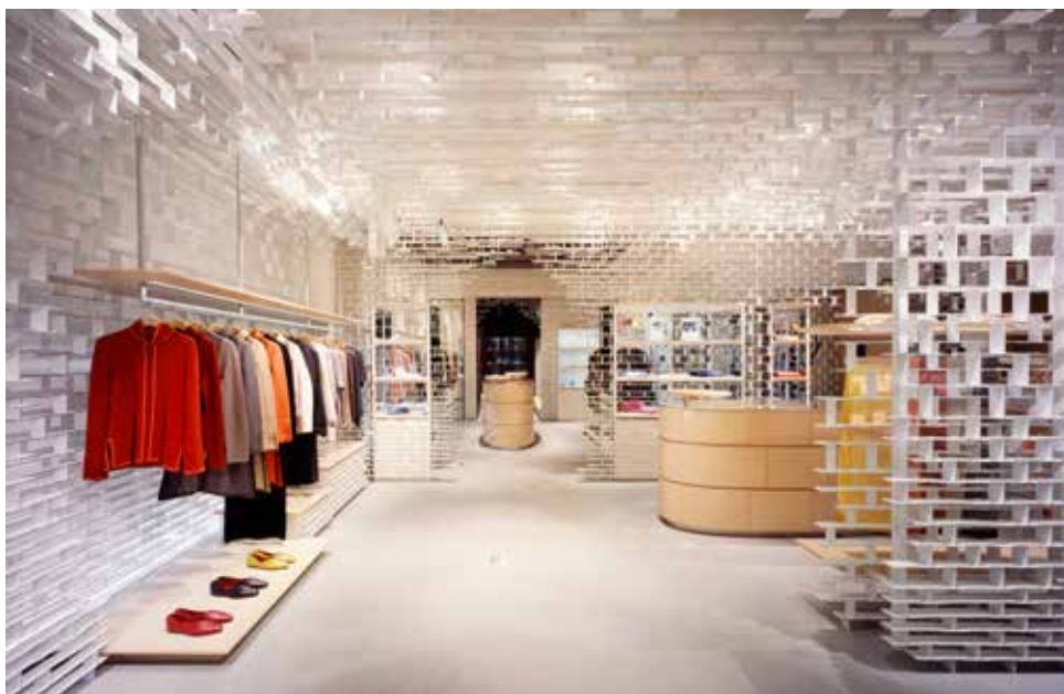
▲ ShangXia Pechino/Beijing: l'interno del negozio è realizzato impilando moduli di alluminio estruso / the shop's interior results from stacked extruded aluminum modules
