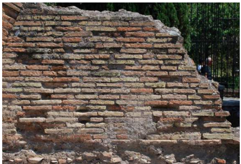
Fig. 9 - Esempio di muratura del complesso severiano (Area IV).
