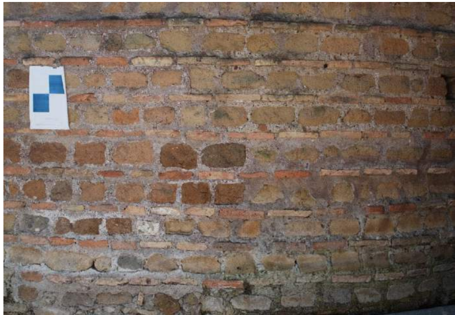
Fig. 12 - Esempio di muratura di età tardoantica del balneum.
