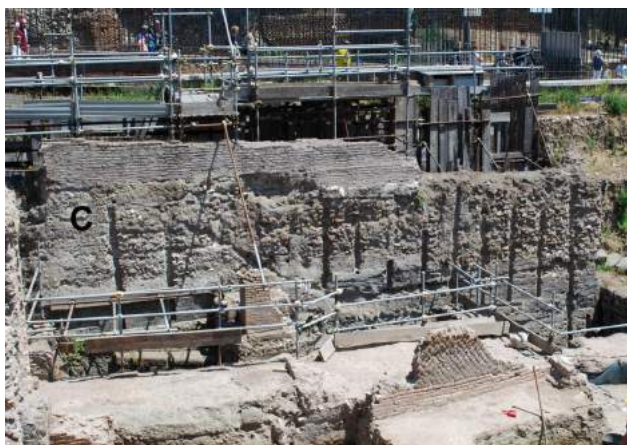
Fig. 25 - La fondazione neroniana del portico meridionale dell'Area II (C).
