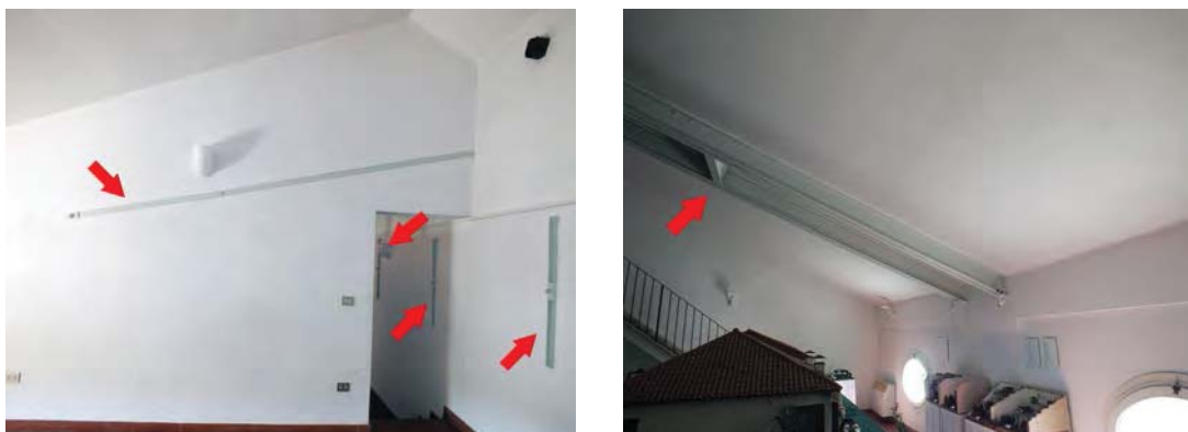
Fig. 6.26. Due differenti interventi di consolidamento murario.
