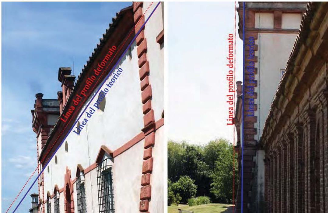
Fig. 6.23. Due fotografie della facciata Ovest (sinistra) e Est (destra) con linee rosse di riferimento che evidenziano le distorsioni delle facciate.
