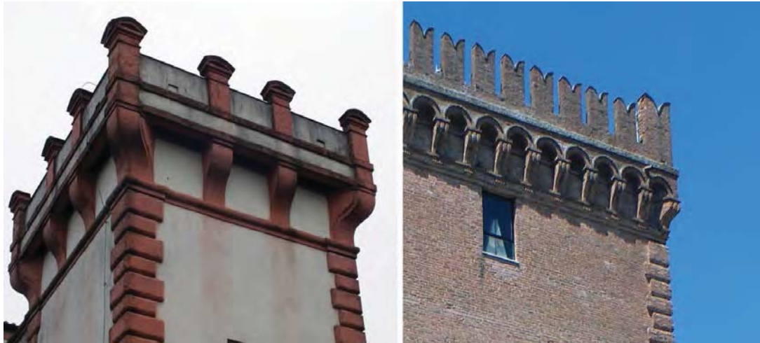
Fig. 6.19. Fotografie della Torre di Copparo. A sinistra il bugnato d'angolo, a destra le volute superiori di supporto alla merlatura.
