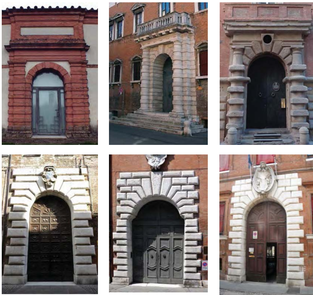
Fig. 6.18. In alto a sinistra il portale della facciata Est della Delizia e due esempi simili per struttura e finalità, in basso invece vengono ripresi alcuni esempi di portali bugnati piatti con una struttura simile a quella della facciata Ovest della Villa.
