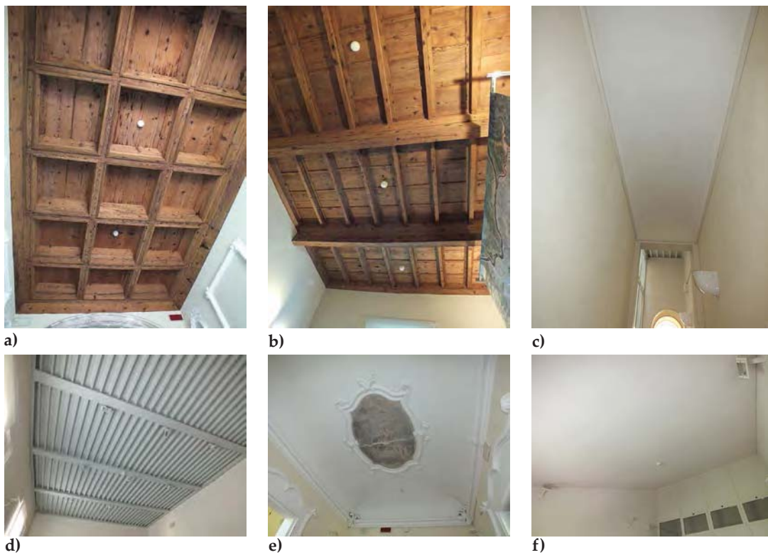
Fig. 6.29. Campionamento tipologico di alcuni solai presenti nella Villa: solaio ligneo originale (a), solaio ligneo ricostruito (b), solaio in latero-cemento (c), solaio in lamiera e calcestruzzo (d), solaio in arellato (e) e solaio in cartongesso (f).
