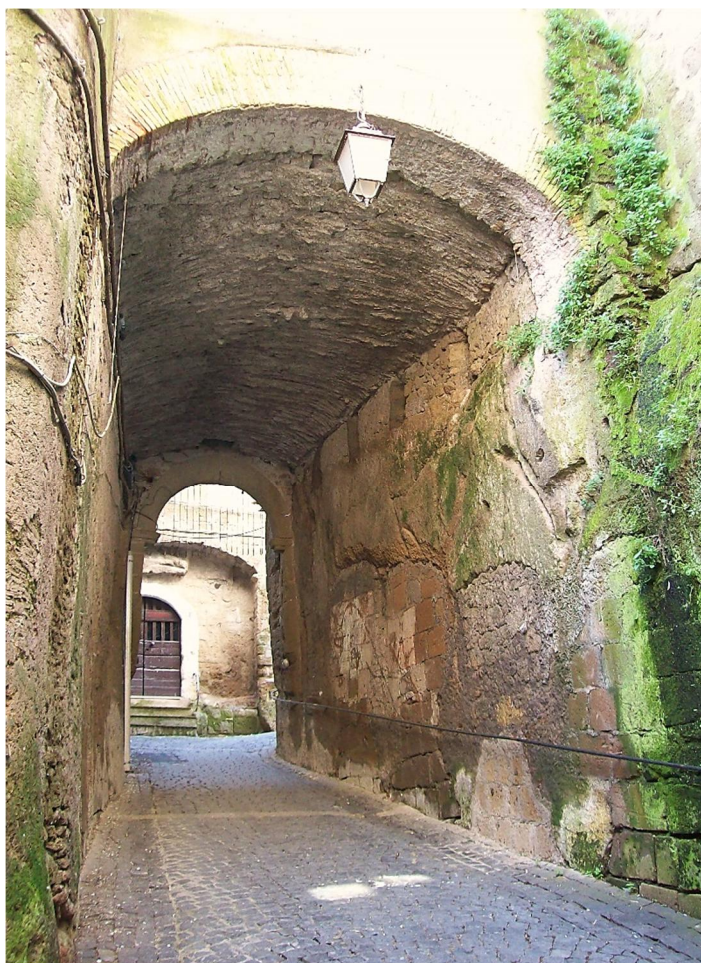
Fig. 8 – La 'bocchetta' di accesso al borgo (foto dell'A.)
