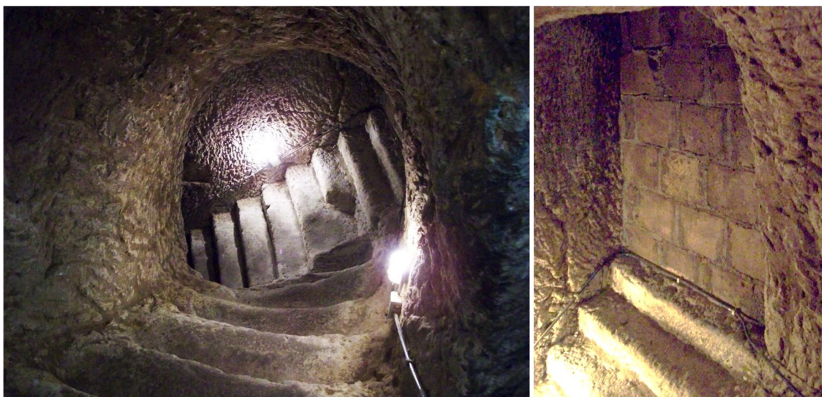
Figg. 6a e 6b – Una scala che conduce verso i vani ipogei ne intercetta un'altra, quasi ortogonale, che conduce agli stessi ambienti; il corridoio tufaceo attraversato da quest'ultima è a sua volta tamponato, a testimonianza di una parcellizzazione delle pertinenze sotterranee (foto dell'A.)
