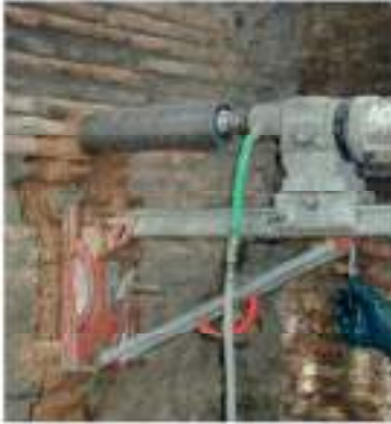
Macchinario per eseguire il carotaggio
