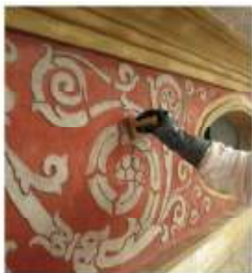
un particolare della fase di restauro delle decorazioni della facciata. Foto tratte da http://www.solarraum.it/consulting/energia/progetto-energia/villa-c-bellano-le-p132-46.html
