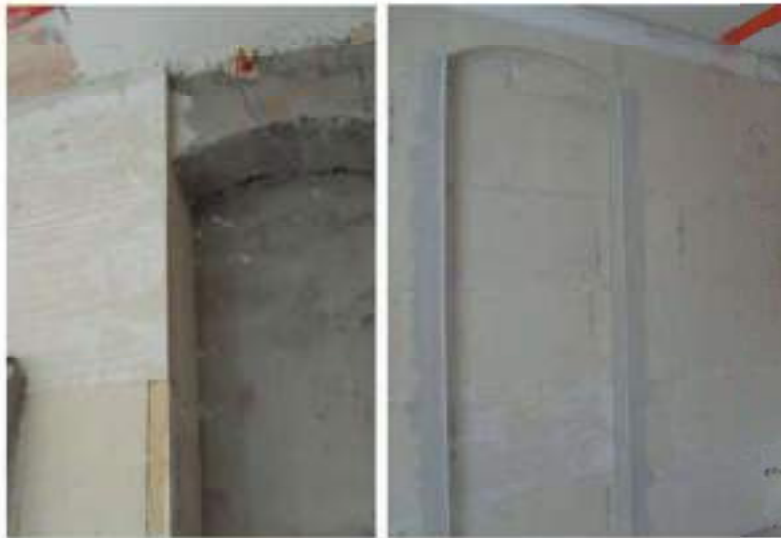
Durante e dopo l'installazione dei pannelli isolanti. Come si può vedere dalla foto, l'inserimento di uno strato di materiale modifica in parte la connotazione geometrica delle superfici, che in questo caso si riesce ancora a leggere anche se in modo diverso dall'originale.
