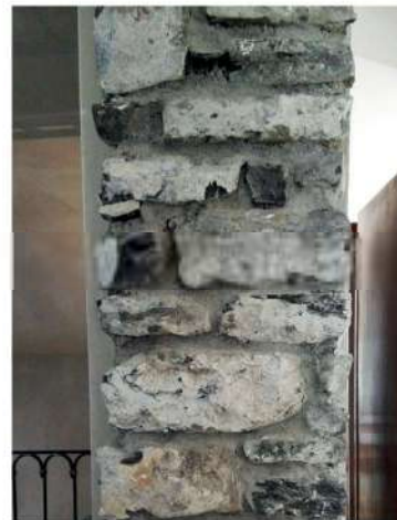
Esempio di sezione piena in marmo di Varenna.
