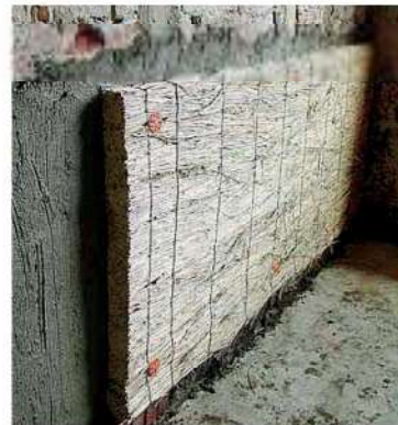
Pannello isolante in canne palustri derivato dai metodi di isolamento tradizionali.
