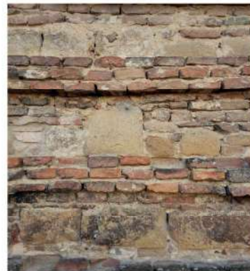
Esempio di muratura con ricorsi in laterizio
