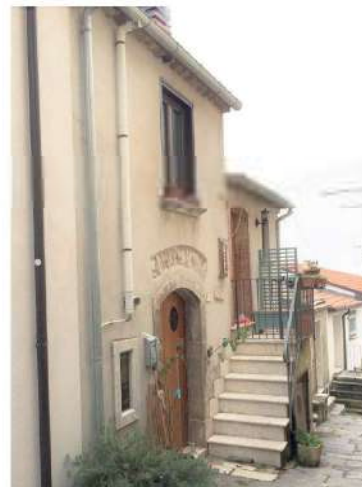
Casa Gioioso, prospetto rivolto ad ovest.
