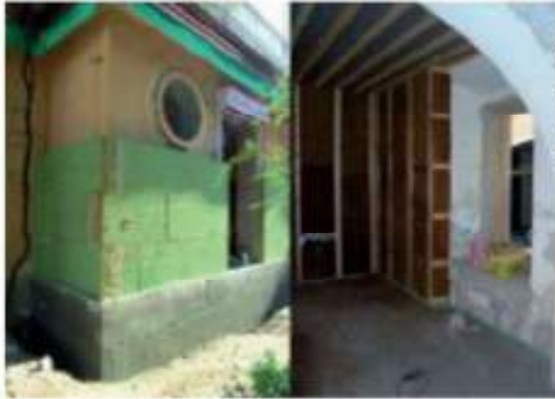
Applicazione del cappotto isolante esterno a sinistra e di quello interno a destra
