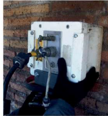
Esempio di georadar.
