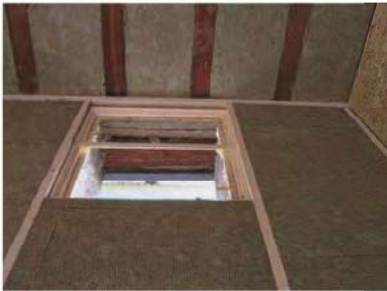
Applicazione dell'isolante interno
