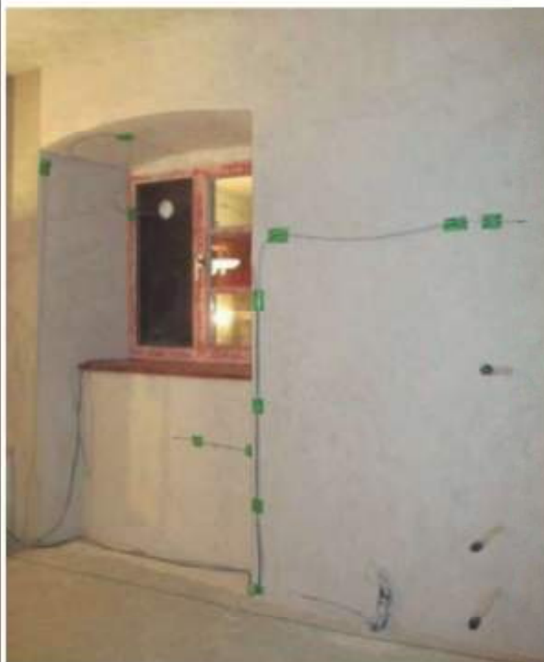
Nell'immagine possiamo vedere come si presenta la muratura dopo l'applicazione del prodotto e del sistema di monitoraggio che ne controlla il comportamento
