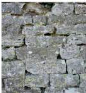
Esempio di muratura in pietra concia
