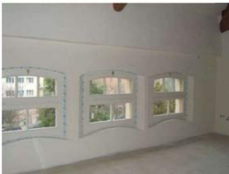
Sostituzione infissi e finitura superficiale delle pareti perimetrali
