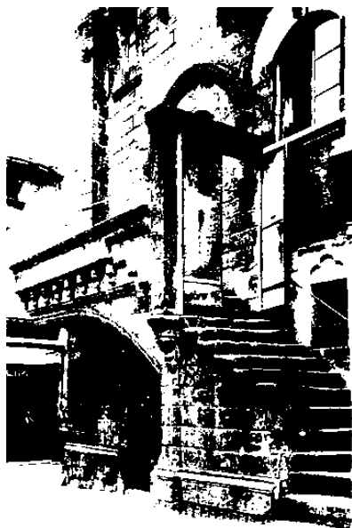
2. I restauri delle parti più deteriorate furono eseguiti a spese del comune nel 1903, dal valente scalpellatore Giovanni Nottola (fonte Cesare Pinzi).
