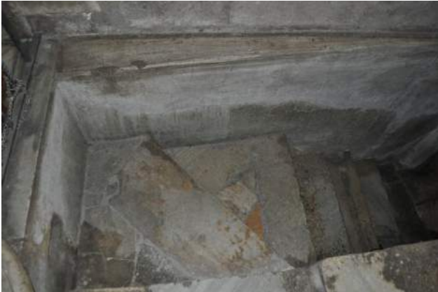
Fig. 45 – Scala sud d'accesso alla cripta
