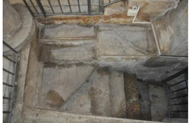
Fig. 46 – Scala nord d'accesso alla cripta
