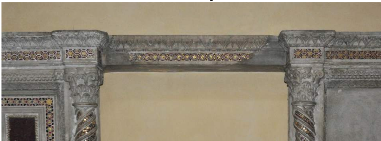
Fig. 29 – Dettaglio delle modanature e delle decorazioni musive di cornici e architrave
