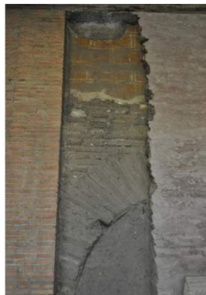
Fig. 40 – L'intonaco a falsa cortina sulla facciata della basilica
