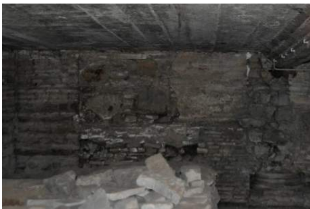
Fig. 25 – Tamponatura dell'arcata sud del triforio
