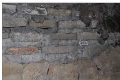
11E.17_02 - dettaglio prima del prelievo
