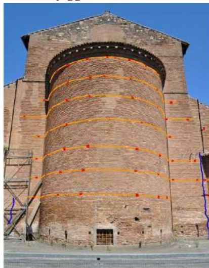
Fig. 11 — Analisi dei caratteri costruttivi : la navata centrale
