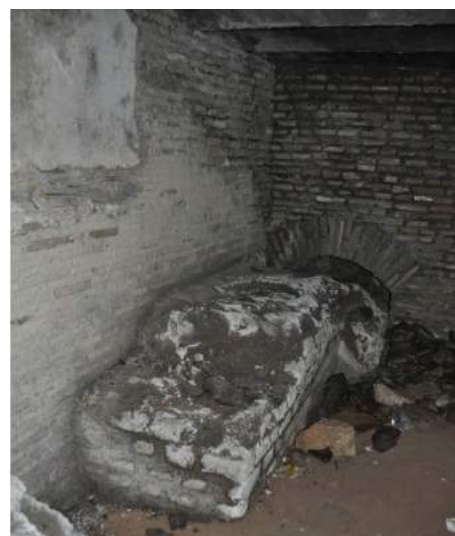
Fig. 21 – Pareti nord e est di 'A': a destra la muratura in laterizi analoga a quella della parete nord dell'aula e a sinistra il muro dei primi del Novecento
