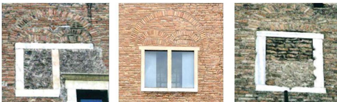
Fig. 32 – Finestre con archi di scarico multipli nella galleria di S. Saba, dei Ss. Giovanni e Paolo e nella Torre maggiore del complesso dei Ss. Quattro Coronati (Montelli 2011)
