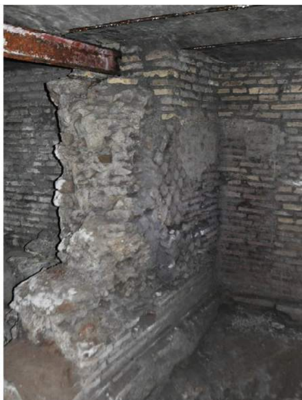
Fig. 25 – Angolo sud-ovest del vano ‘B’: al centro lacerti di muratura in opus reticulatum
