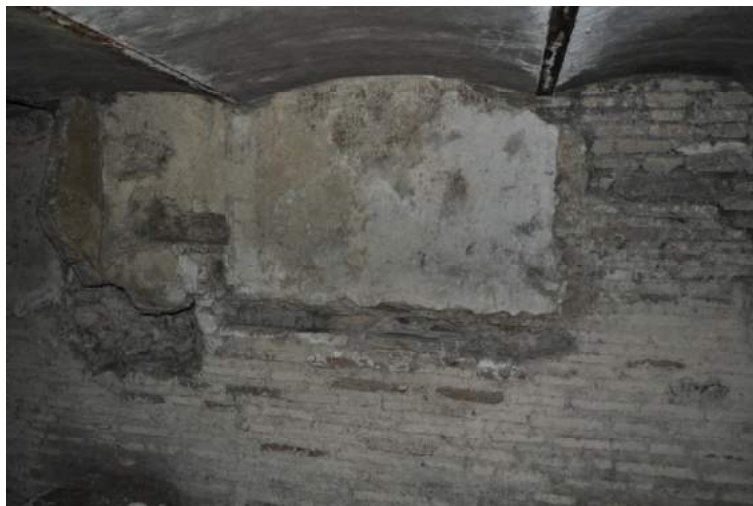
Fig. 33 – Parete nord del vano 'A': frammento marmoreo e cavità per l'alloggiamento del gradino e del pavimento
