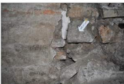
11aW.07_04 - dettaglio dopo il prelievo
