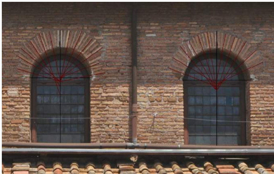
Fig. 8 – Analisi delle giaciture dei laterizi nelle ghiera del cleristorio sud
