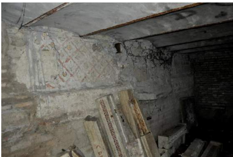
Fig. 32 – Dipinti sulla parete sud del vano 'A'
