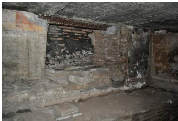
Fig. 26 – Tamponatura dell'arcata nord del triforio
