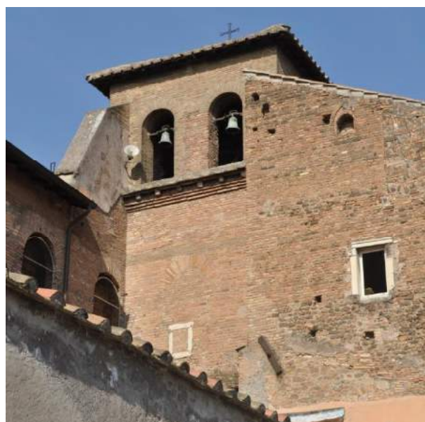
Fig. 11 – Il campanile (lato est)
