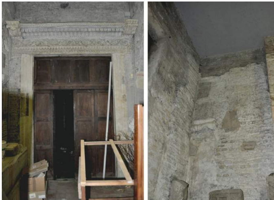
Figg. 20 e 21 – Il portale laterale della basilica e il capitello del protiro inglobato nel muro di separazione fra i vani del museo
