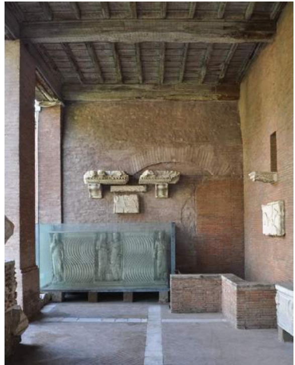
Fig. 34 – Archivolto sul lato nord del portico
