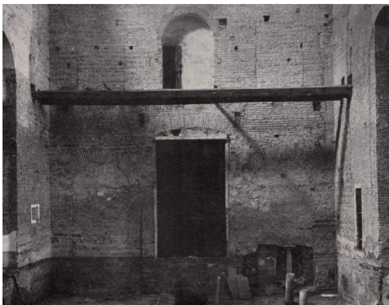
Fig. 5 – Resti della facciata dell'aula durante gli scavi di inizio Novecento (Krautheimer 1937-'80, vol. IV)
