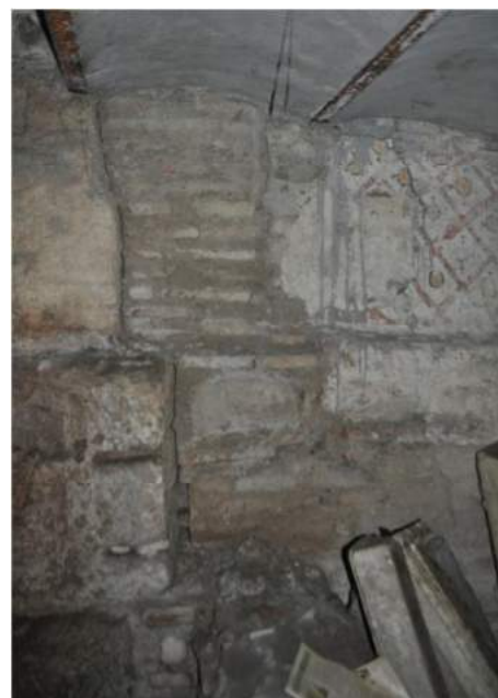
Fig. 20 – Parete sud di 'A': a destra la muratura in opera listata dell'aula e a sinistra le fondazioni in travertino della basilica
