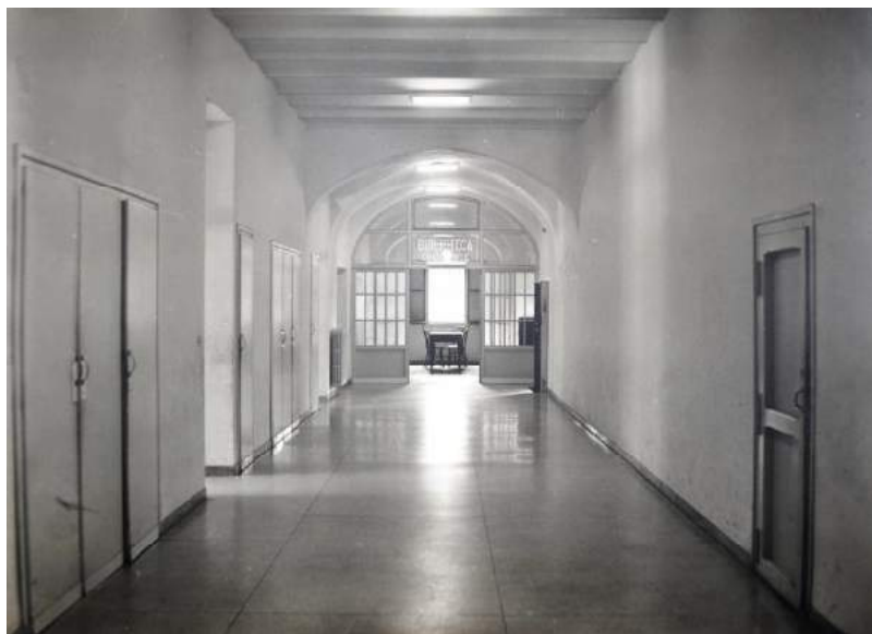
Fig. 2 – Il braccio medievale attiguo alla chiesa dopo le trasformazioni degli anni Cinquanta
