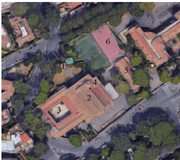
Fig. 2 – Foto zenitale del complesso 1) ingresso principale 2) basilica 3) casa parrocchiale 4) edificio a nord della basilica 5) centro Astalli 6) attrezzature sportive
