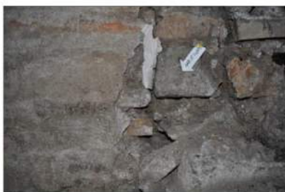
11aW.07_04 - dettaglio dopo il prelievo
