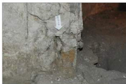
21E.16_02 - dettaglio prima del prelievo
