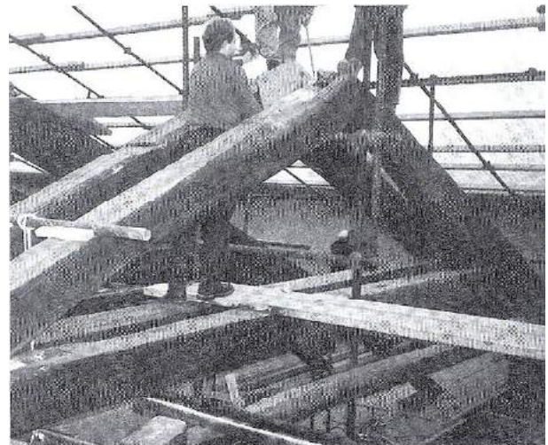
Fig. 6 –S. Pietro in Vincoli: foto di una capriata durante i lavori di restauro (Brandenburg et al. 2002)
