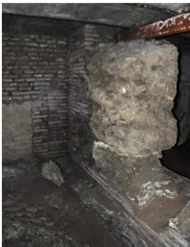
Fig. 24 – Angolo sud-est del vano ‘B’: a destra è la porta di collegamento al vano ‘A’
