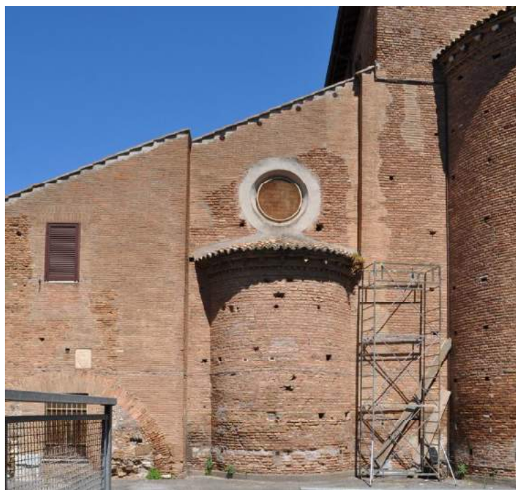
Fig. 15 – Reintegrazioni in laterizi degli anni Trenta sul prospetto posteriore della basilica
