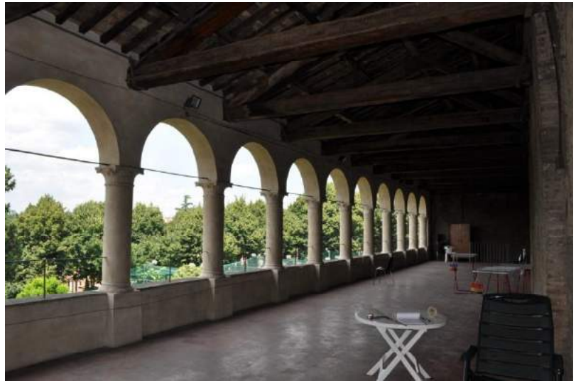
Fig. 7 – La loggia di S. Saba
