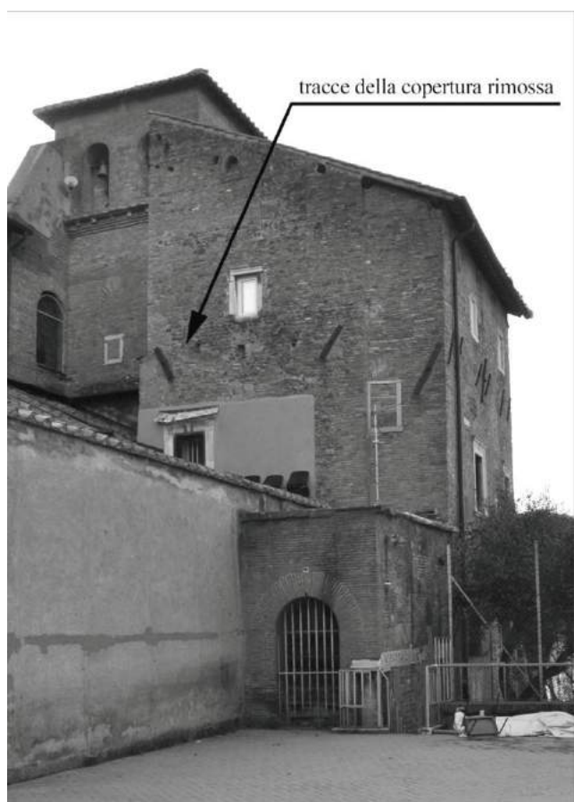
Fig. 7 – Tracce della copertura rimossa sull'edificio a nord della basilica
