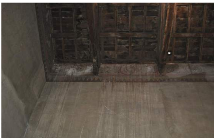
Fig. 12 – Fenomeni di degrado degli affreschi e degli intonaci nella navata sinistra
