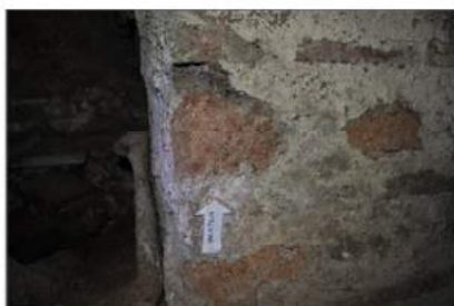
T1.19_03 - dettaglio dopo il prelievo
