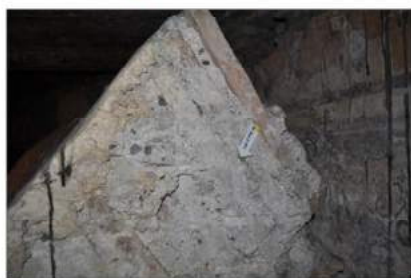
19E.10_03 - dettaglio prima del prelievo
