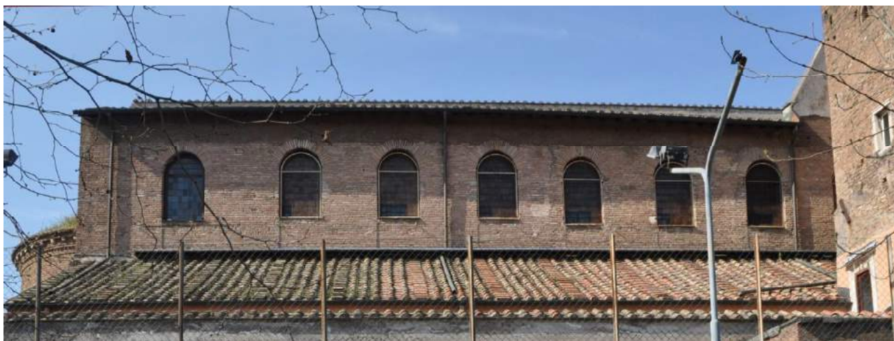
Fig. 7 – Le finestre del cleristorio settentrionale: sopra le arcate è evidente la soprelevazioni quattrocentesca
