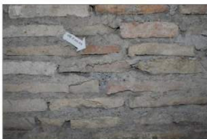
1M.14_03 - dettaglio dopo il prelievo
