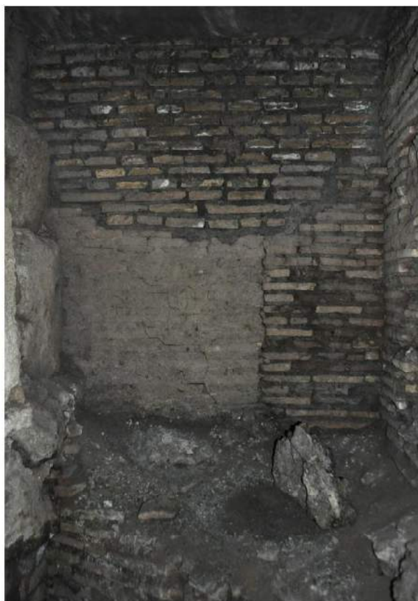
Fig. 23 – Parete est di ‘B’: nell’angolo in basso a sinistra è la muratura di tipo M3
