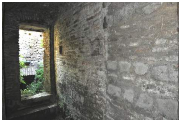
Fig. 35 – Paramento interno dei bracci obliqui; al centro è la discontinuità costruttiva fra l'emiciclo e l'ambulacro
