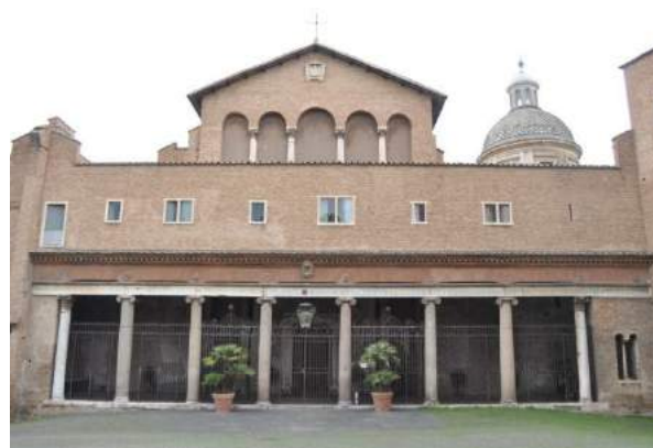
Fig. 31 – Il portico e la galleria della basilica dei Ss. Giovanni e Paolo
