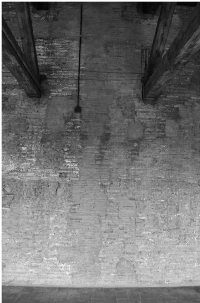
Fig. 16 – Reintegrazione muraria in corrispondenza del muro nord della navata centrale al livello della loggia
