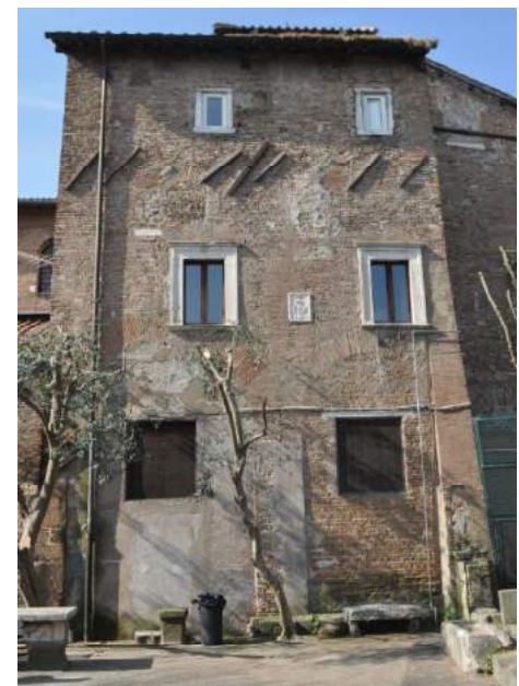
Fig. 15 – Edificio attiguo al fianco nord
