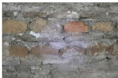
5E.13_02 - dettaglio prima del prelievo
