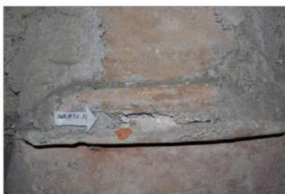
T2.21_03 - dettaglio dopo il prelievo
