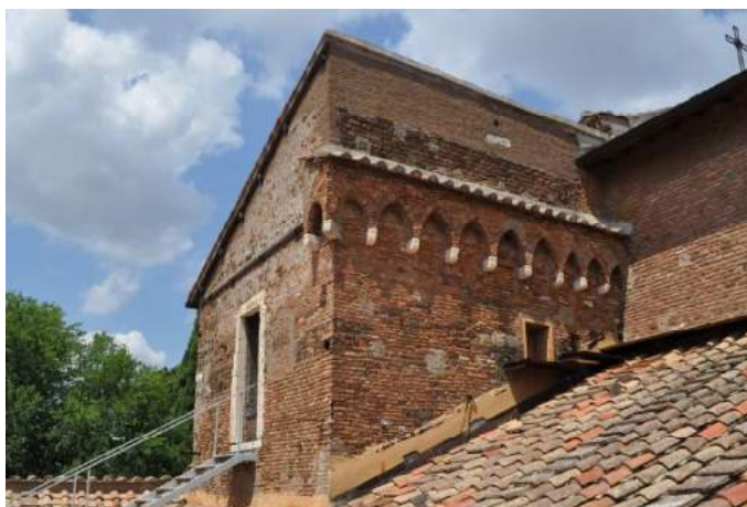
Fig. 41 – Motivo decorativo ad archi intrecciati sul corpo di fabbrica addossato alla facciata
