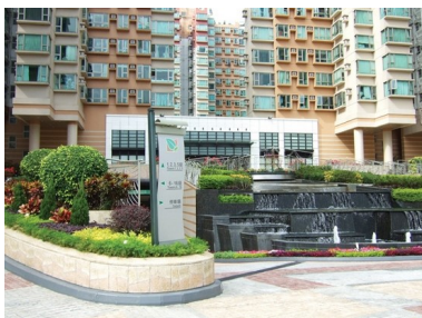
Atrio d'accesso agli edifici con fontana
