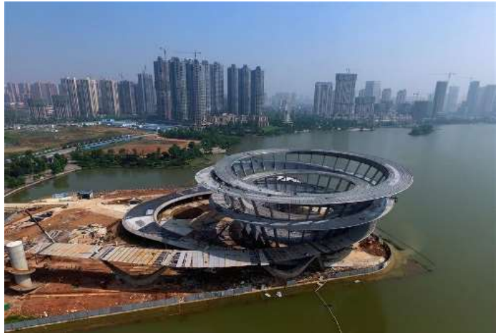
Immagine del sito in costruzione e del lago artificiale
