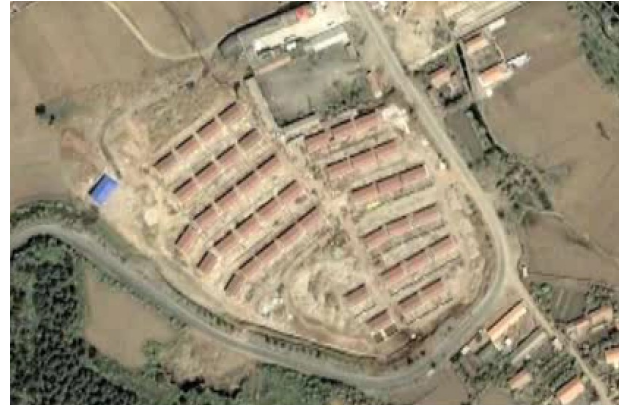
Area realizzata ad oggi
