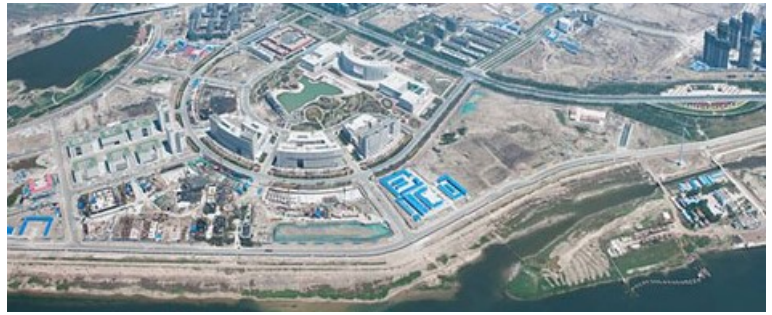
Immagini dei lavori di realizzazione dell'intervento
