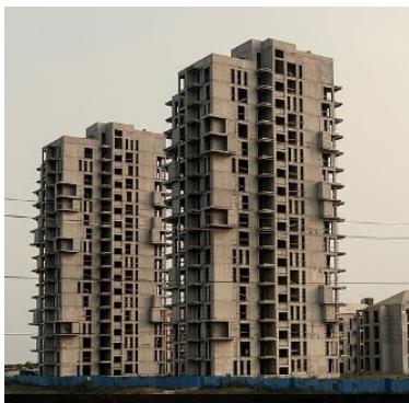
Orange Glow Waterfront in costruzione
