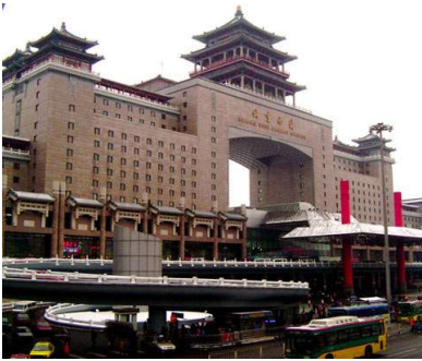
Figura 29 Stazione ferroviaria di Pechino Ovest
