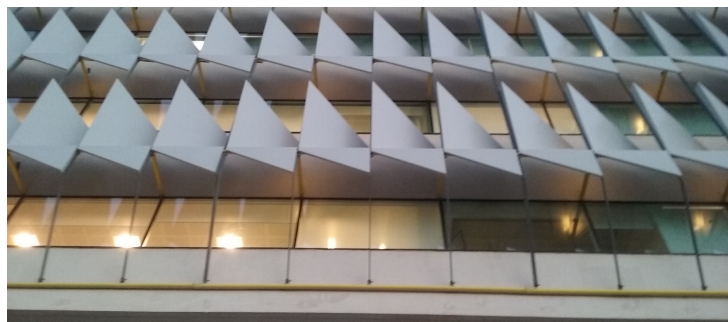
Pannelli di rivestimento per la protezione passiva dell'edificio del Siemens HQ
