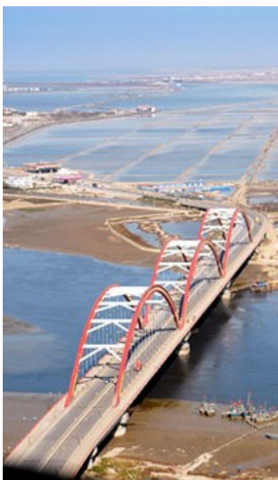
Area di intervento ante-operam
