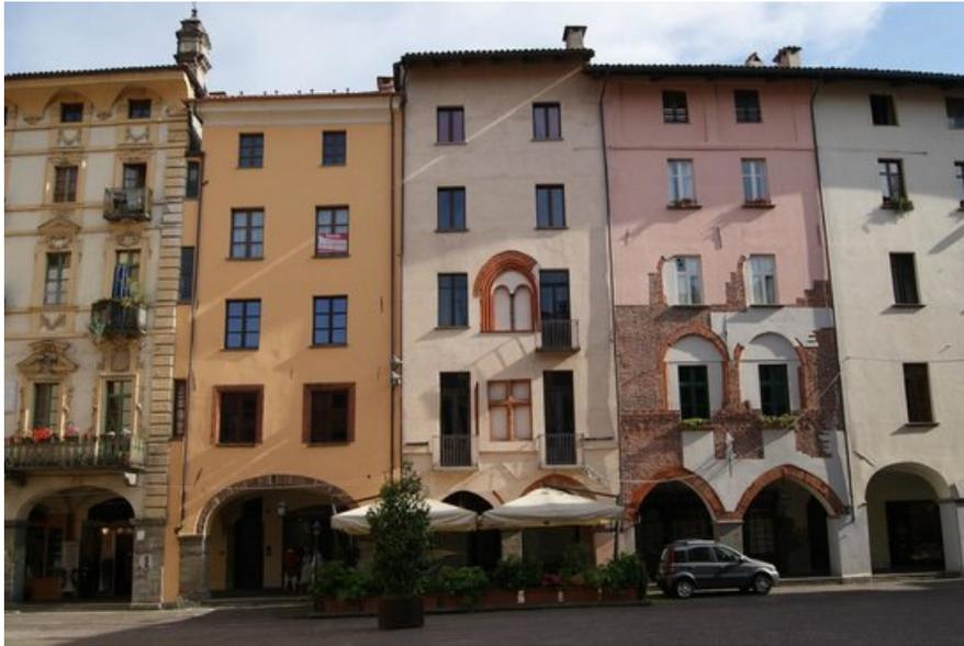
*Figura 3. Esempio di Unità strutturali appartenenti ad un aggregato*
