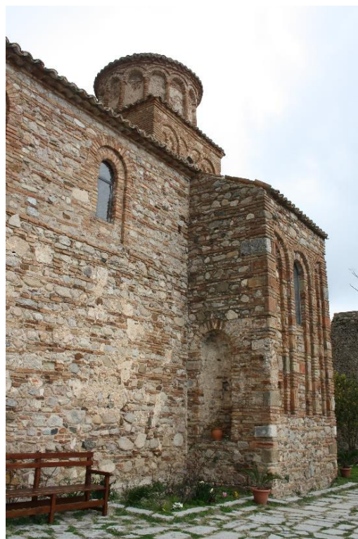
6. Angolo tra transetto e fiancata Sud
