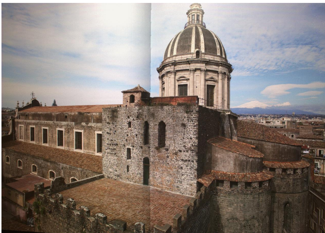
18. Vista aerea da Sudest. In primo piano la testata del transetto destro e la terrazza sopra la cappella della Vergine (da La cattedrale di Catania 2009)
