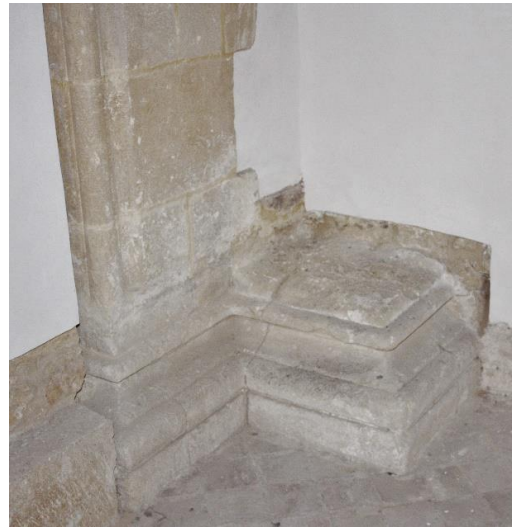
26. Resti del pilastro dell'arco d'accesso alla cappella eretta nell'angolo esterno Sudovest (XV-XVI sec.)
