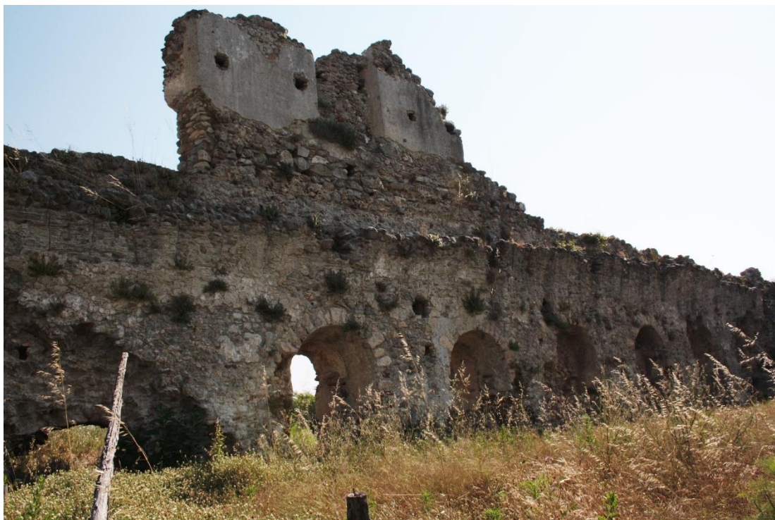
5. Muro perimetrale Sud, lato interno
