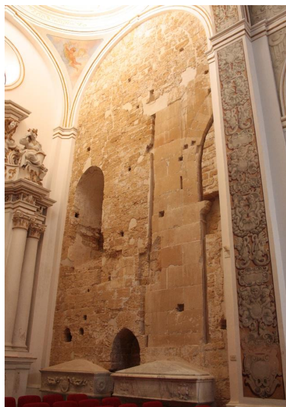
15. Transetto Sud, parete Ovest con l'arco d'accesso all'ambiente eretto nell'angolo esterno (XV-XVI sec.)
