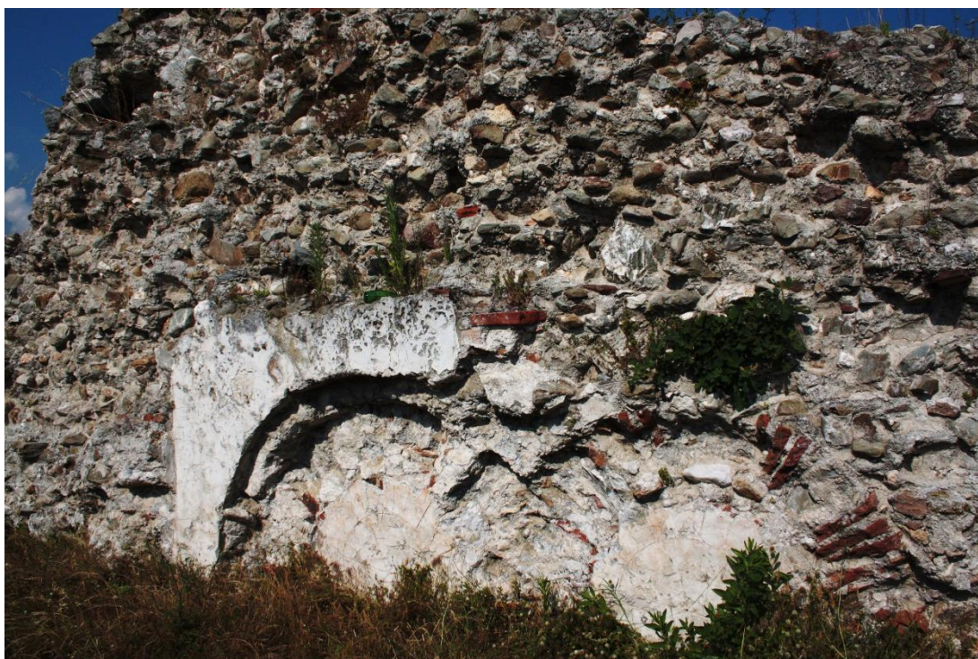
6. Facciata, dettaglio delle arcate cieche
