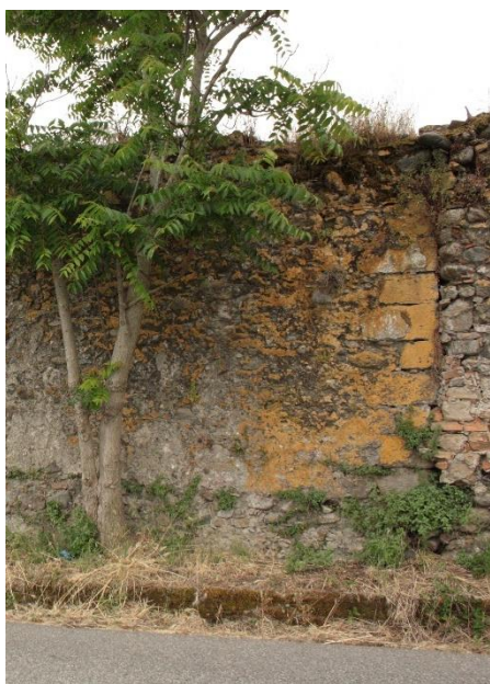
7. L'attuale muro di recinzione Nord, lato esterno, angolo occidentale
