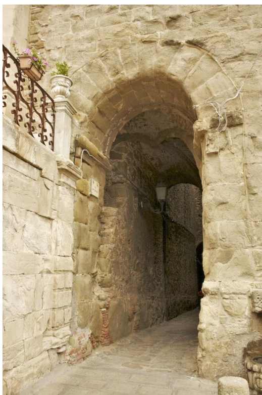
12. Il vano al piede del campanile, visto dalla piazza
