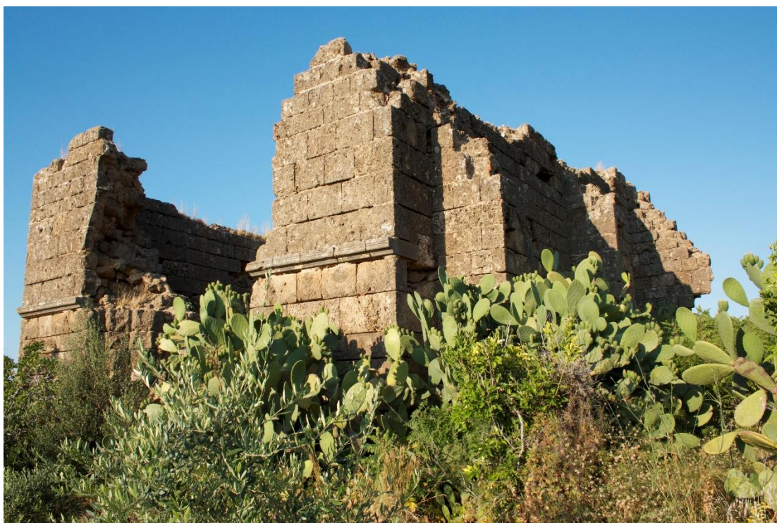
2. Facciata e fianco meridionale
