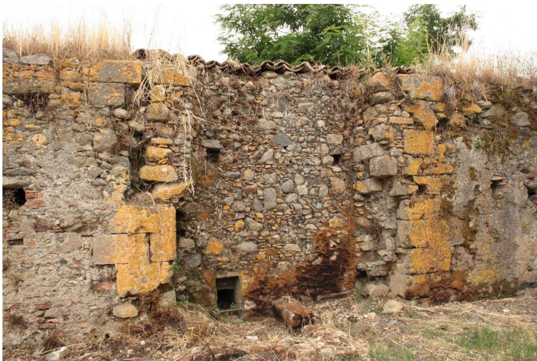
9. L'attuale muro di recinzione Ovest, già facciata della chiesa, portale
