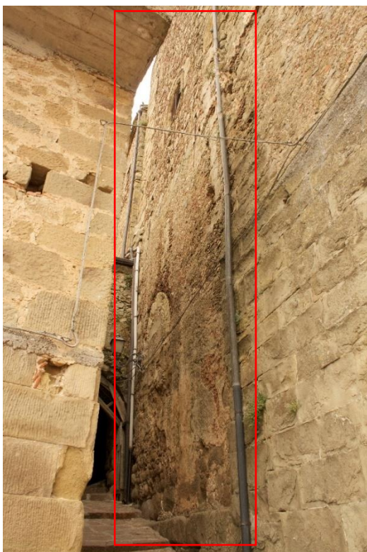
10. Testata del transetto Sud, prospettante nel vicolo che fiancheggia la cattedrale
