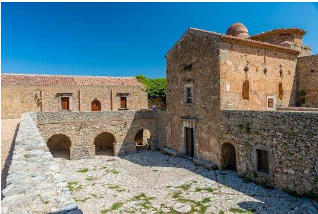
4. Chiesa abbaziale, vista da Sudovest
