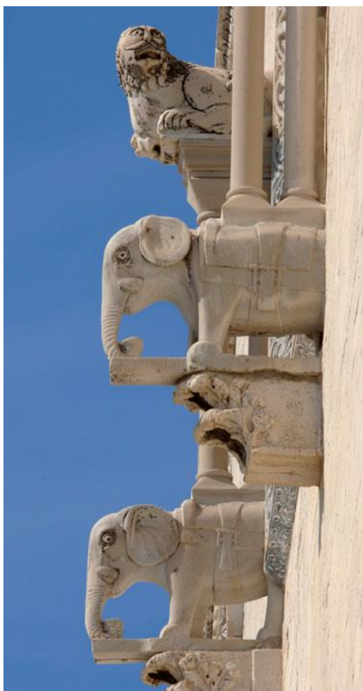
29. Trani, cattedrale, finestra di facciata, dettaglio delle mensole (da CALÒ 2015)
