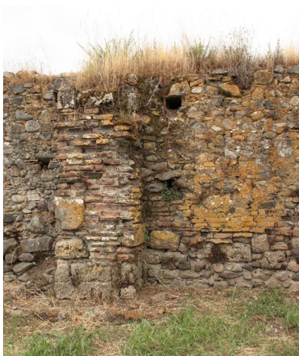
10. L'attuale muro di recinzione Ovest, già facciata della chiesa, semipilastro
