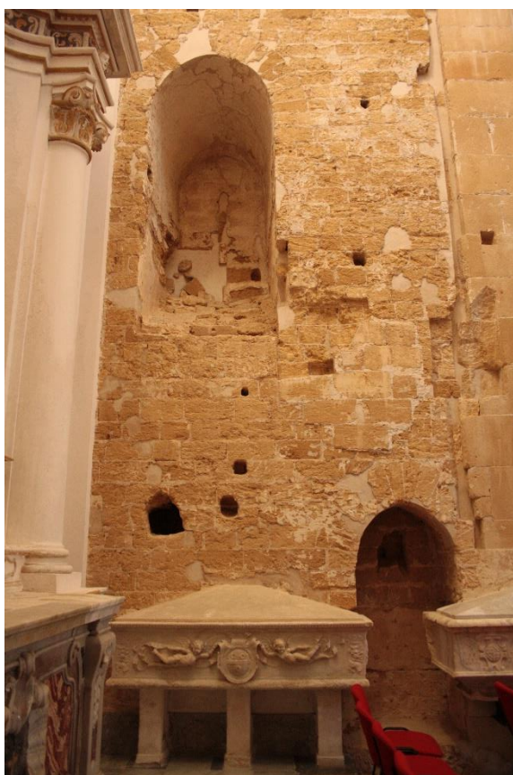
16. Transetto Sud, parete Ovest, dettaglio delle aperture
