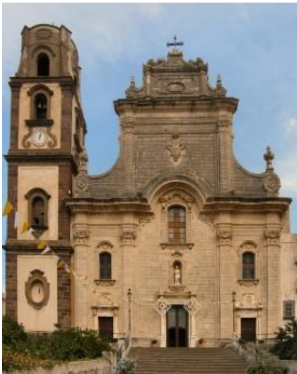
10. Facciata e campanile
