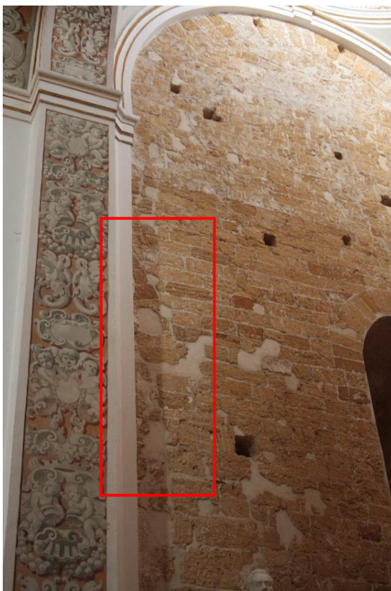
20. Transetto Sud, parete Est, resti dell'arco dell'abside destra
