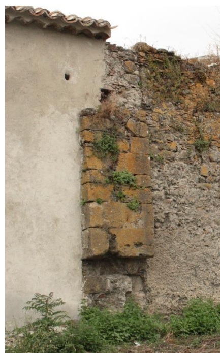
11. L'attuale muro di recinzione Nord, lato esterno, angolo orientale
