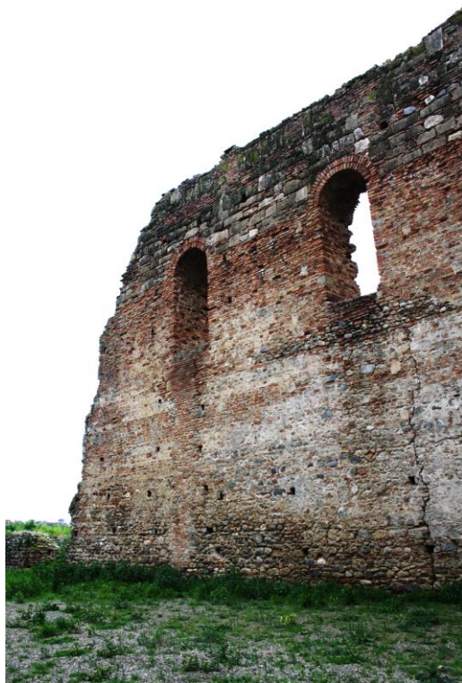
10. Perimetrale Sud di navata, interno
