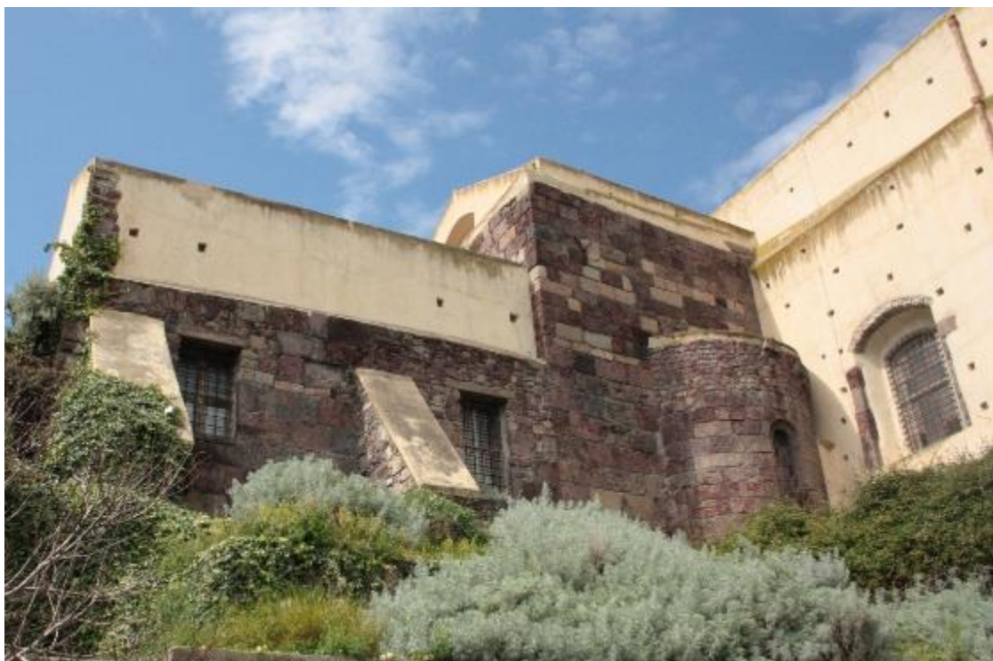
12. Fronte orientale della cappella del SS. Sacramento (a sinistra) e del transetto Sud con relativa absidiola (a destra)
