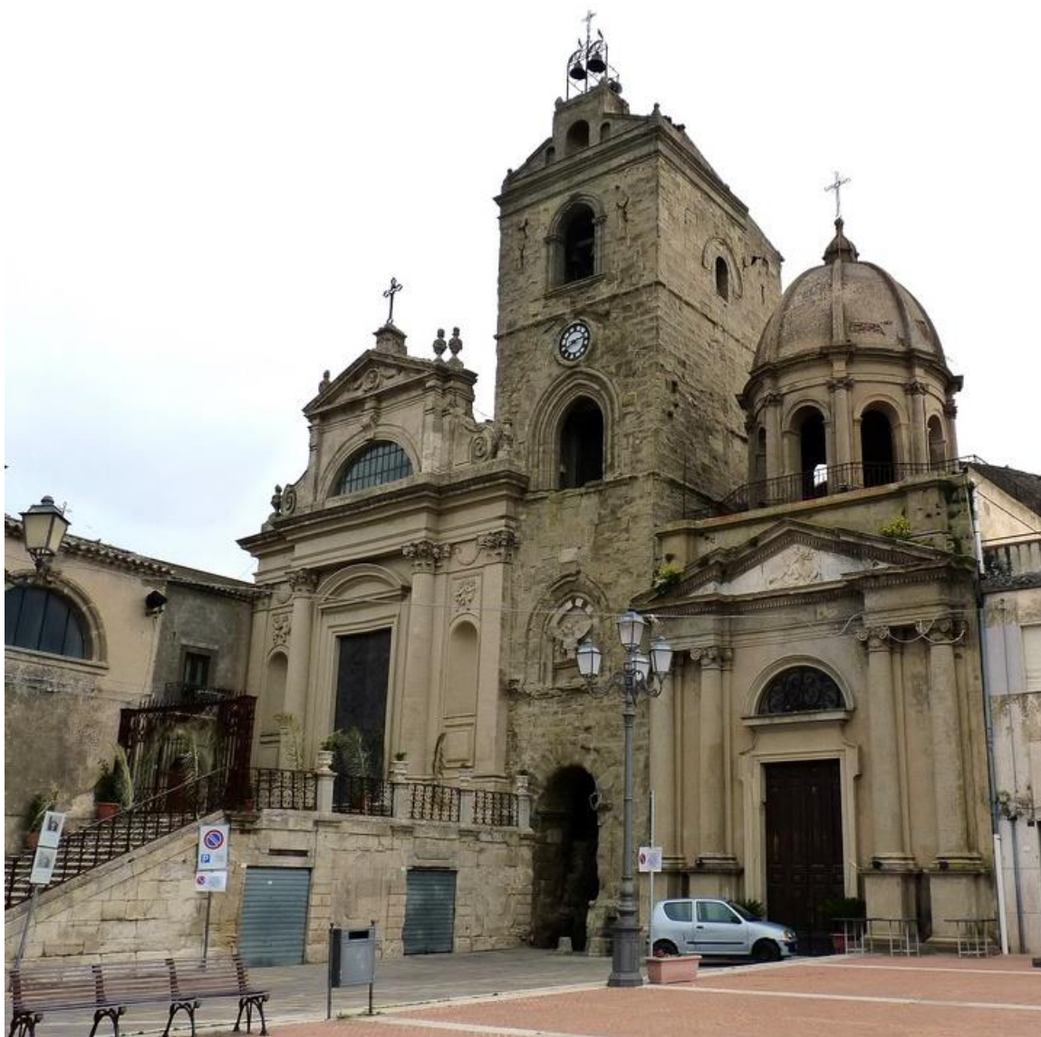
7. Facciata e torre campanaria da piazza Conte Ruggero
