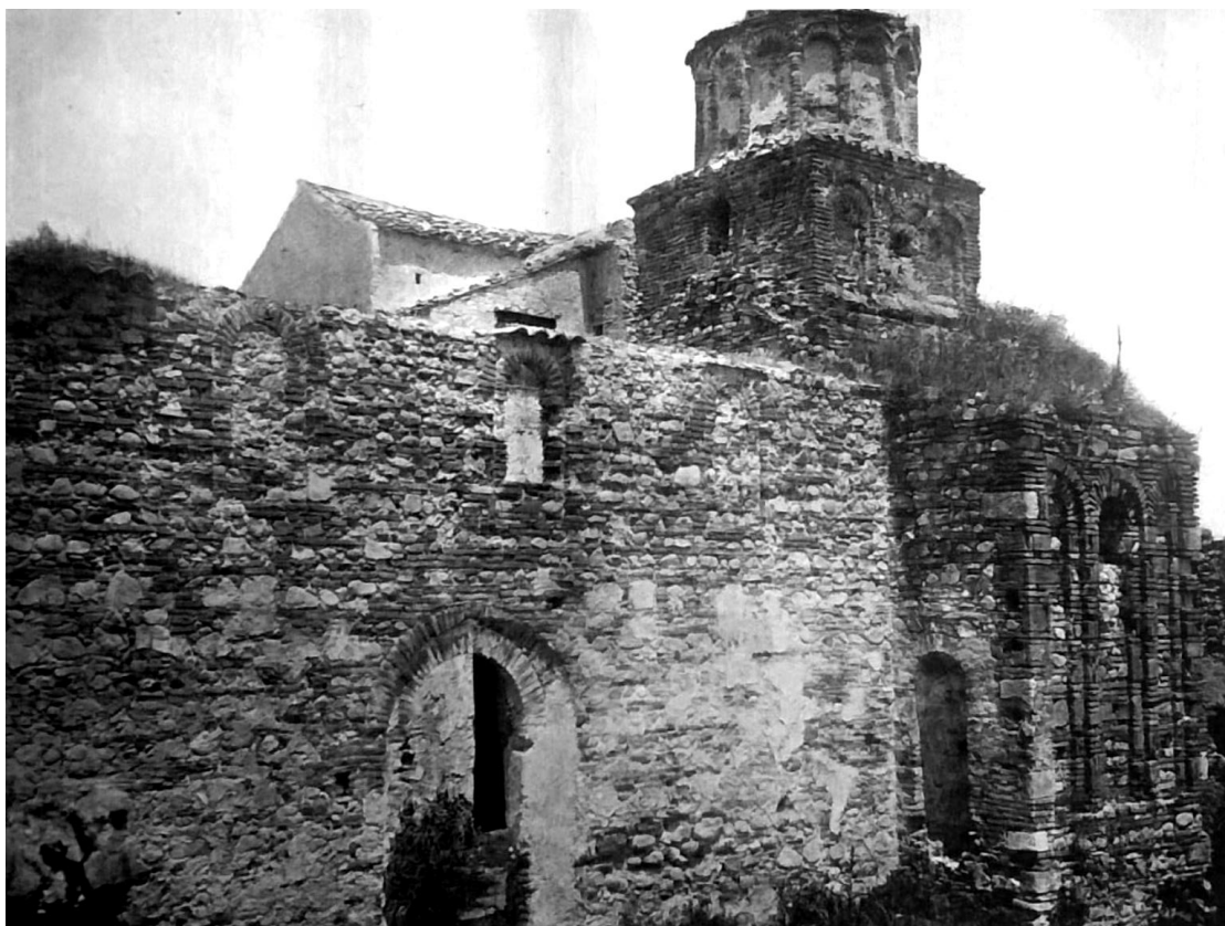
3. La chiesa prima dei restauri (da ORSI 1929)
