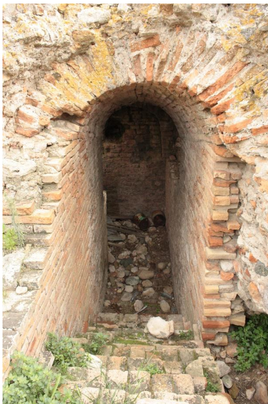
12. Ingresso settentrionale della cripta
