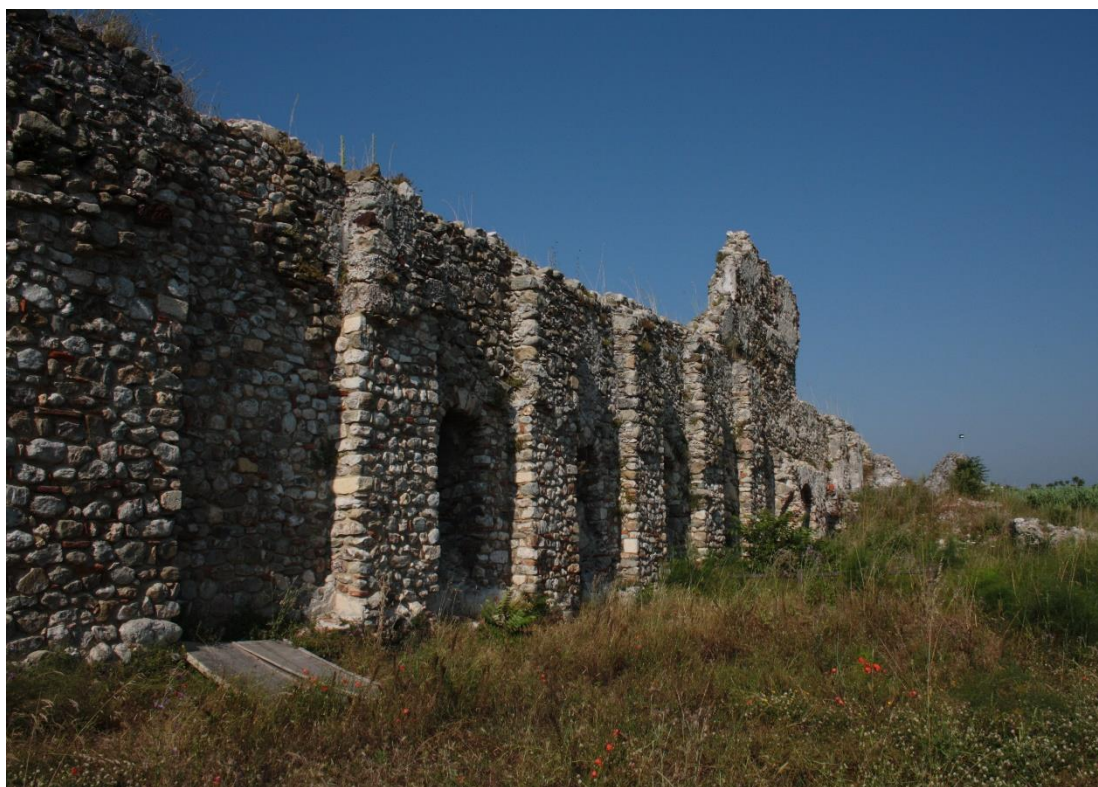
4. Muro perimetrale Sud, lato esterno
