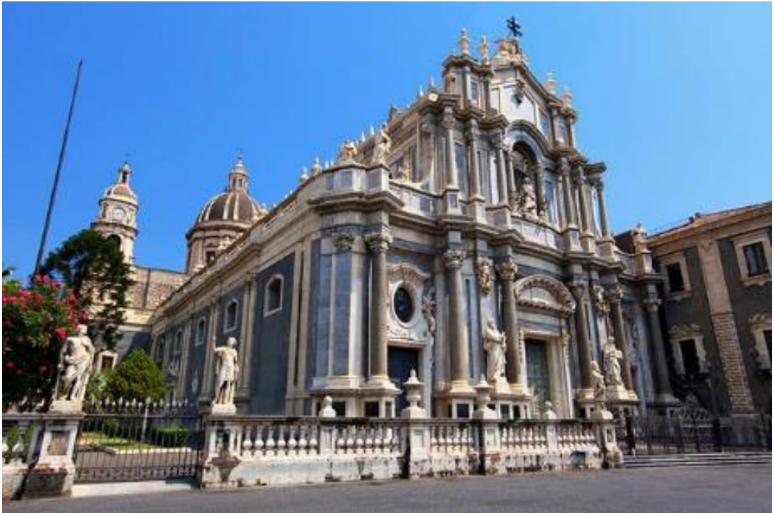
13. Facciata e fianco Nord
