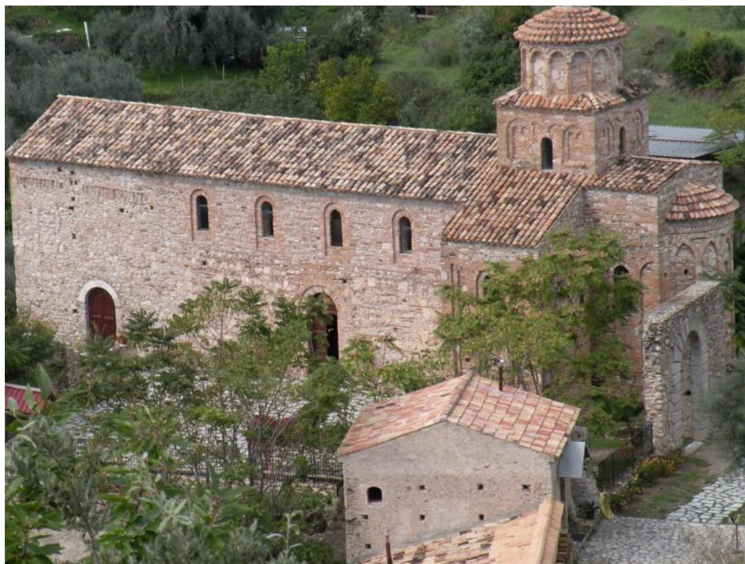
4. Veduta aerea della chiesa dopo i restauri
