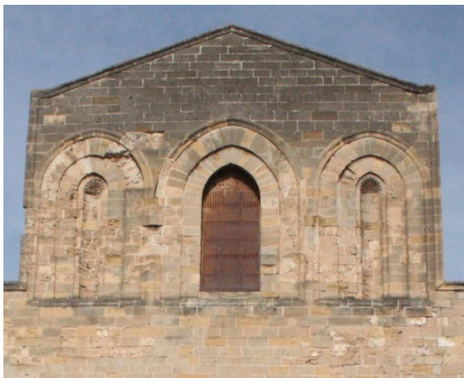
5. Palermo, SS. Trinità della Magione, facciata, dettaglio dell'attico
