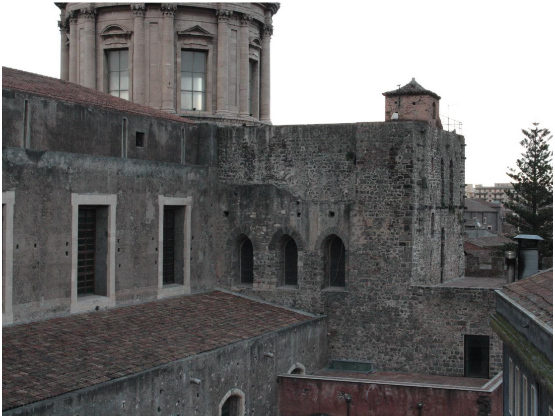
19. La fiancata e il transetto Sud visti da Sudovest
