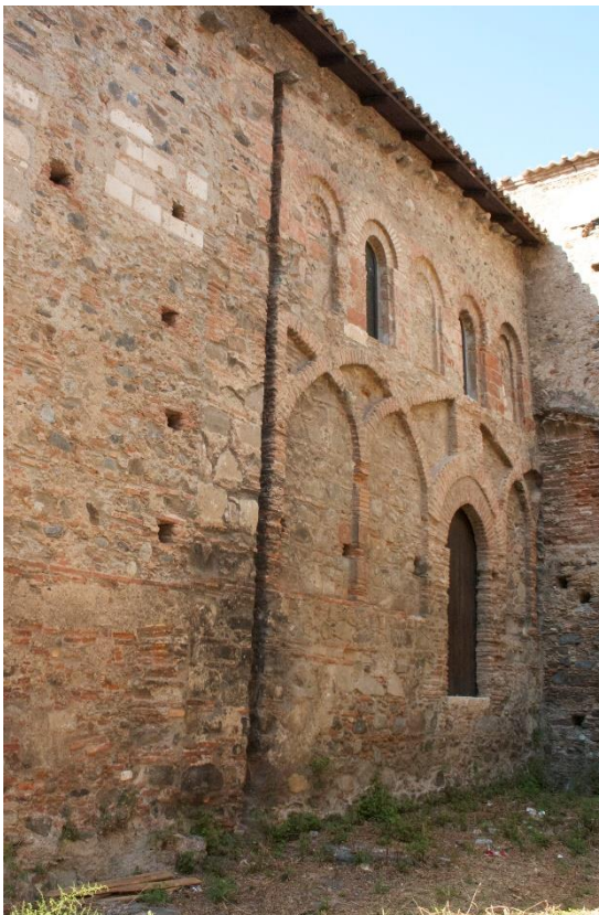
6. Fiancata Sud, giunzione tra muratura di età normanna (destra) e prolungamento moderno (sinistra)
