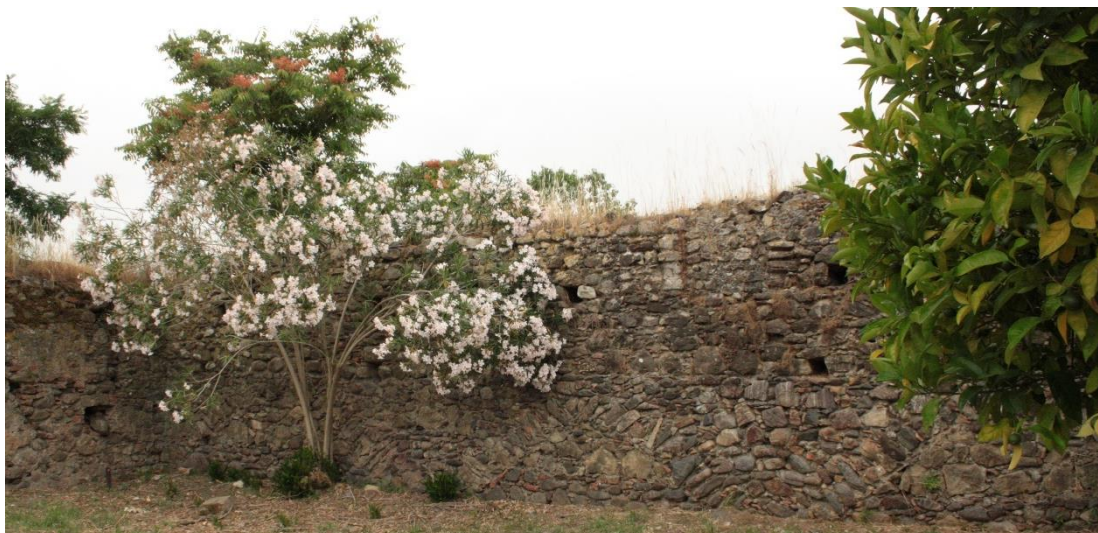
5. L'attuale muro di recinzione Nord, già fiancata sinistra della chiesa, lato interno, porzione occidentale
