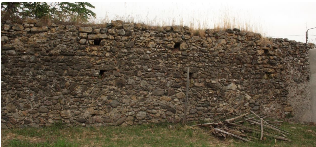
6. L'attuale muro di recinzione Nord, già fiancata sinistra della chiesa, lato interno, porzione orientale
