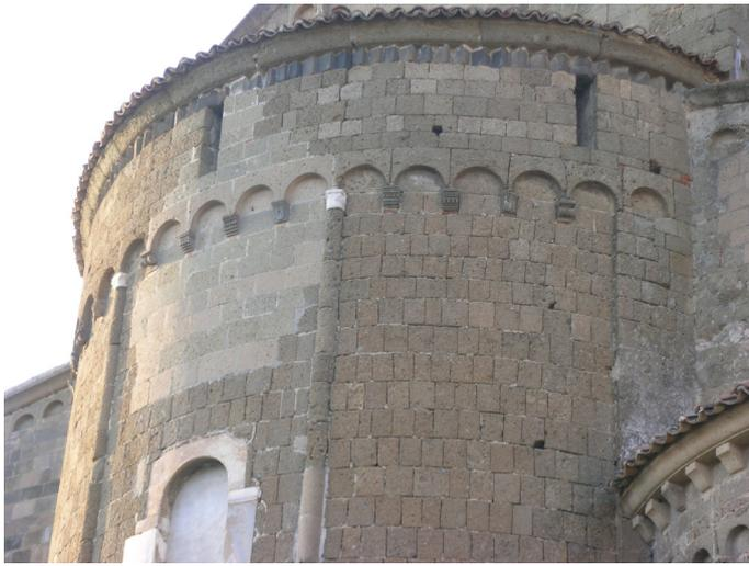
Fig. 4. Sessa Aurunca, duomo. La lettura della stratigrafia muraria è uno dei principali strumenti di indagine delle fasi di trasformazione di un edificio, la sua rappresentazione informatica tuttavia richiede una ricchezza semantica di cui le correnti applicazioni non dispongono.
