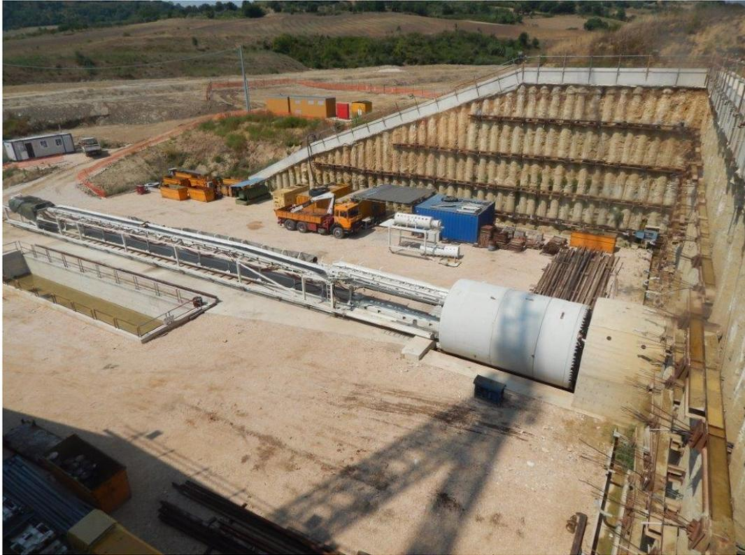
Figura 5.8: Paratia di imbocco e back-up della TBM.
