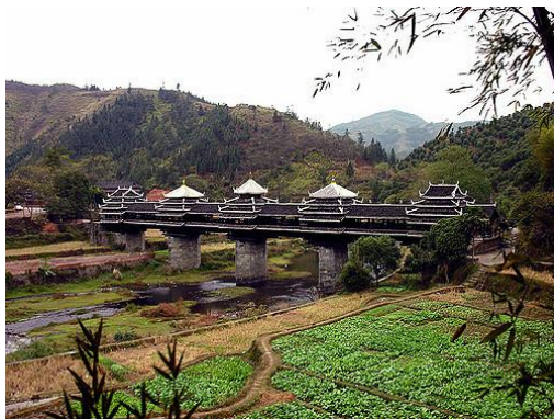
Fig. 48 Chengyang Bridge, Cina (foto tratta da www.flickr.com - giugno 2016)
