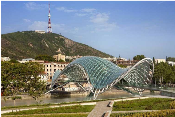
Fig. 130 Il Ponte della Pace (foto tratta da www.amdl.it - giugno 2016)
