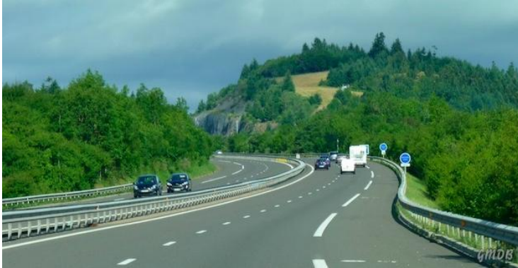
Fig. 15 Punto di vista interno all'infrastruttura (foto tratta da www.gmdb.it - maggio 2016)
