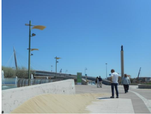
Fig. 111 Attacco a terra verso Nord del Ponte del Mare (foto dell'autore - aprile 2016)
