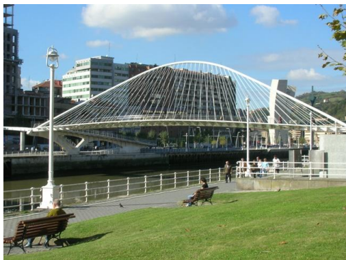
Fig. 76 Lo spazio di sotto dello Zubizuri, Bilbao (foto tratta da wikimapia.org - settembre 2015)
