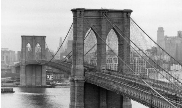
Fig. 93 Brooklyn Bridge, John Augustus Roebling, New York (foto tratta da www.wired.it - maggio 2016)
