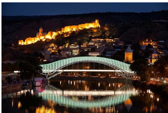
Fig. 129 Il Ponte della Pace di notte (foto tratta da www.amdl.it - giugno 2016)
