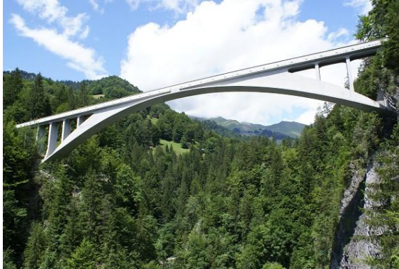
Fig. 155 Sanginaotbelbrücke, Robert Maillart (foto tratta da structurae.net - maggio 2016)
