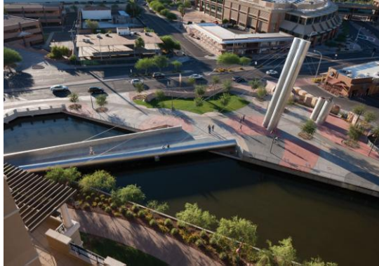
Fig. 51 Soleri Bridge and Plaza, Paolo Soleri, Scottsdale (foto tratta da scottsdalepublicart.org - luglio 2016)
