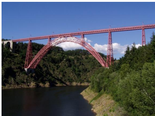
Fig. 94 Viaduc de Garabit, Gustave Eiffel, Francia (foto tratta da it.wikipedia.org - luglio 2016)
