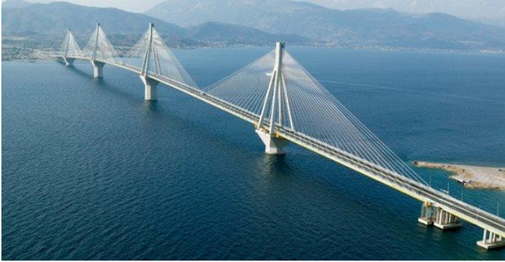
Fig. 101 Rion Antirion Bridge, Berdj Mikaëlianet, Grecia (foto tratta da www.agoravox.fr - giugno 2016)
