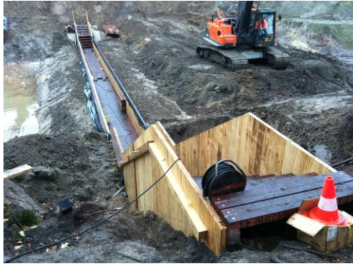
Fig. 122 Reinterro del Mozes Brug (foto fornita da RO&AD Architecten - giugno 2016)
