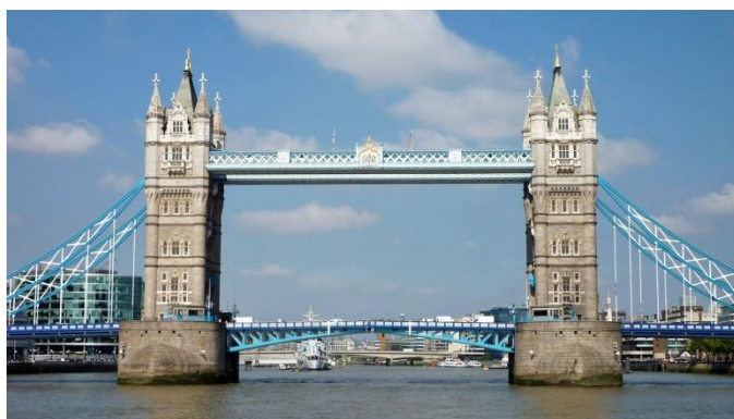
Fig. 87 Tower Bridge, Horace Jones e John Wolfe Barry, Londra (foto tratta da www.londondrum.com - giugno 2016)
