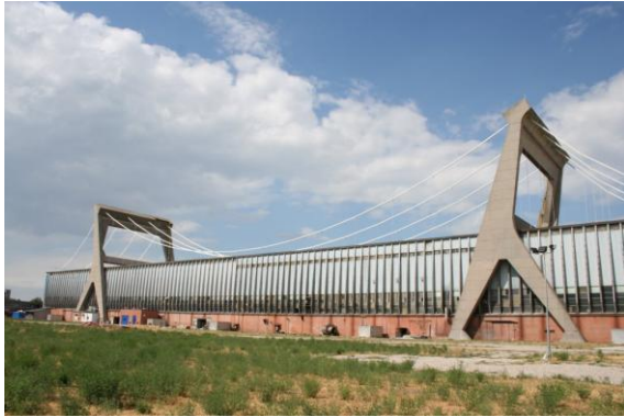
Fig 150 Cartiera Burgo a Mantova, Pier Luigi Nervi (foto tratta da www.architettura-del-moderno.it - luglio 2016)
