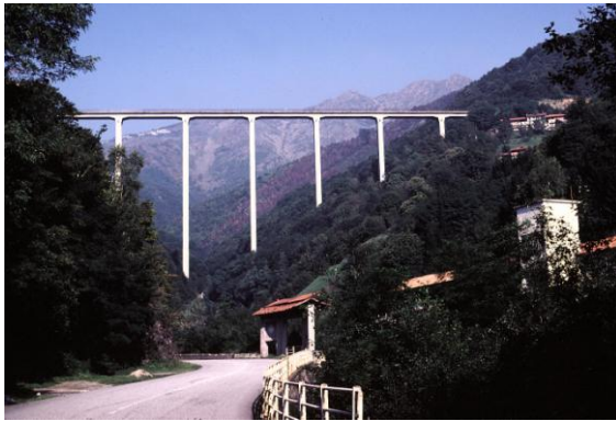
Fig. 31 Viadotto sul torrente Poala, Silvano Zorzi (foto tratta da mapio.net - maggio 2016)
