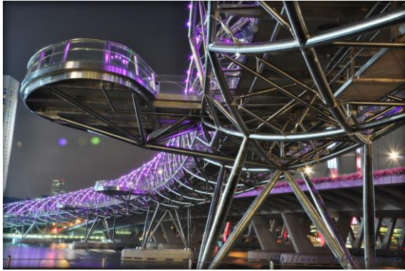
Fig. 58 Helix Bridge, Architects 61, Singapore (foto tratta homesthetics.net - giugno 2016)
