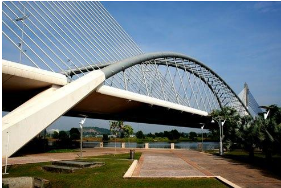
Fig. 75 Lo spazio di sotto del Seri Saujana Bridge (foto tratta da putrajayascenes - Luglio 2016)
