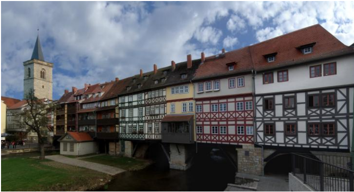
Fig. 35 Krämerbrücke, Erfurt (foto tratta da de.wikipedia.org - luglio 2016)
