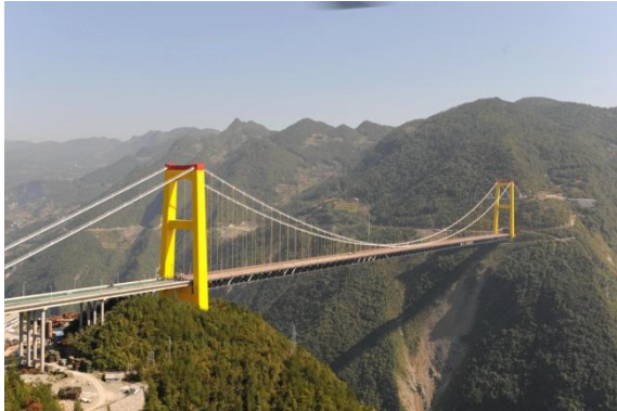
Fig. 99 Siduhe Bridge, CCC Second Highway Consultants Co. Ltd, Cina (foto tratta da www.highestbridges.com - giugno 2016)
