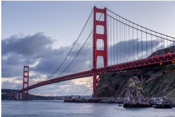
Fig. 96 Golden Gate Bridge, Joseph Baermann Strauss, San Francisco (foto tratta da inthesetimes.com - giugno 2016)
