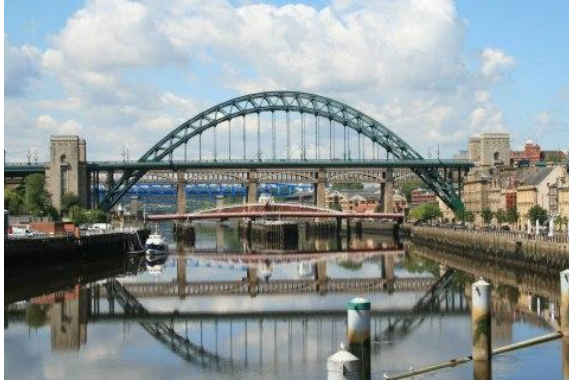
Fig. 88 Tynes Bridge, Mott, Hay and Anderson, Newcastle (foto tratta da www.historic-uk.com - giugno 2016)
