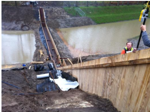
Fig. 123 Reinterro del Mozes Brug (foto fornita da RO&AD Architecten - giugno 2016)
