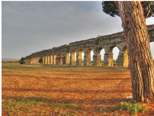
Fig. 18 Acquedotto romano (foto tratta da it.wikipedia.org - maggio 2016)
