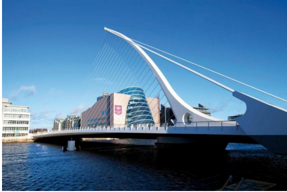
Fig. 78 Samuel Beckett Bridge, Santiago Calatrava, Dublino (foto tratta da www.ddda.ie - giugno 2016)
