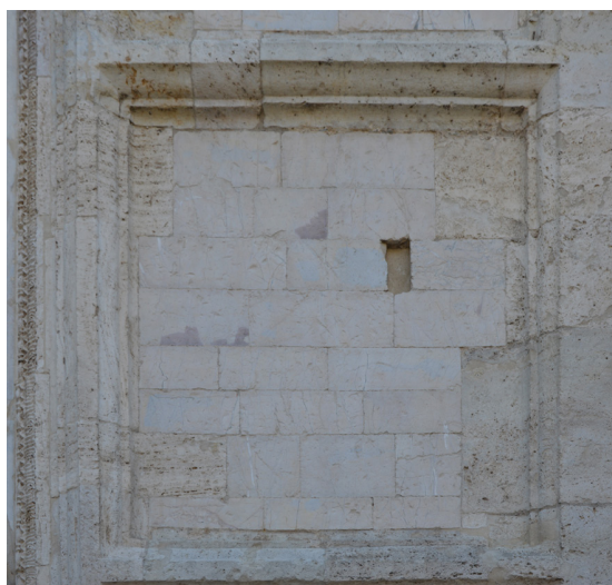
Fig. 7. Dettaglio di una specchiatura in scaglia rossa decolorata presente sulla facciata della cattedrale di S. Rufino ad Assisi (foto E. Scopinaro).
