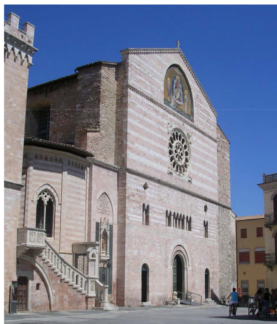
Fig. 1. La facciata principale della cattedrale di S. Feliciano a Foligno (foto M. Paolillo).
