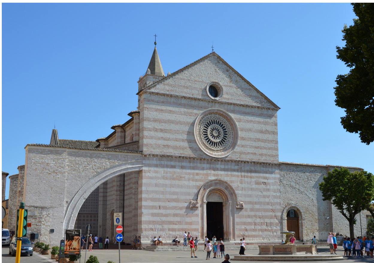
Fig. 8. Vista della chiesa di S. Chiara ad Assisi (foto E. Scopinaro).
