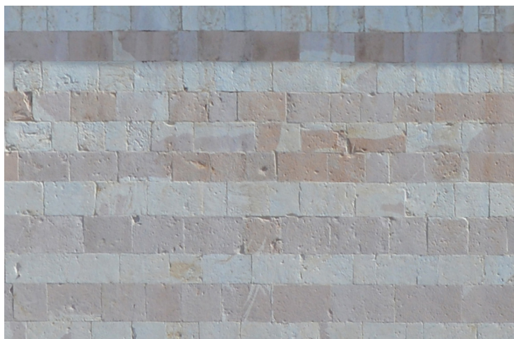
Fig. 9. Particolare della muratura della facciata della chiesa di S. Chiara ad Assisi (foto E. Scopinaro).
