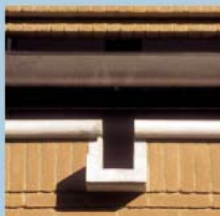
Scorcio delle logge e dettaglio del parapetto in corrispondenza del doccione.
