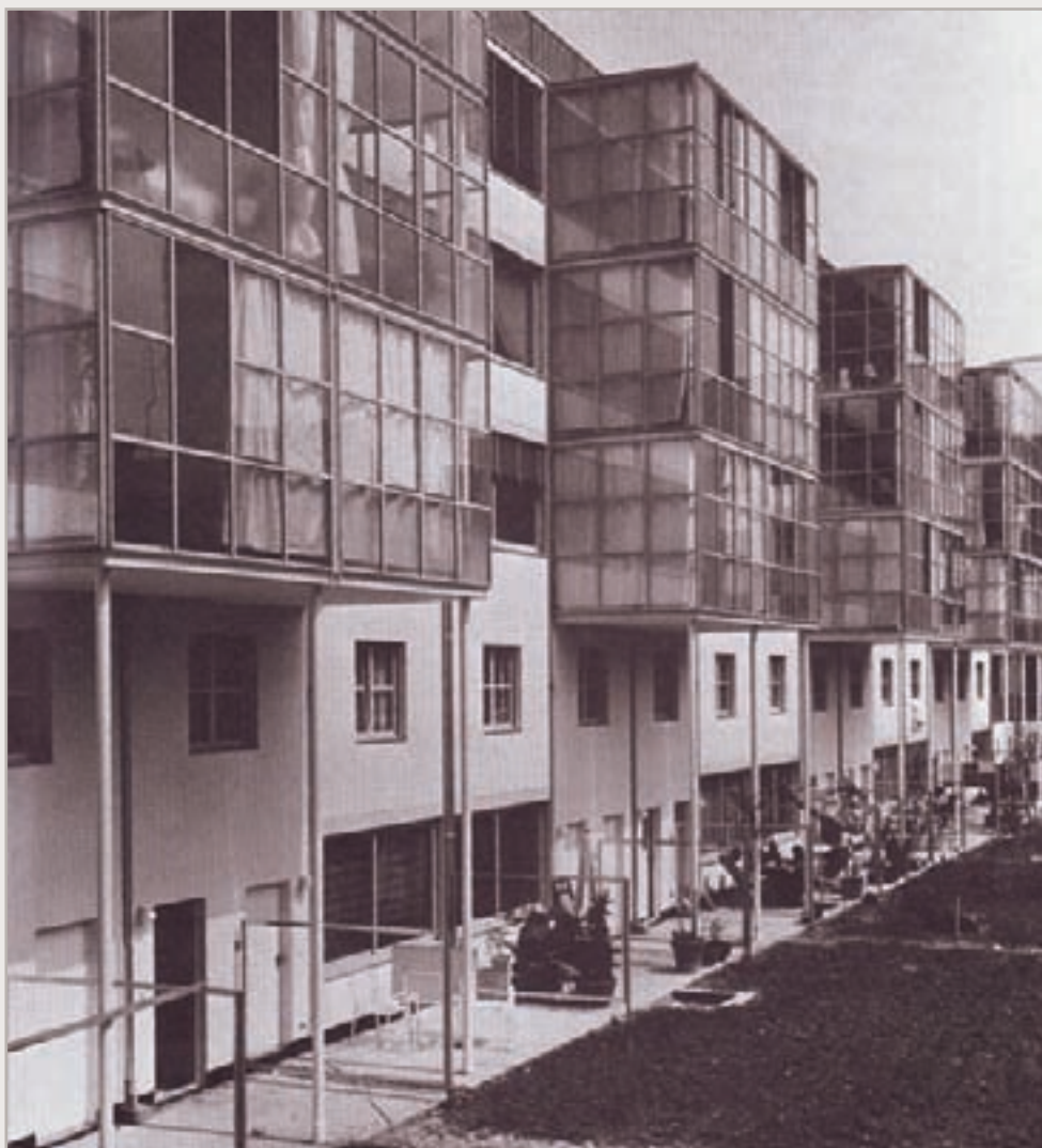
Fronte sulla corte interna
