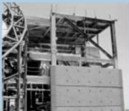
Vista del fronte principale del Museo e ripresa del cantiere nella fase di montaggio del tamponamento del volume superiore sulla struttura portante in acciaio.
