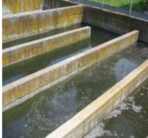
Figura 4.8 - Vasca di disinfezione dell'impianto di depurazione oggetto dello studio
