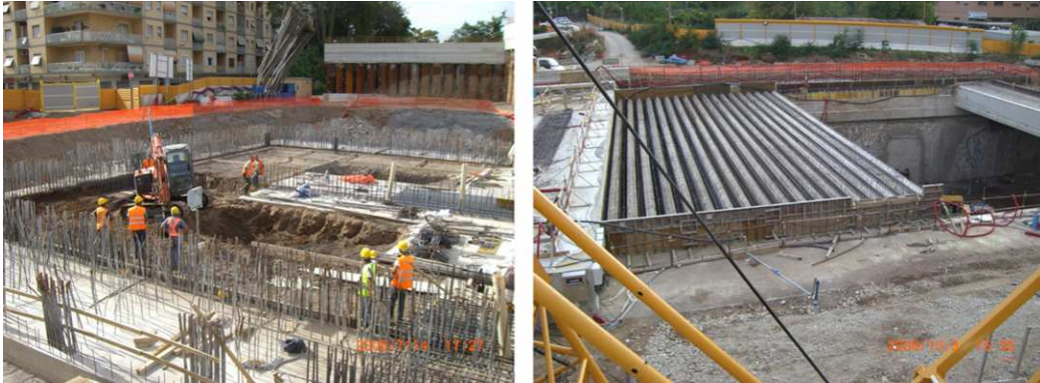
Figura 2-5. Pozzo TBM Malatesta- Lavori di realizzazione della nuova Linea C della Metropolitana di Roma: Realizzazione del solaio di copertura
