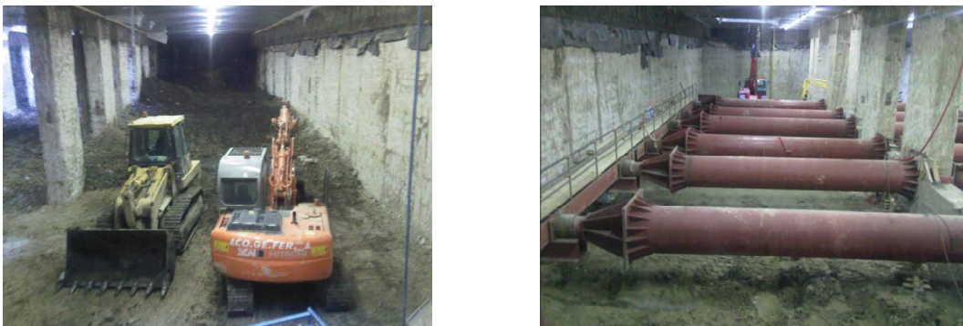
Figura 2-6. Stazione Annibaliano - lavori di realizzazione della nuova Linea B1 della Metropolitana di Roma: Metodologia di scavo "top-down", scavo sotto copertura e puntonamento
