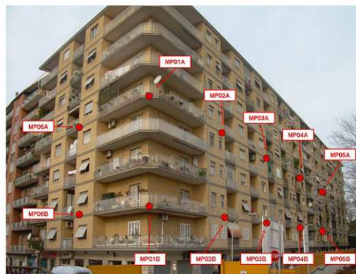
Figura 5-35. Strumentazione presente sugli edifici limitrofi le lavorazioni – Pozzo TBM Malatesta
