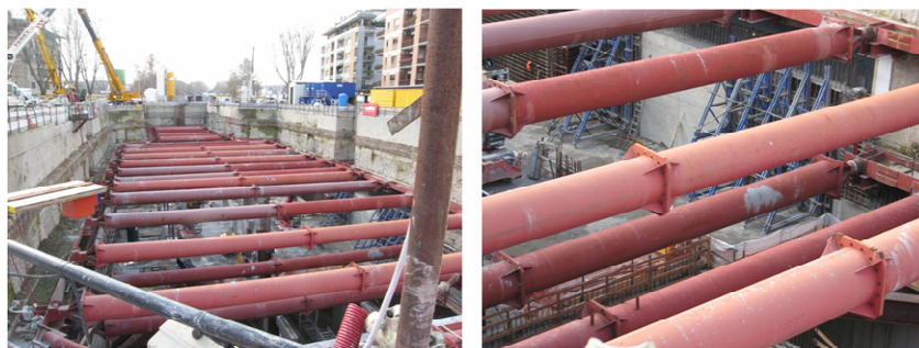
Figura 2-8. Stazione Conca d'Oro - lavori di realizzazione della nuova Linea B1 della Metropolitana di Roma: Metodologia di scavo "bottom-up", particolare puntoni metallici
