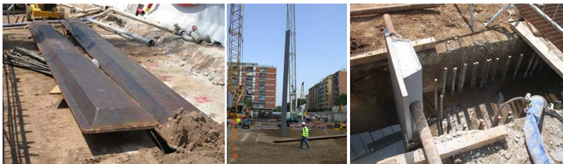
Figura 2-4. Particolare delle “palandole” utilizzate per creare il giunto idraulico; posa in opera delle palandole; vista del getto appena terminato, delimitato lateralmente dalla palanca
