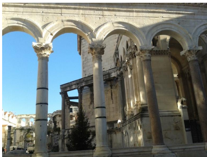
Prospettiva sul Peristilio ( Peristil ), cortile con colonnato del palazzo dell'imperatore Diocleziano, Spalato.
