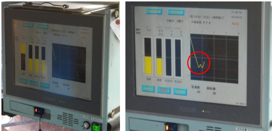
Figura 2.29 - Display operatore: Colonne dei parametri operativi in giallo (da sinistra verso destra profondità (m), velocità (m/min) e portate iniezione (l/m) e grafico dell'andamento con il tempo, con evidenziata la fase di bottoming.
