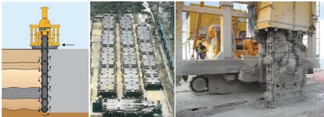
Figura 1.5 - Metodo TRD: schema, elementi del cutter post e lavorazione in corso (Sehn, 2012).
