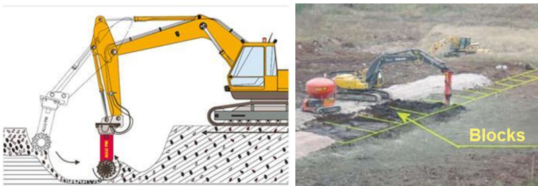
Figura 1.10 - Tecnologia ALLU per la stabilizzazione di massa (ALLU, 2007).
