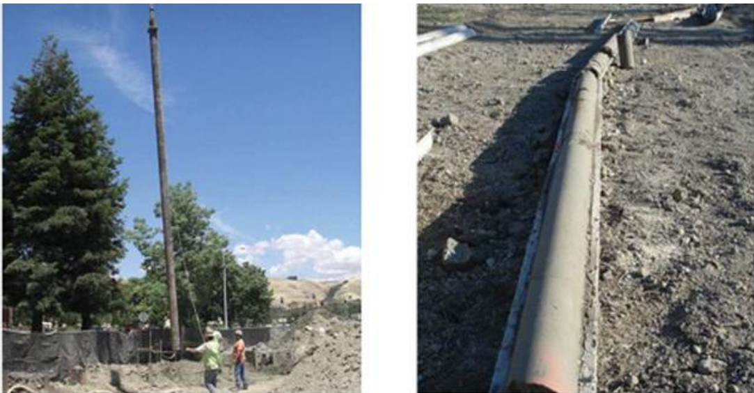
Figura 2.21 - Campionatore Schnabel per il prelievo di una verticale di terreno trattato (Weatherby, 2012).
