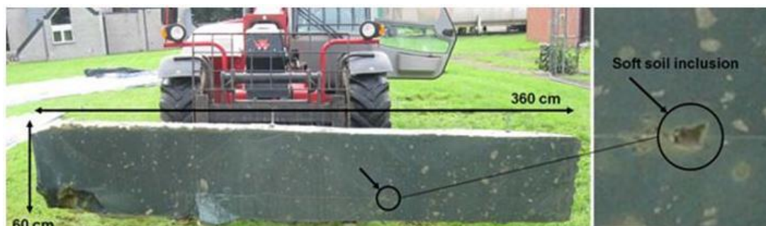
Figura 2.19 - Pannello CSM estratto ed ingrandimento di inclusione di terreno soffice non trattato (Denies et al., 2012b).
