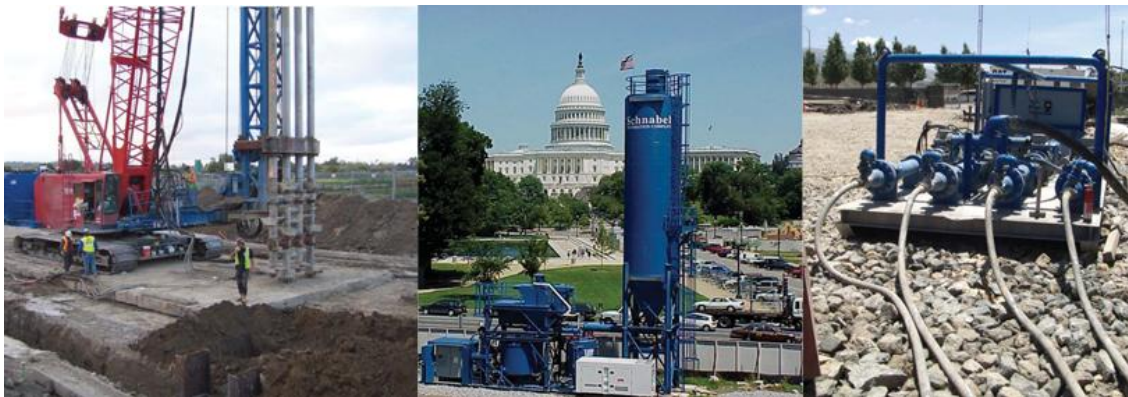
Figura 1.3 - Macchina Deep Mixing, impianto produzione della malta e pompe (Weatherby, 2012).
