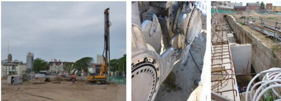
Figura 3.13 - Area di cantiere vista generale e particolare.
