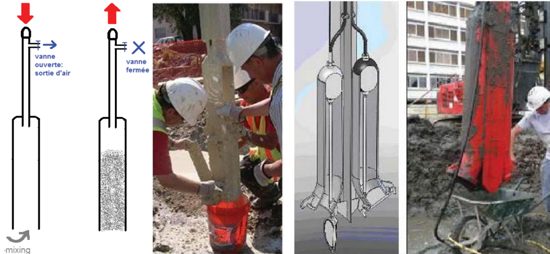
Figura 2.15 - Tipi di campionatori utilizzati per prelievo di miscela fresca (Deschamps 2012).
