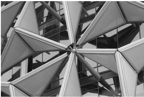
(c) Involucro edilizio delle Al Bahar Towers : particolare del singolo modulo.
