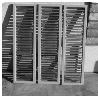
(c) Involucro edilizio adattivo proposto da (D'Annibale et al. [42]), particolare dei telai di supporto delle lamelle bistabili.
