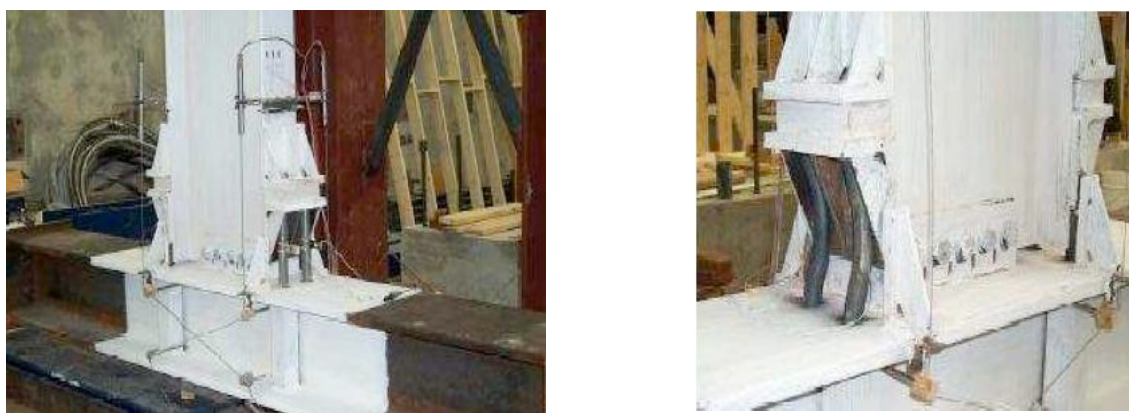
Fig.11: Rinforzo travi con tondini in lega a memoria di forma
