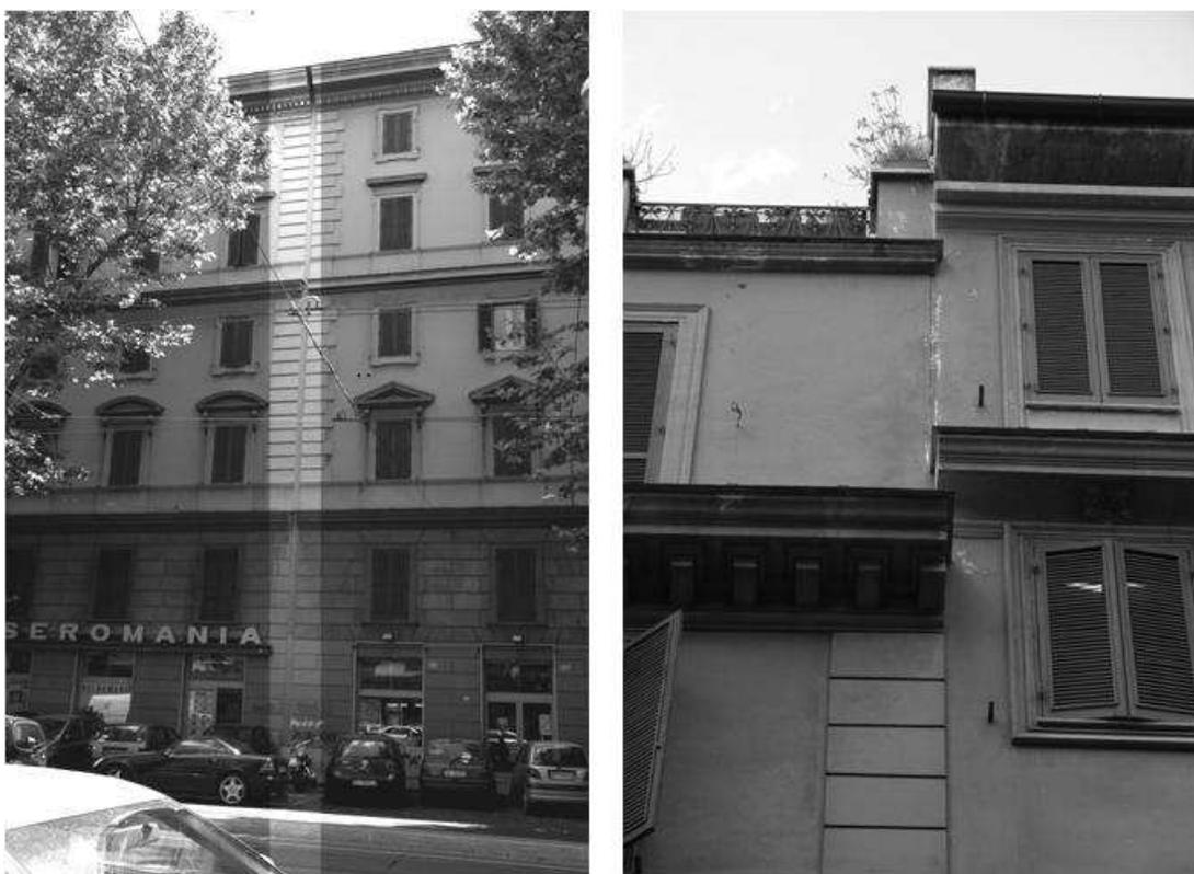
**Figura 1.7.** Un esempio delle condizioni al contorno che possono modificare il comportamento delle US in adiacenza: a sx un giunto con i solai alla medesima quota, a dx con solai sfalsati.
