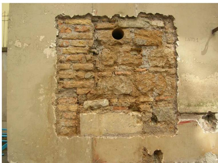
**Figura 5.5.** Riquadro di muratura portante costituito da blocchi di tufo listati.
