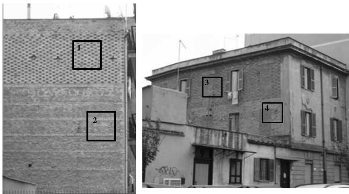
**Figura 1.8.** Risposta differenziale legata all'eterogeneità nell'apparecchiatura muraria.
