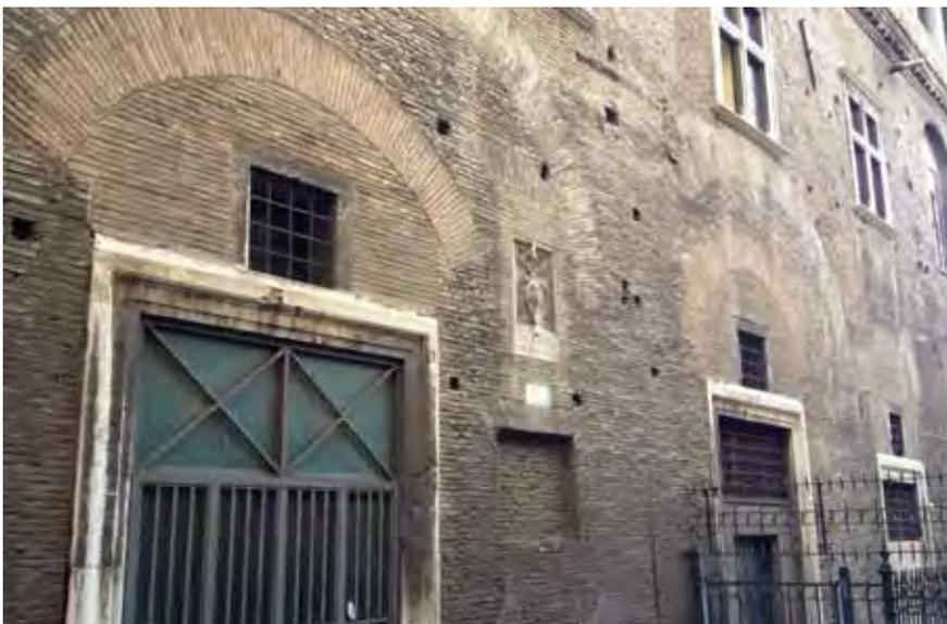
*Fig. 1.12 – La Casa dei Cavalieri di Rodi, prospetto su via di Campo Carleo. Particolare delle aperture in corrispondenza delle antiche tabernae.*
