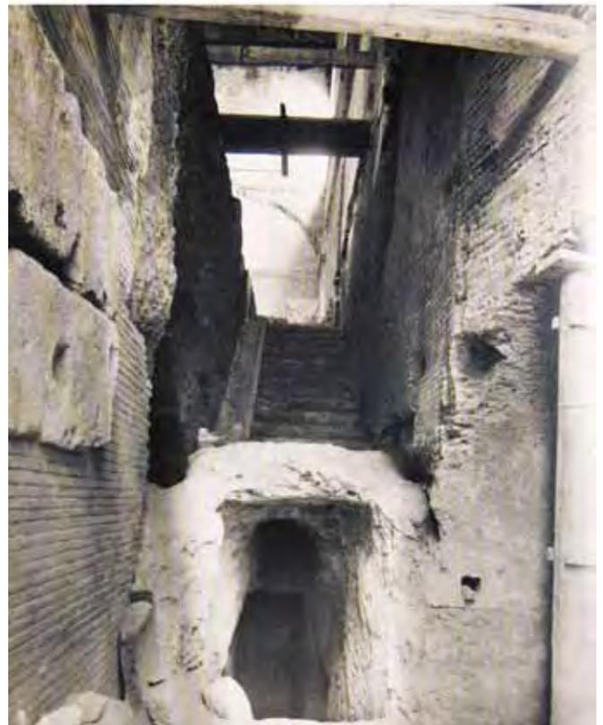
Figg. 3.8-3.9 – La scala di accesso alla Casa. In basso, durante i lavori del grande restauro (da Leone e Margiotta, 2007). Si può notare la canalizzazione che correva sotto questa scala antica, presenti entrambe fin dalla prima fondazione dell'edificio.
