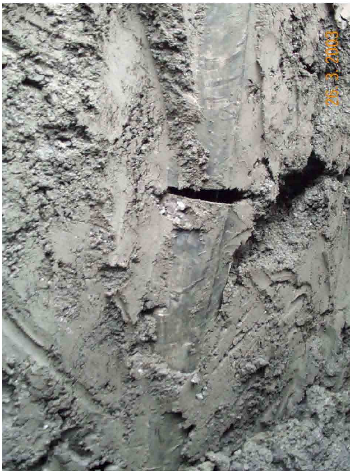
Fig. 3.52. Masseria Marino: all'interno del pozzo realizzato per il prelievo dei campioni si osserva che il palo strumentato è tranciato in corrispondenza della superficie di scorrimento
