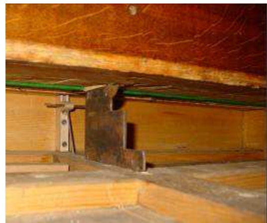
Il rinforzo metallico all'interno del vano tastiera
