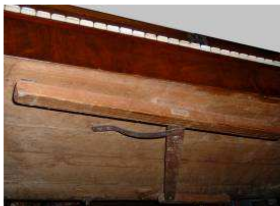
La ginocchiera sul fondo dello strumento
