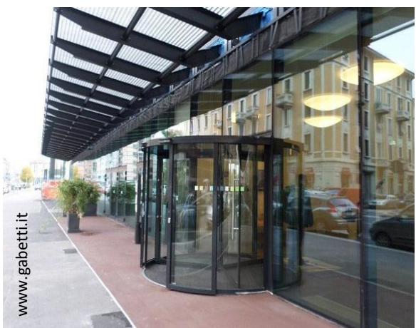
Fig. 105. MAC 567. Accesso da via Imbonati
