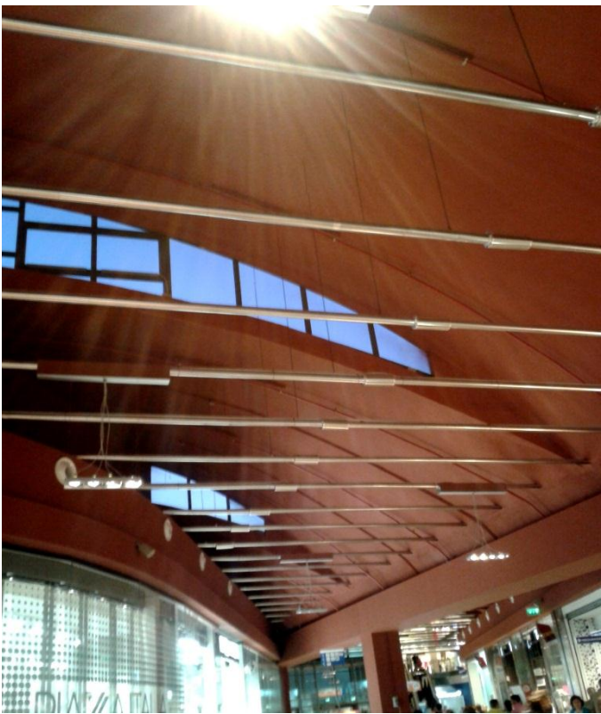
Fig.120.La Cartiera .Recupero coperture preesistenti.
