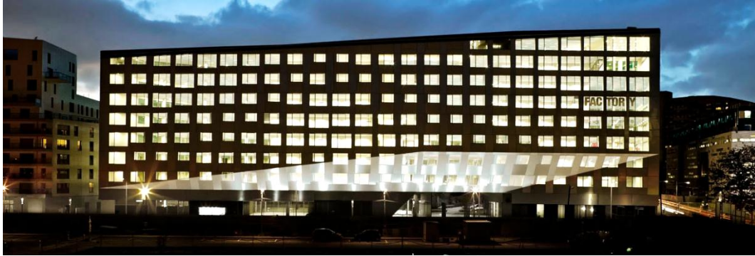
Fig.112. La Factory. Facciata principale su rue Emile Zola
