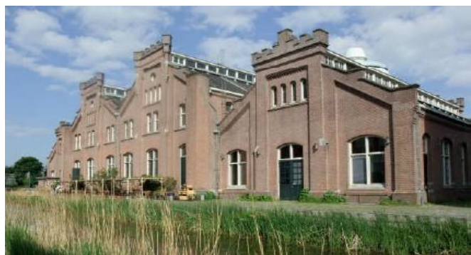
Fig. 91. Stazioni di pompe dell'acqua 1853. Riconversione in Gran Cafè Amsterdam, agenzia di pubblicità
