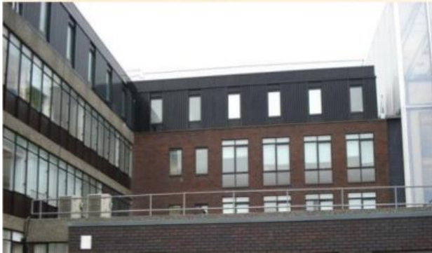
Fig. 213. Università di Brunel. Ufficio piano attico,
