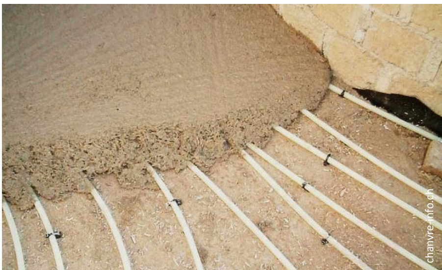
Fig. 19. Miscela di Cannabric, isolamento pavimentazione.
