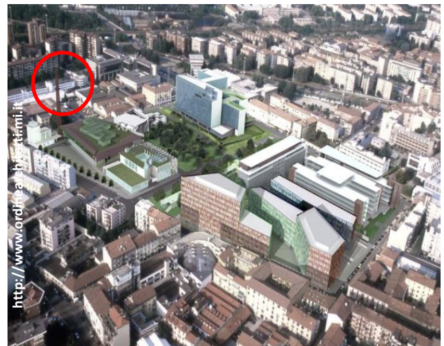
Fig. 98. Riqualificazione ex area industriale dismessa, azienda Carlo Erba anni '20 con preesistente ciminiera.
