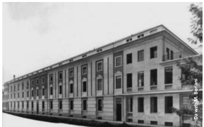
Fig. 100. Ex fabbrica farmaceutica Carlo Erba anni '20 ( 1.400 lavoratori), via Bracco. Milano
