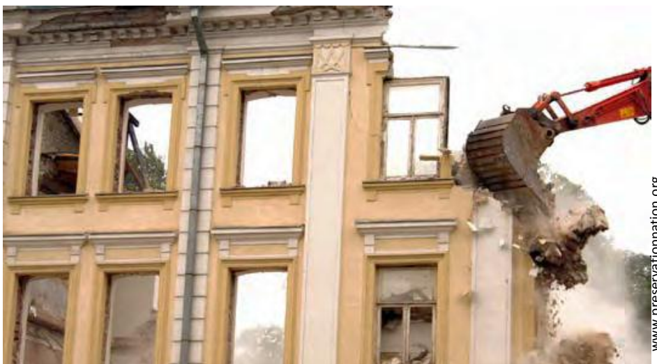
Fig.77. Demolizioni parziali e riuso di materiali con recupero e riconversioni
