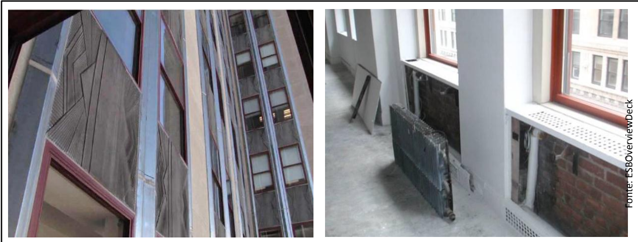
Fig. 193.ESB. Dettaglio facciata appesa. Curtain Wall
