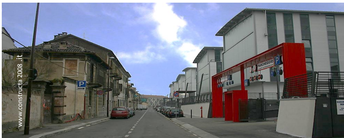
Fig. 96. SNOS. Ingresso galleria da ex accesso vagoni merci. Contestualizzazione di nuova edificazione con preesistenze -Torino
