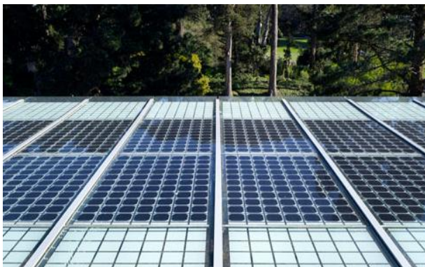
Fig. 40. Fotovoltaico sulle pensiline di bordo copertura Fonte: http://www.calacademy.org .
