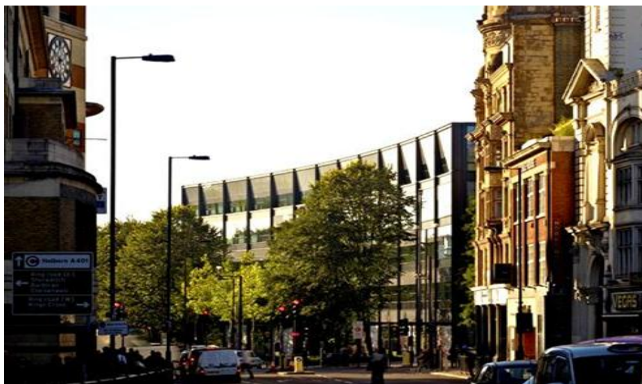
Fig. 107. Riqualificazione edificio Angel Building- Involucro in vetro in contesti di preesistenze storico/architettoniche
