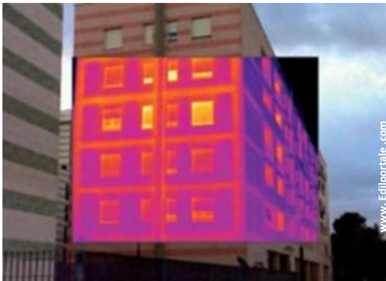
Fig.160. Indagine termografica sull'involucro
