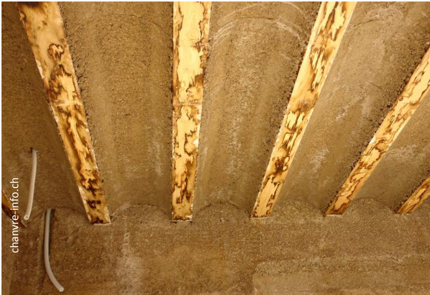
Fig.17. Materiale Cannabric-Miscela per isolamento e recupero solai.
