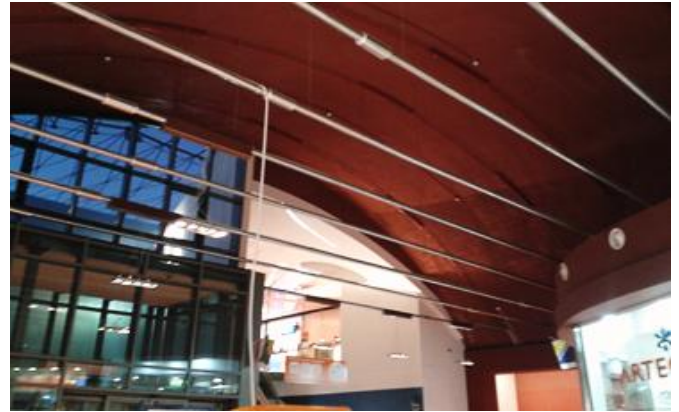
Fig. 119.La Cartiera-Recupero coperture preesistenti.
