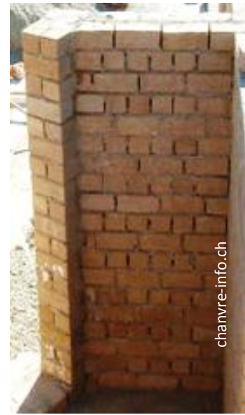
Fig. 18. Cannabric. Mattoni per murature e per isolamento a cappotto.
