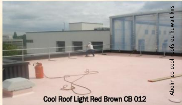
Fig. 214. Applicazione di cool material sul tetto.
