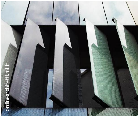
Fig. 101. MAC 567. Facciata curtain wall. Lamelle frangisole in vetro 12 mm serigrafati, ruotano su asse
