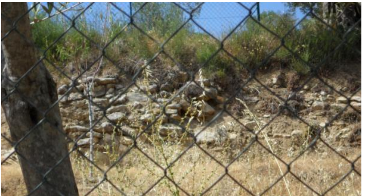
Fig. 7.85 Olmo, Citerne, muratura di contenimento in prossimità di un'area fittile.
