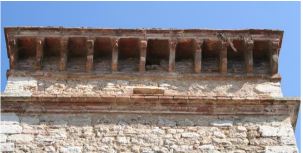
Fig. 7.97 Ellera, complesso degli Sciri. Sistema di copertura con mattoni dipinti.
