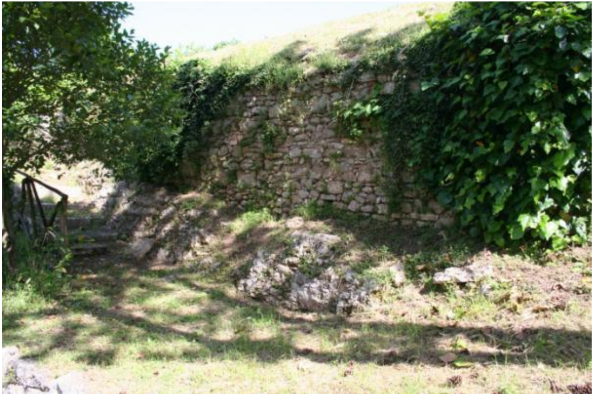
Fig. 7.80 Santa Sabina, chiesa e complesso annesso, muratura di contenimento.
