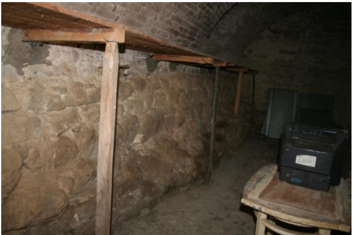
Fig. 7.120 Montesperello, castello, murature medievali dai sotterranei.
