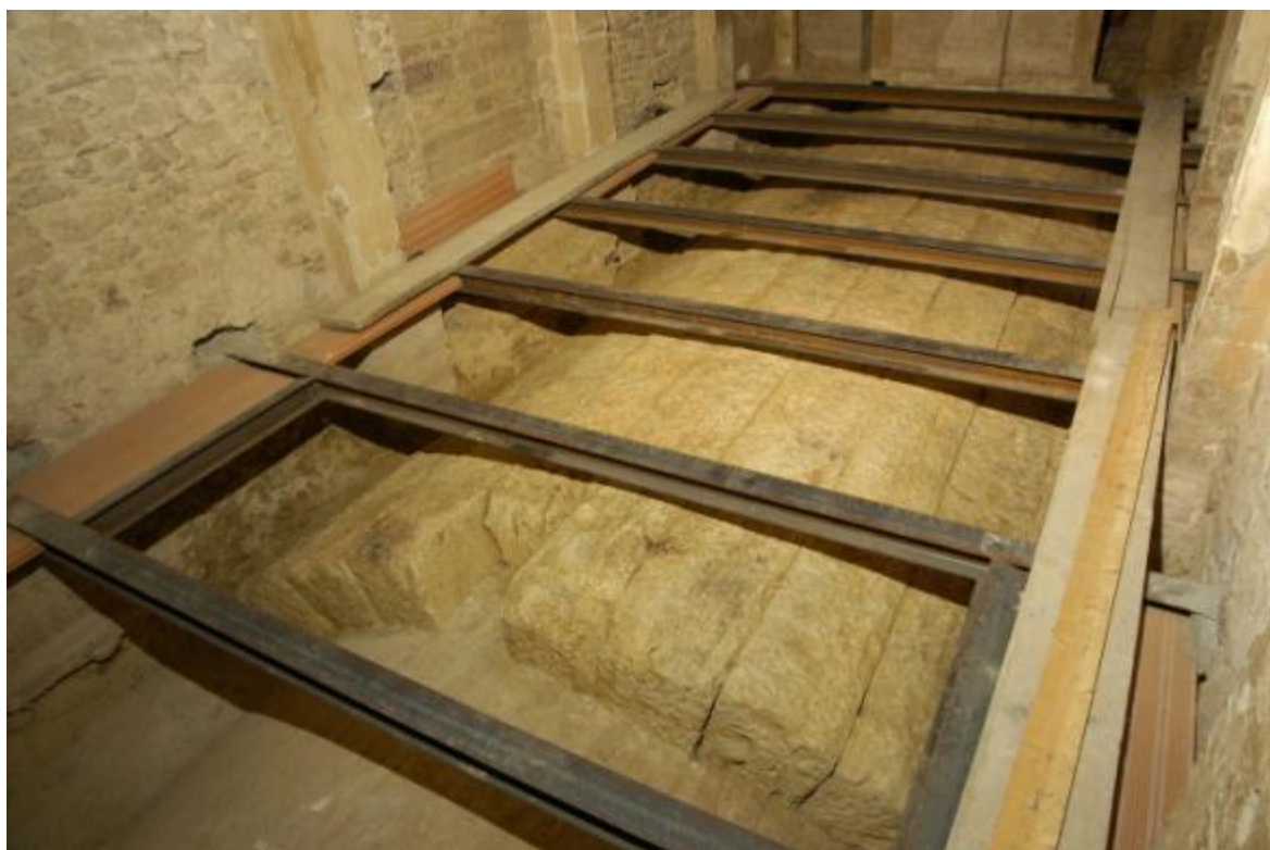
Fig. 7.59 Perugia, ipogeo di San Manno, copertura della volta. Archivio fotografico SBAU.
