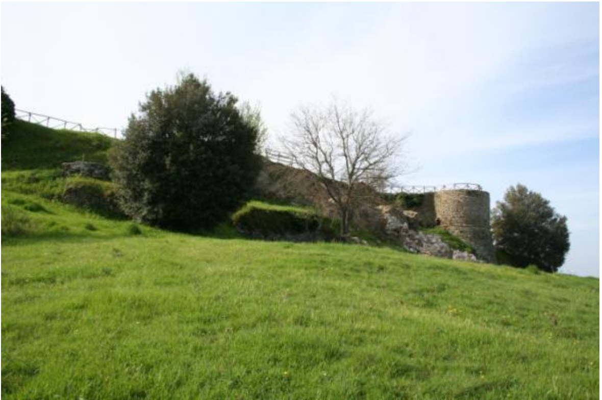
Fig. 7.135 Montali,, Castello, torri medievali e camminamento di ronda.
