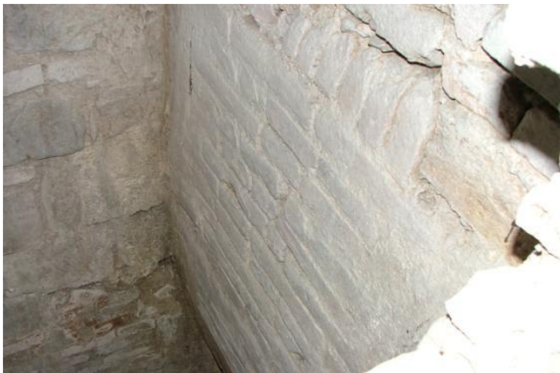
Fig. 7.17 Perugia, via Danzetta, muro etrusco.
