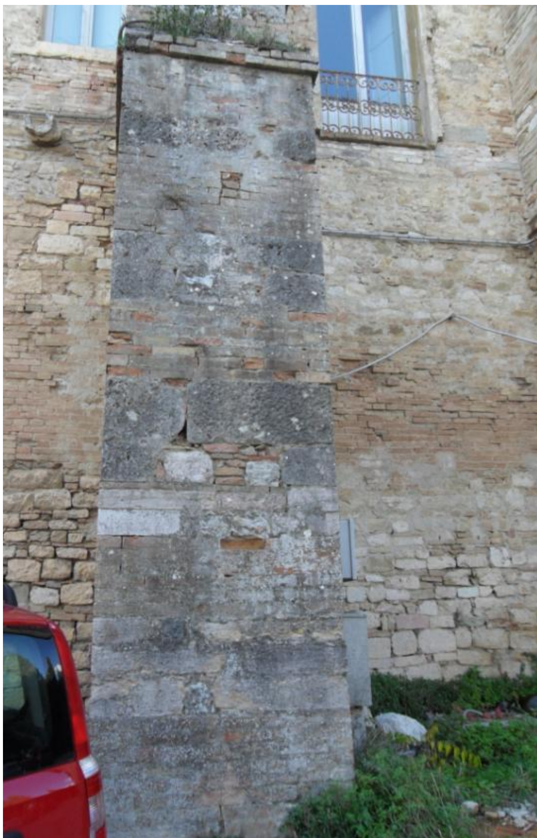
Fig. 7.3 Perugia, muro di sostegno del monastero di San Pietro.
