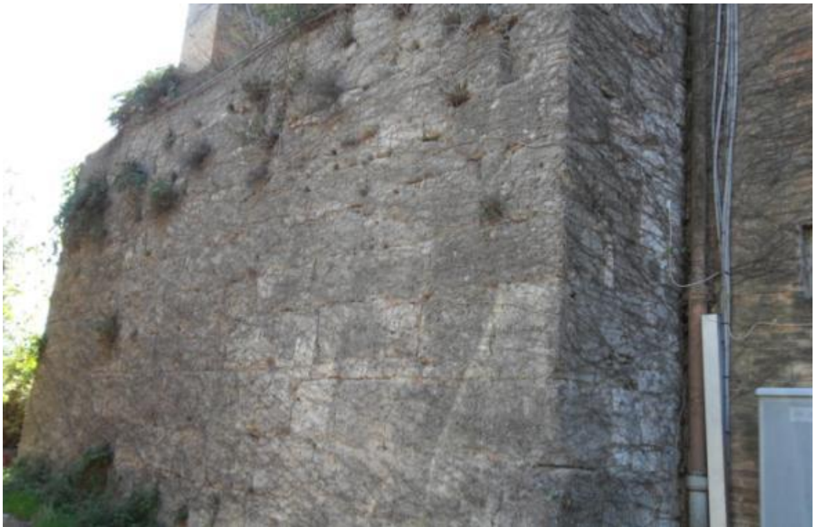
Fig. 7.2 Perugia, Muro di sostegno del monastero di San Pietro.
