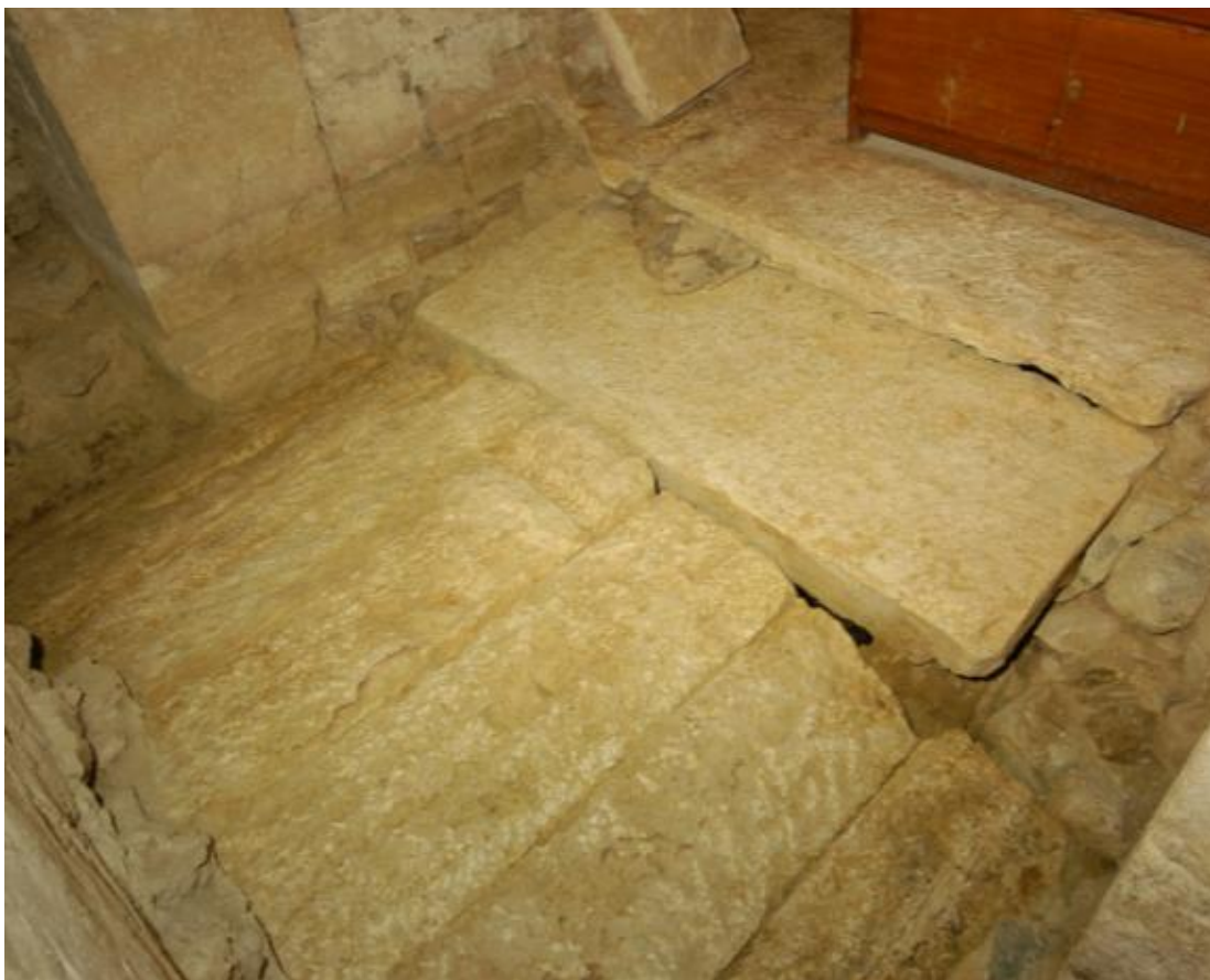
Fig. 7.55 Perugia, ipogeo di San Manno, copertura della volta. Archivio fotografico SBAU.
