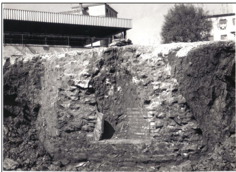
Figura 148. Largo Pestalozzi: resti di un condotto idraulico (SBAR, Archivio Santolini).
