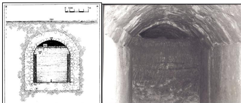
Figura 16. Via Pestalozzi – via Pineta Sacchetti, centro di Potabilizzazione ACEA. Particolare dello speco del tratto UT 145. e in una foto e in un rilievo di dettaglio (MATTEUCCI–MINEO 2000).
