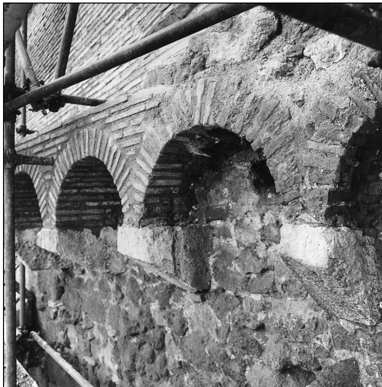
Figura 25. Particolare delle murature medievali a sinistra del primo arco di ponte Milvio (SBCAF).
