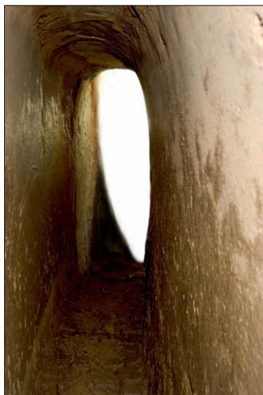
Figura 107. Via della Pineta Sacchetti: speco sotterraneo (SBAR, Archivio Santolini)
