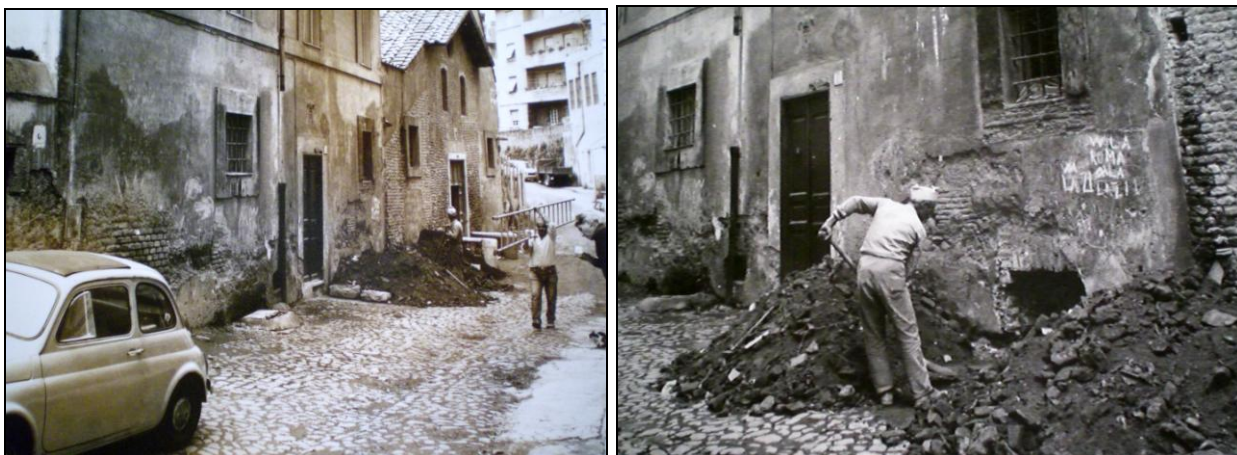
Figura 77. Immagine dei lavori di restauro degli anni '70 del '900 nella chiesa di San Lazzaro dei Lebbrosi (da ACSV, bb. 8.1.5.1 (1590-1899) - 8.1.5.2 (1887-1989), per gentile concessione di Mons. Rezza).
