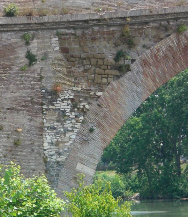
Figura 26. Particolare della muratura medievale lungo il lato E della testata N di ponte Milvio (foto autore).
