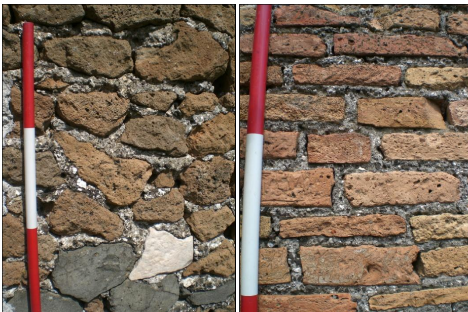
Figura 103. Torre di Quinto. Particolare delle tecniche costruttive (Tipi 1 e 2) adottate nella costruzione (foto autore).
