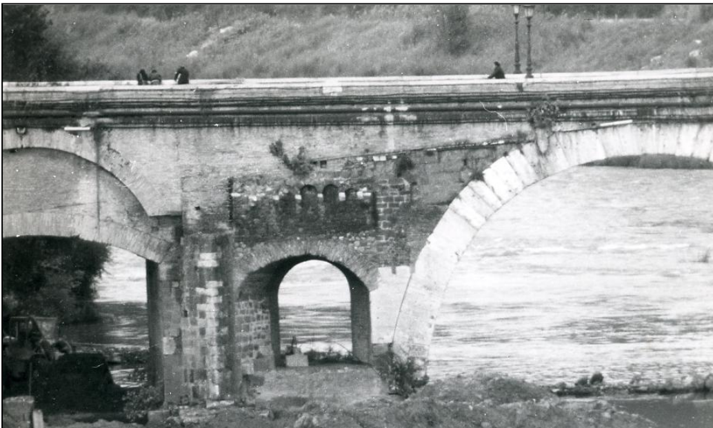
Figura 24. Particolare delle murature medievali sul lato orientale della testata meridionale di ponte Milvio (SBCAF).
