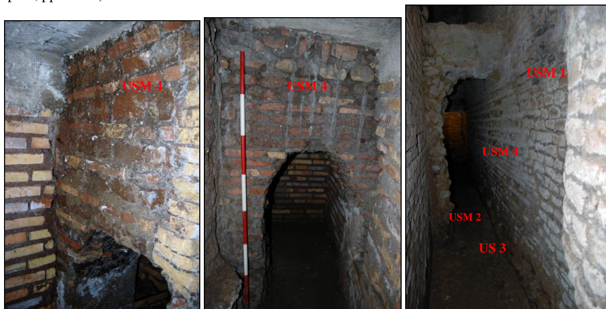
Figura 80. Chiesa di San Lazzaro dei Lebbrosi: particolare di muratura in opera listata individuata sul lato di fondo dell'edificio di culto (foto autore).
