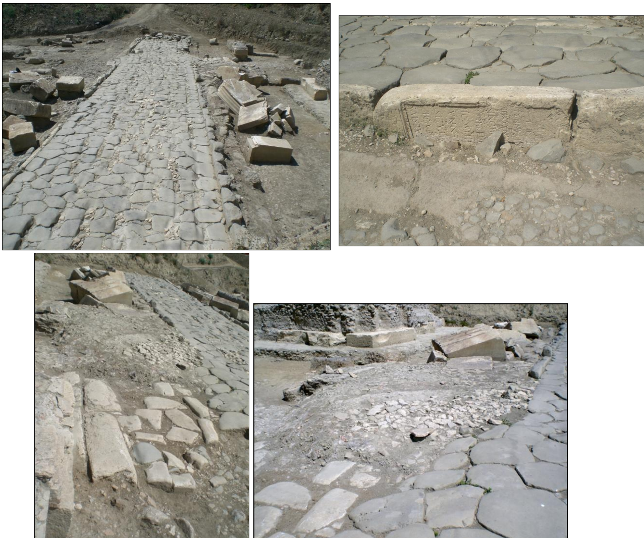
Figura 14. Alcuni dettagli della sede stradale con i suoi rifacimenti da età tardo-antica ad epoca rinascimentale.
