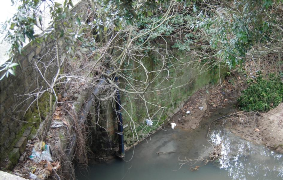
fig. 53 b. Ponte di Acquatraversa. Quota di spicco delle fondazioni a scarpa del ponte sul lato O (foto autore)
