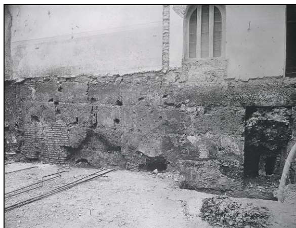
Figura 36. Chiesa di S. Pellegrino degli Svizzeri. Particolare della muratura N dell'edificio altomedievale (Musei Vaticani, neg. XXXII-121-99).
