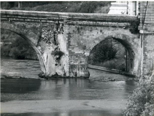
Figura 28. Veduta di tratti di muratura medievale a destra del secondo arco di ponte Milvio.
