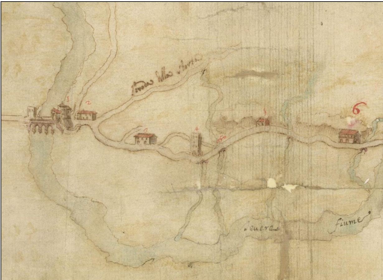
Figura 107. ASR, Presidenza delle Strade, Catasto Alessandrino, mappa 433/IV. Dettaglio della torre di Quinto e dei tre ponti noti per l'attraversamento della via Flaminia dei fossi di Acquatraversa e della Crescenza.
