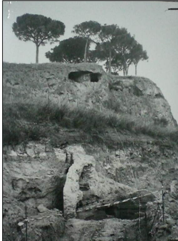
Figura. 114. Resti di un impianto idraulico, alla base di Monte delle Grotte (da AFSBAR).
