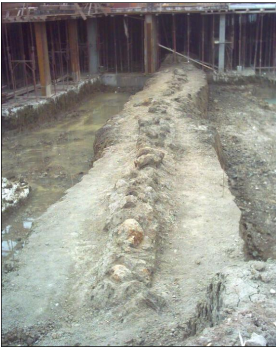
Figura 123. Resti di impianto di lavorazione (da SBAR, Piazza delle Finanze).
