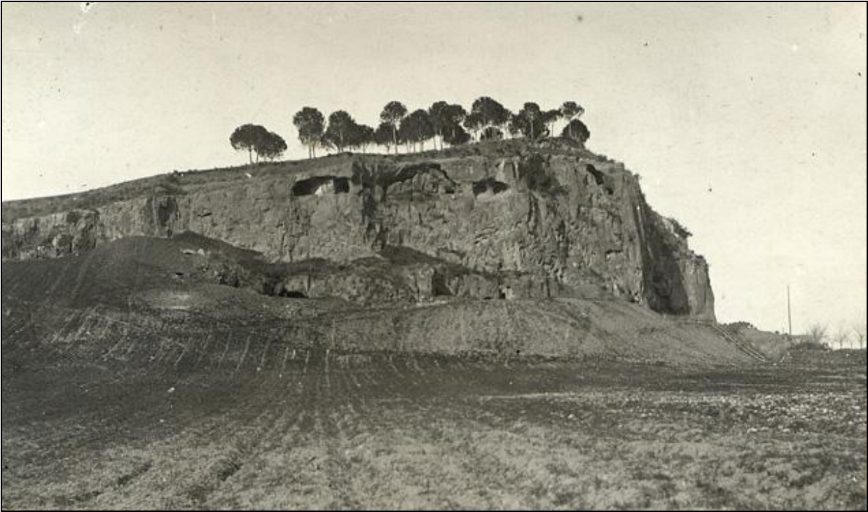
Figura 121. Monte delle Grotte da SO. Panoramica delle numerose cavità lungo il fronte, sezionato dalle attività estrattive di epoca moderna (BSR, foto Mackey).
