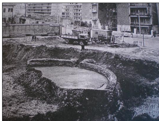
Figura 95. Resti di cisterna in via Cadlolo (SBAR, Archivio Santolini, schedario 01).
