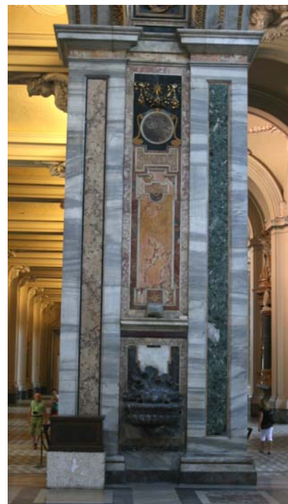
Fig. 54 – Transetto in San Giovanni in Laterano. Particolare paraste nei piedritti in corrispondenza delle navate laterali (foto dell'A.)
