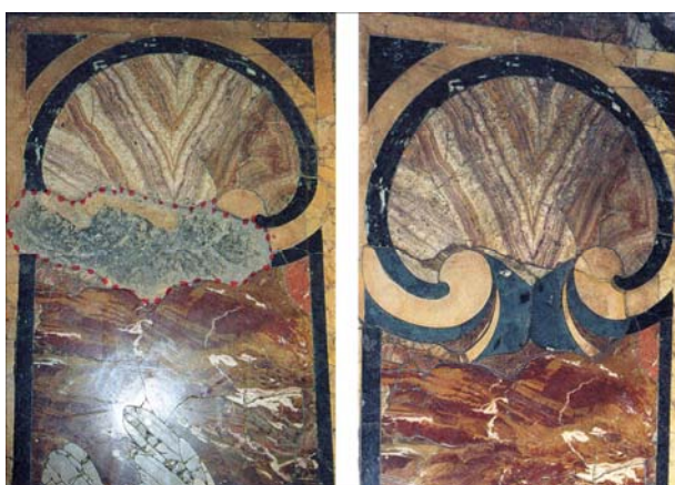
Fig. 9 – Sant’Agnese in Agone. Intervento di integrazione con marmi artificiali (da PERGOLI CAMPANELLI 2003)
