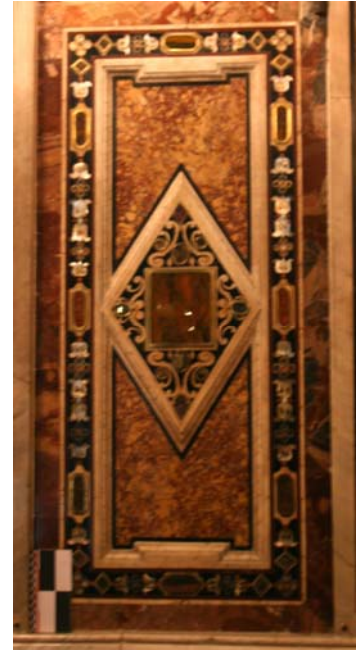
Fig. 1 – Cappella di San Filippo Neri. Particolare pannello intarsiato con marmi e pietre dure (foto dell'A.)
