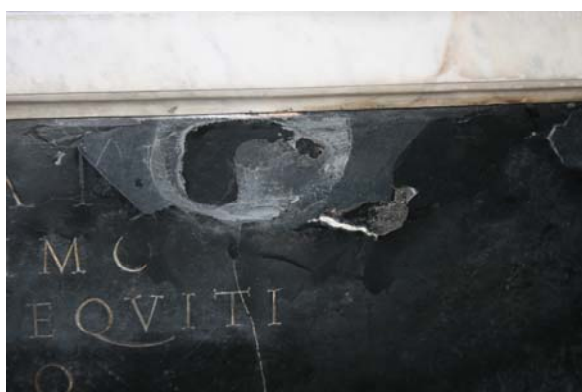
Fig. 1 – Cappella Caetani. Scagliatura e mancanza di materiale (foto dell'A.)
