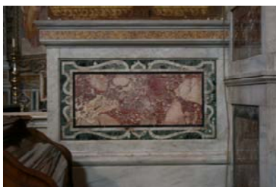
Fig. 5 – Coro di Santa Susanna. Particolare pannello di rivestimento in commesso marmoreo (foto dell'A.)
