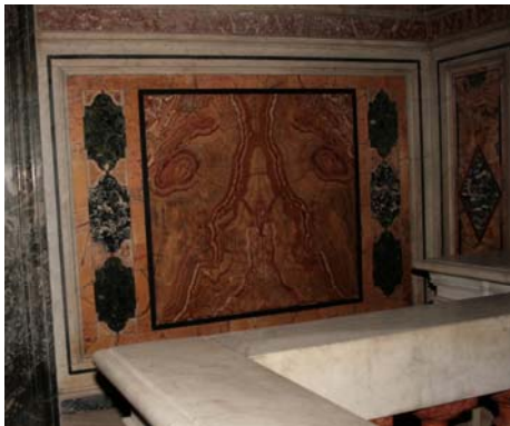
Fig. 8 – Cappella di Sant'Andrea al Gesù. Particolare pannello di rivestimento con assemblaggio delle lastre centrali 'a macchia aperta' (foto dell'A.)
