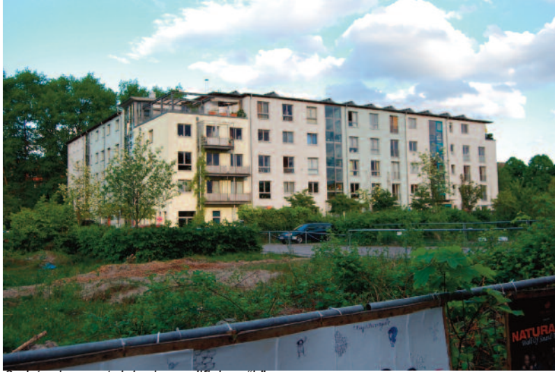
3 vista da ovest del primo edificio a "L"
