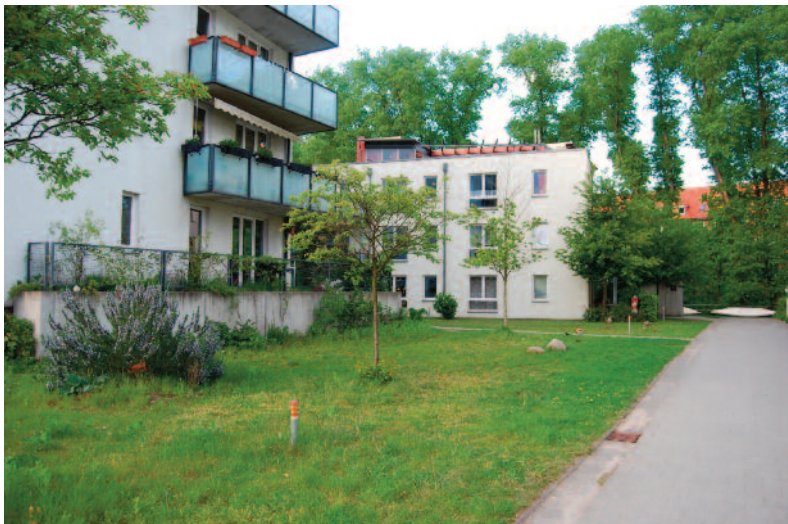
10 strada interna tra i primi due edifici a "L", anch'essa inaccessibile alle automobili
