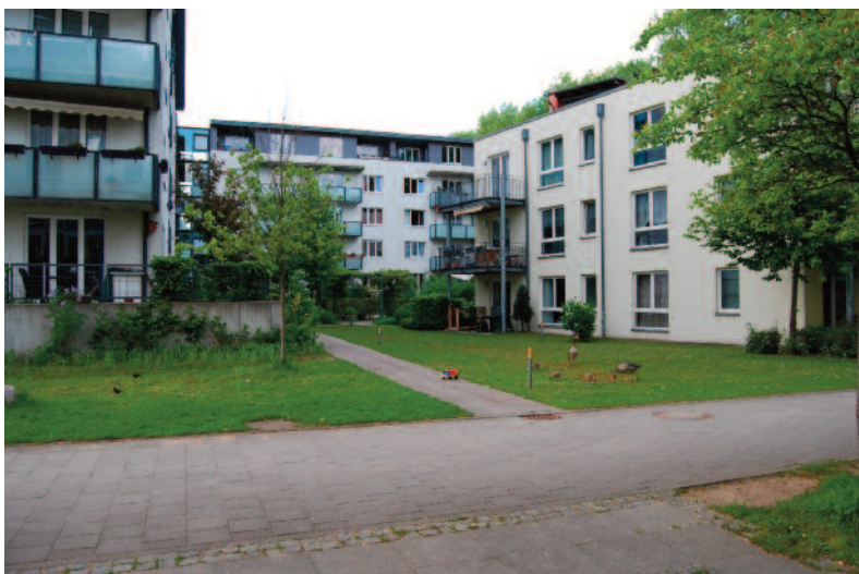
11 particolare del cortile del secondo edificio a "L" e della casa puntiforme
