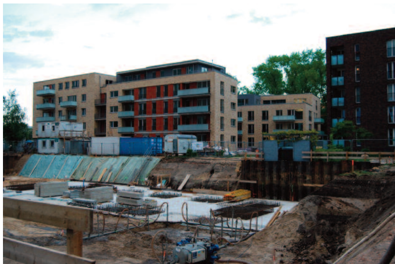
5 vista del terzo edificio a "L" in costruzione
