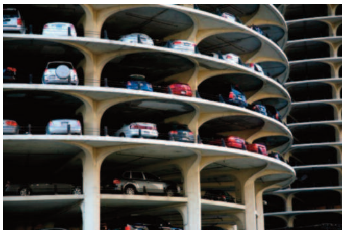
19 Chicago, torri della Marina City, particolare dei parcheggi ubicati nei primi 20 piani delle torri
