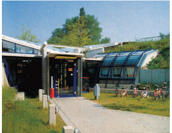
14 accesso principale del giardino d'infanzia
