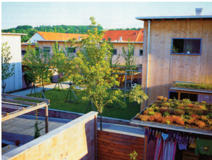
16 vista dello spazio centrale alberato e dei tetti ricoperti di vegetazione
