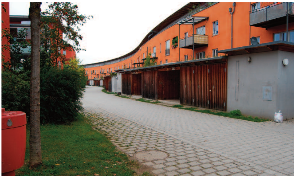
3 vista dell'edificio curvilineo, (2009)
