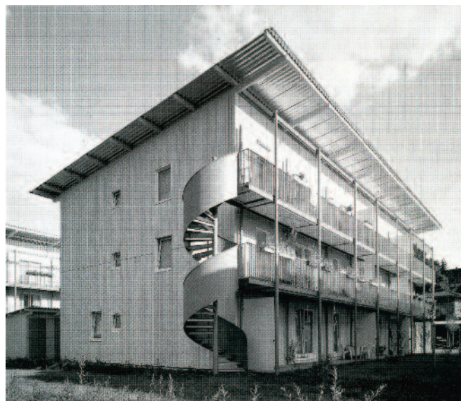
10 i balconi continui fungono da ulteriore via di fuga in caso di incendio
