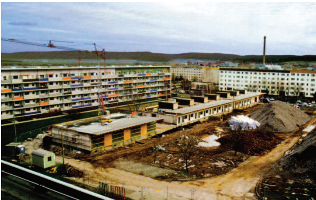
19 cantiere della demolizione parziale, in primo piano la casa in linea ridotta ad un piano destinata ad un edificio polifunzionale il cosiddetto Mieterzentrum
