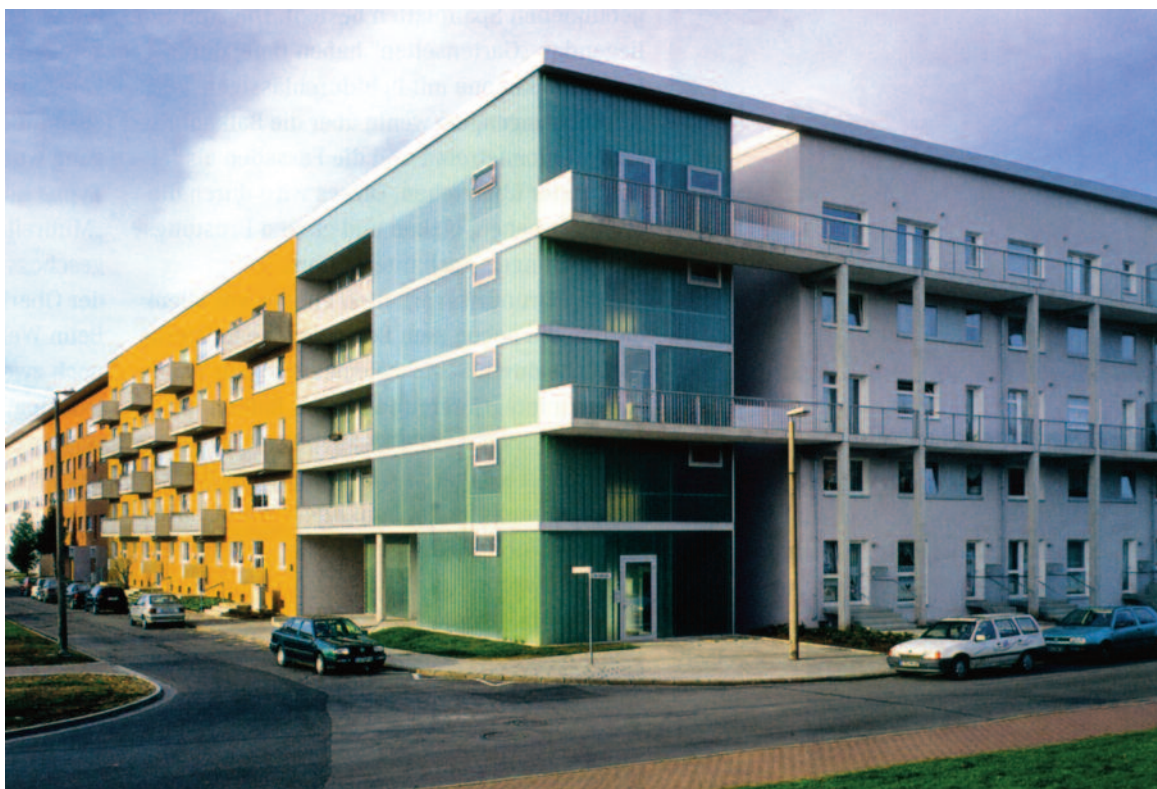
18 vista dell'angolo nord-est con la successione delle facciate tipo "Maeander", "Neubau" e "Laubengang" con ballatoi aggiunti
