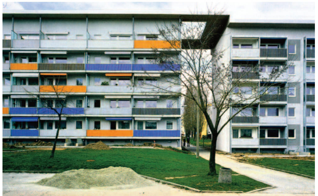
7 vista della facciata
