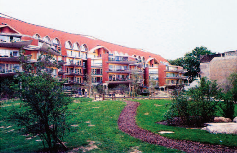
20 vista dell'edificio addossato al muro tagliafuoco
