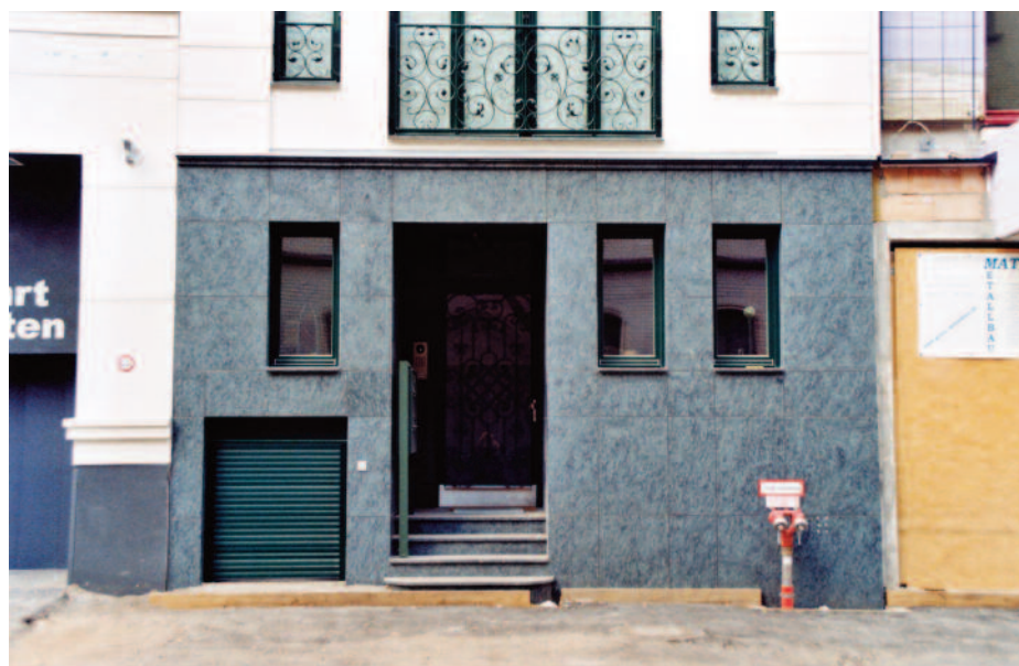
20 particolare ingresso su Niederwallstrasse, (2008)
