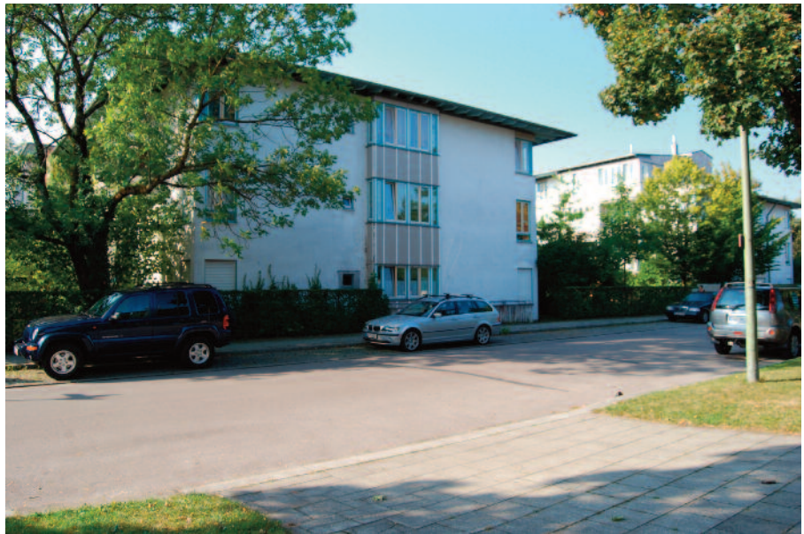
5 vista da Volpinistrasse, (2009)
