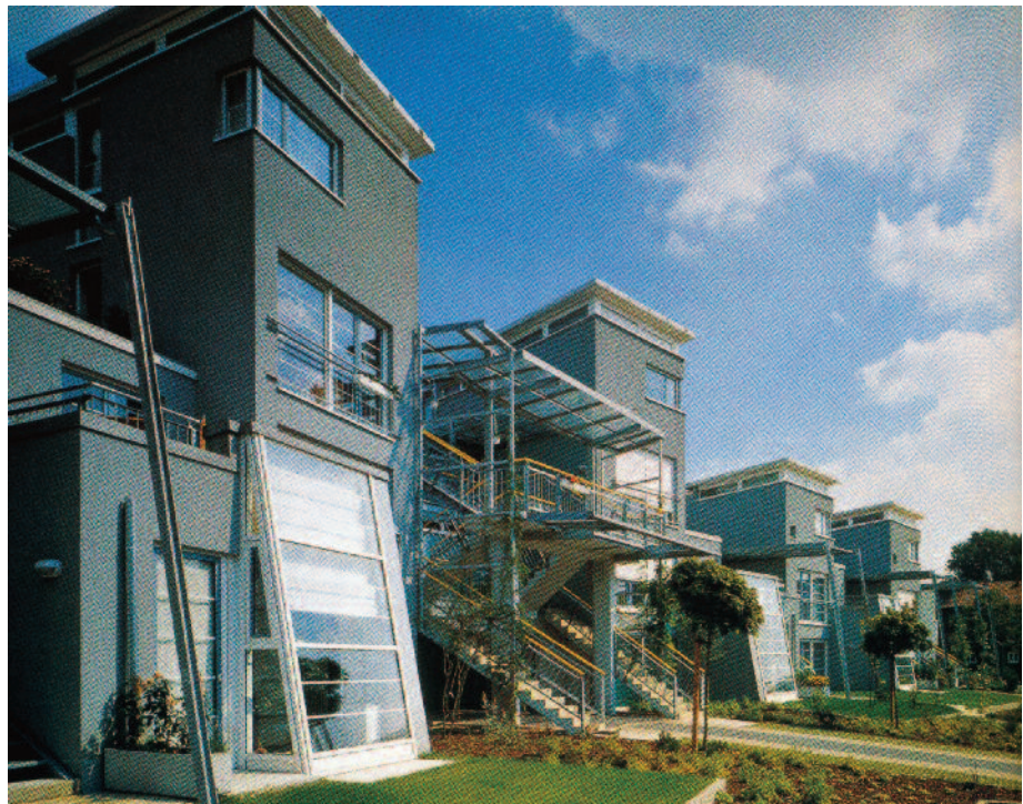
18 particolare della facciata con giardini d'inverno al primo piano
