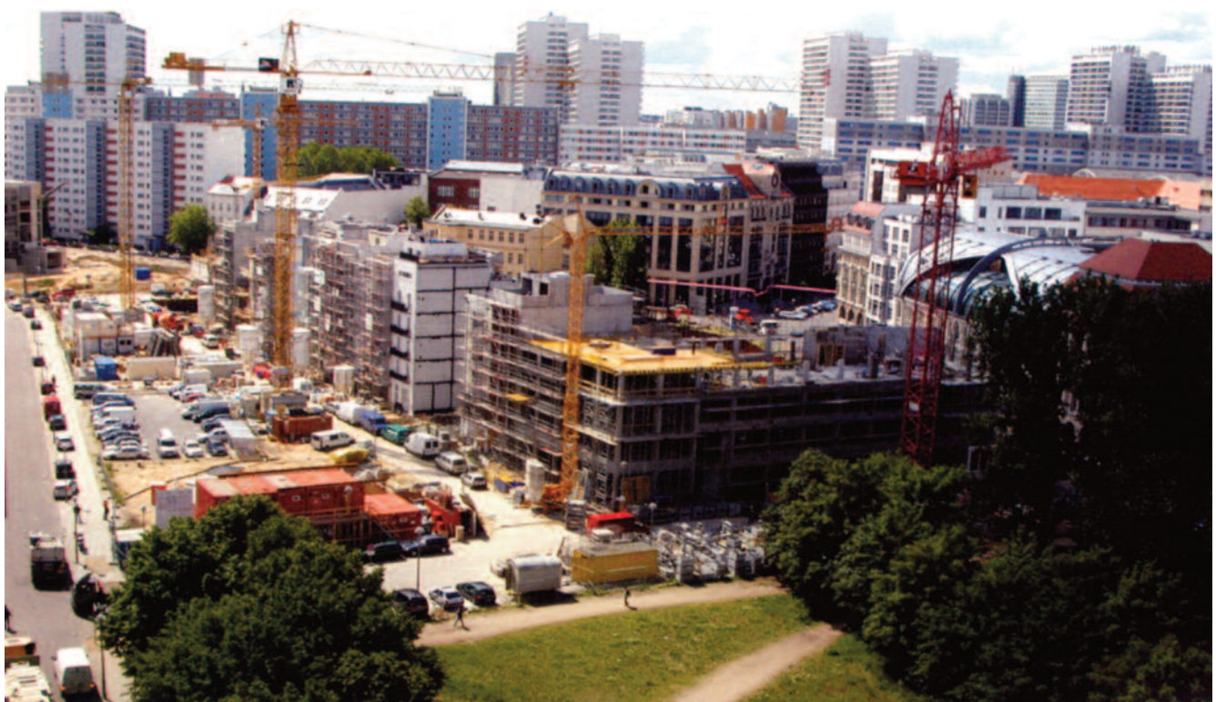
9 cantiere di Townhouses in giugno 2006
