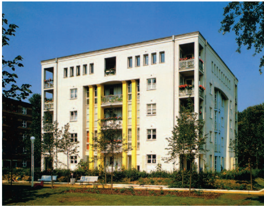
12 edificio 2 - Henry Nielebock, vista dal cortile
