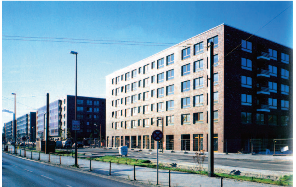
6 le facciate dei quattro blocchi sulla Hauptstrasse
