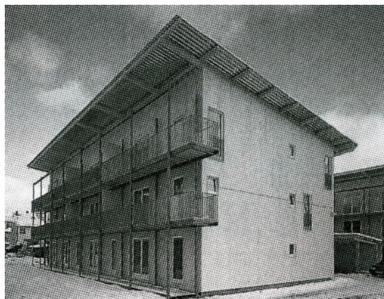
9 scorcio della facciata ovest con i balconi
