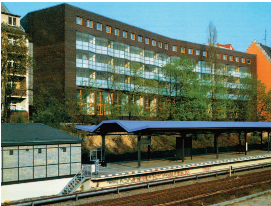
1 facciata verso la ferrovia della S-Bahn e la tangenziale
