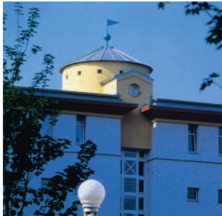
22 edificio 7 - Valentiny / Hermann, particolare della torretta sopra il corpo scala
