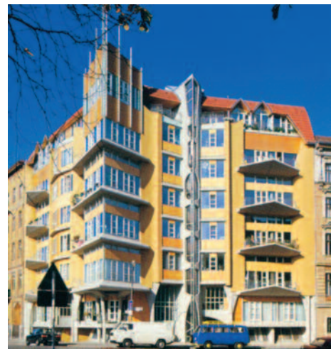
7 vista della casa all'angolo, tra Fraenkelufer e Admiralstrasse
