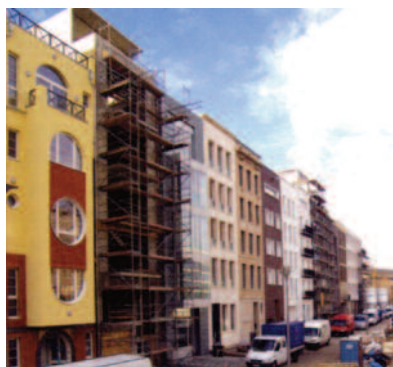
1 Townhouses Friedrichswerder parzialmente ancora in costruzione
