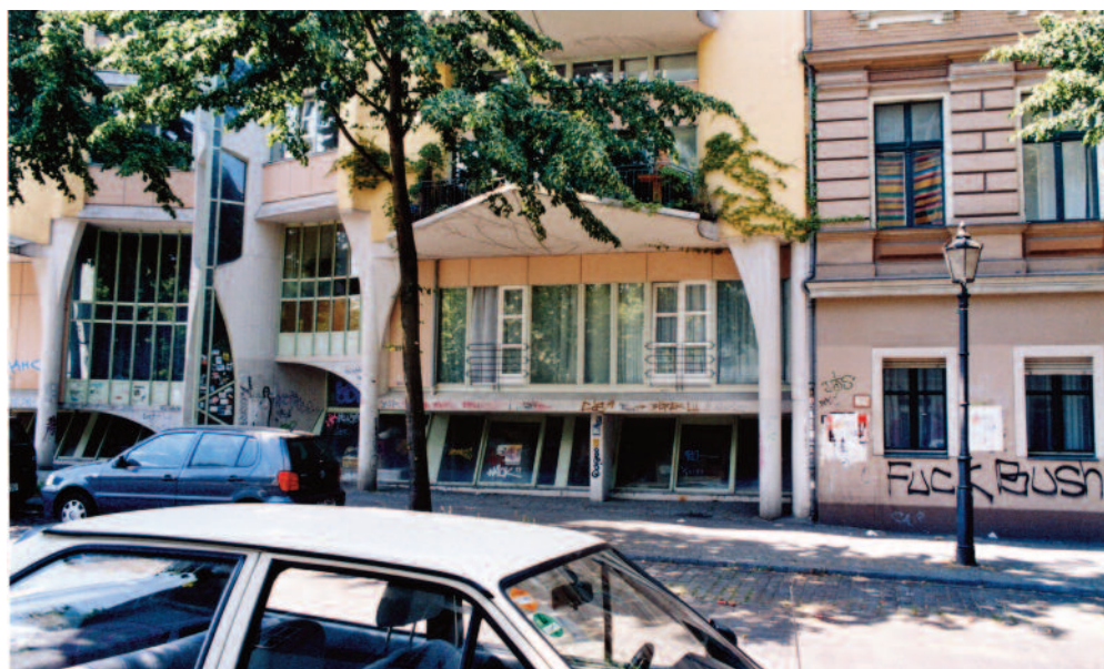
11 particolare della facciata della casa all'angolo sulla Admiralstrasse, (2008)
