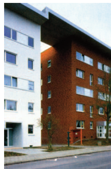
22 particolare della nuova struttura del tetto che copre e riunisce tutti gli edifici ristrutturati da Meier-Scupin e Petzet
