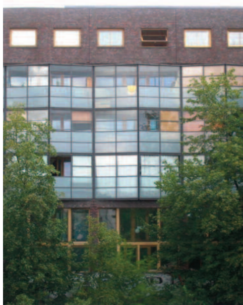
5 facciata verso ferrovia
