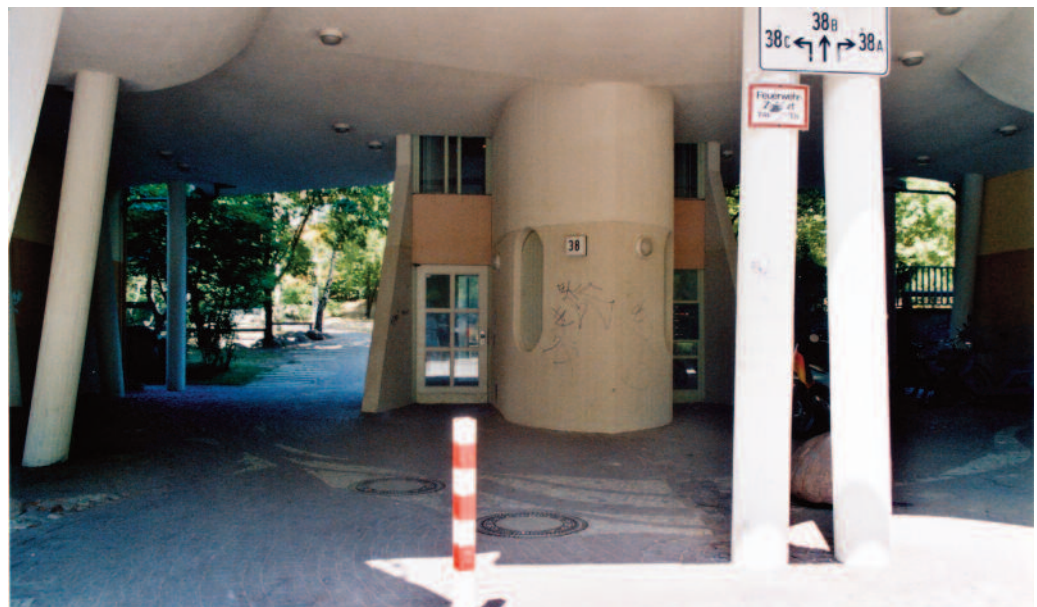
17 particolare del passaggio con l'ingresso del corpo scala
