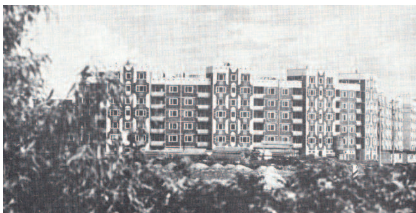
3 vista di edifici curvilinei
