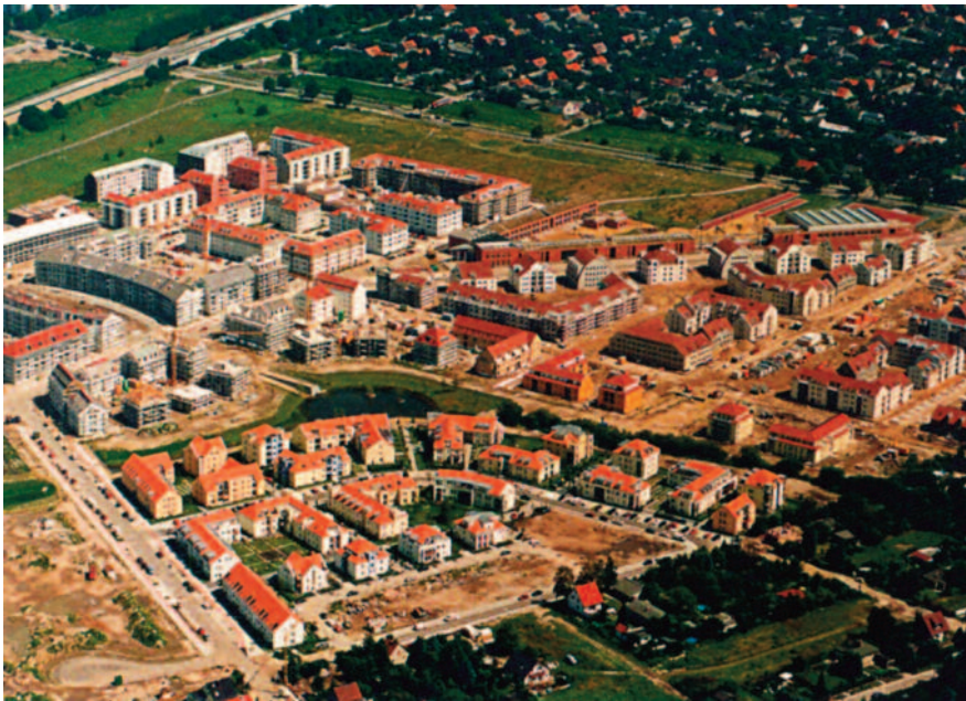
7 vista del cantiere della parte occidentale di Neu-Karow
