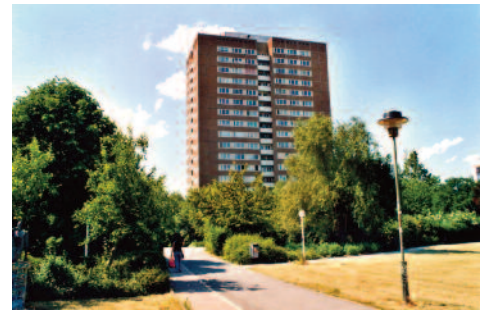
23 edificio residenziale a torre al margine ovest del Wohngebietspark, (2008)
