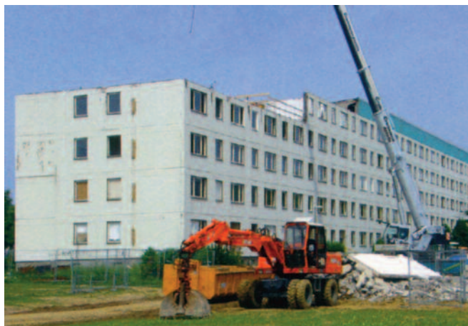
6 cantiere di demolizione, asportazione dell'ultimo piano
