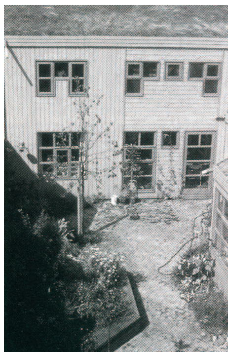
17 facciata verso il giardino interno
