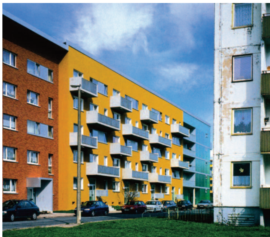
11 vista della facciata est, ristrutturata con l'aggiunta di nuovi balconi che seguono un ritmo somigliante a meandri di un fiume
