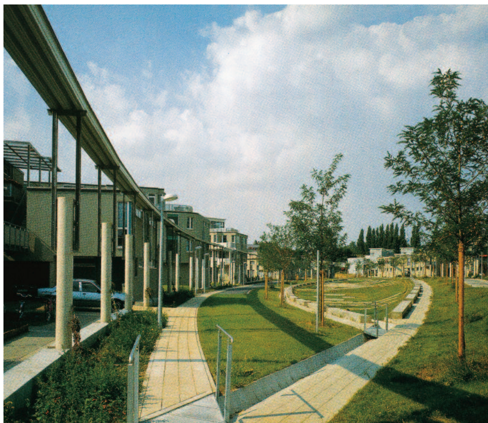
4 acquedotti che conducono l'acqua piovana dai tetti alla "lente"
