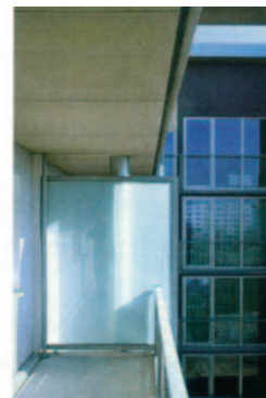
8 alcuni particolari dell'intervento tipo "Low": nuovo portone d'ingresso, pareti scorrevoli, divisori semitrasparenti per i balconi
