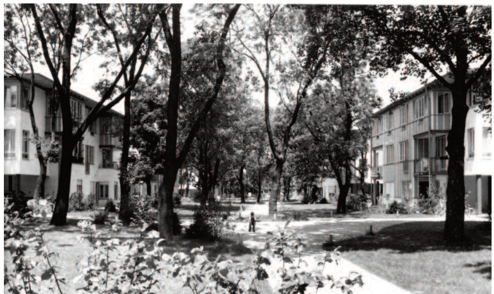
15 parco all'interno del cortile
