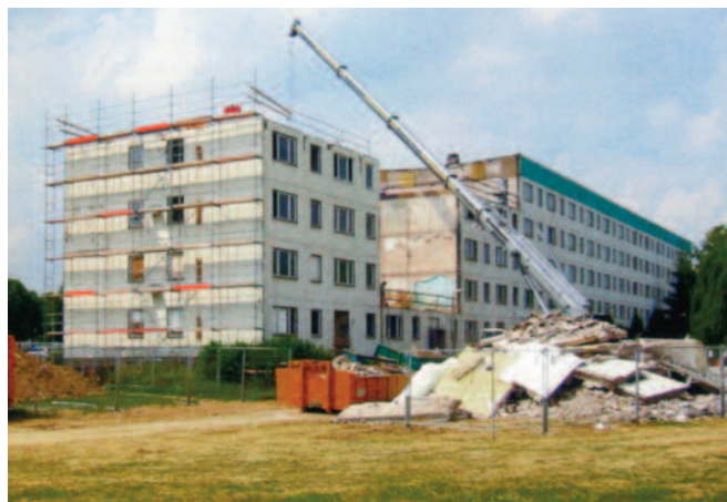
7 cantiere di demolizione, appartamenti intorno ad un corpo scala vengono abbattuti
