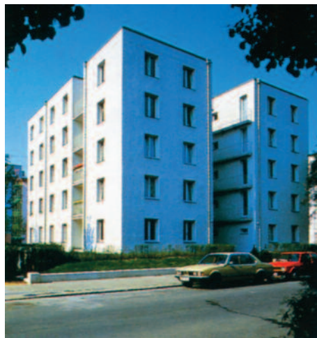
14 edificio 3 - Giorgio Grassi, vista dalla Thomas-Dehler-Strasse
