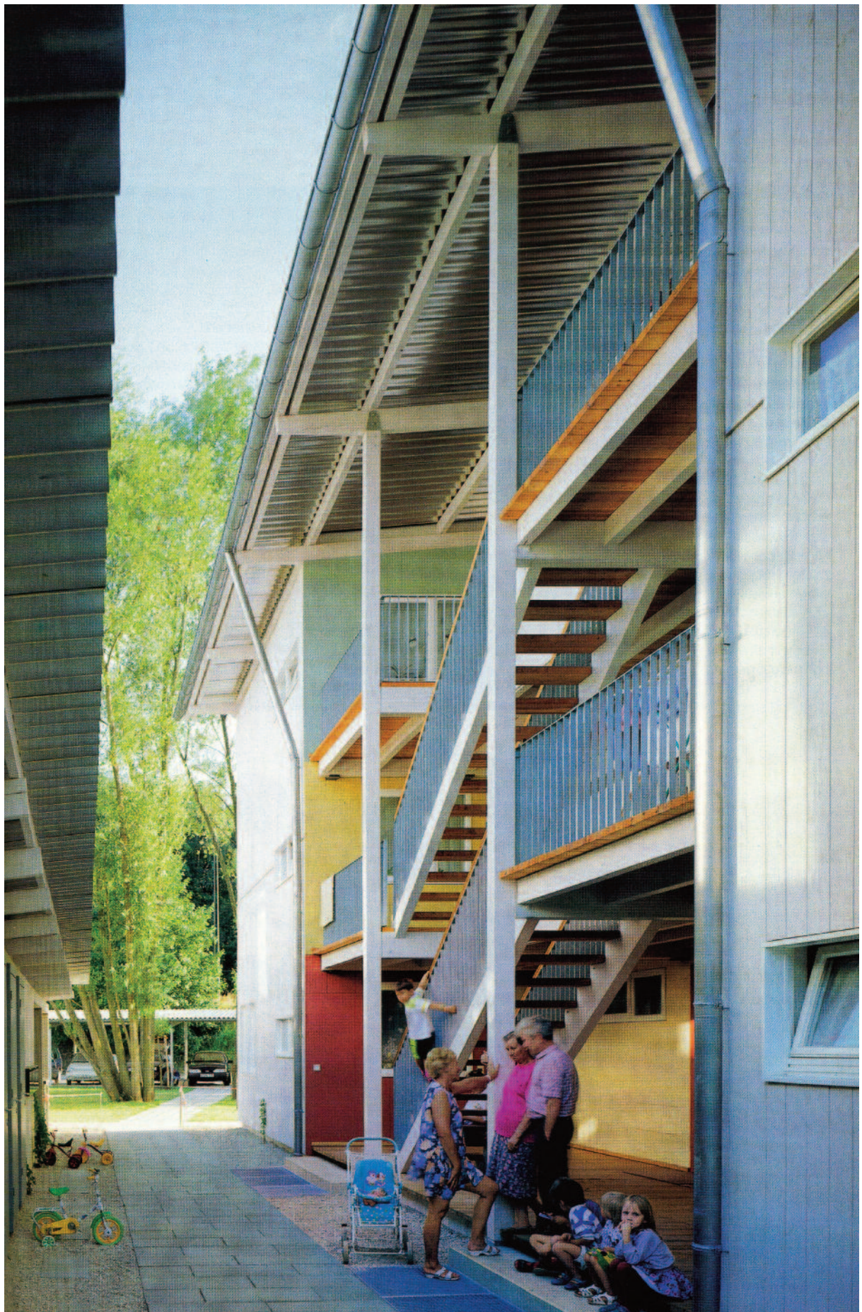
16 vista della loggia d'accesso con la decorazione policromatica delle superfici eseguita dall' artista Helmut Vogl
