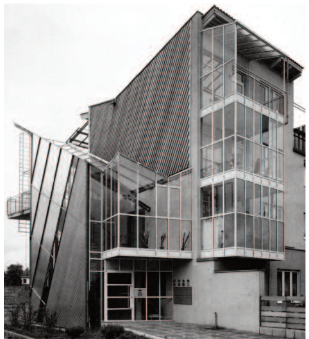
7 corpo scala all'estremità dell'edificio
