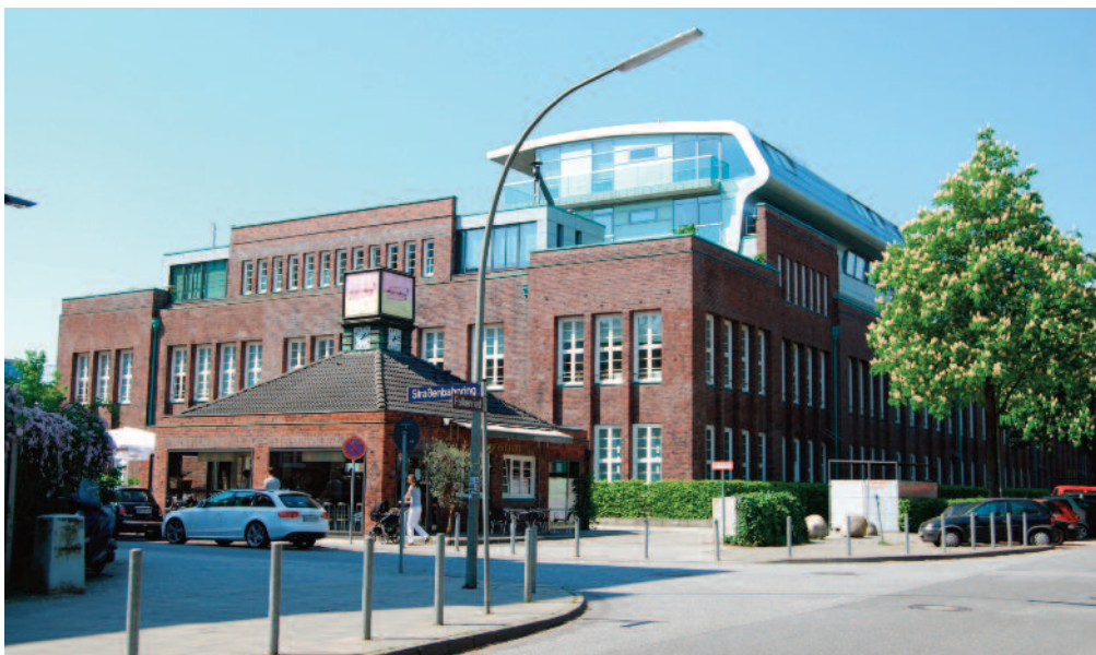
8 riuso dell'edificio amministrativo e aggiunta di una sopraelevazione di BRT Bothe Richter Teherani, in primo piano casa del portiere trasformata in un caffè, (2009)
