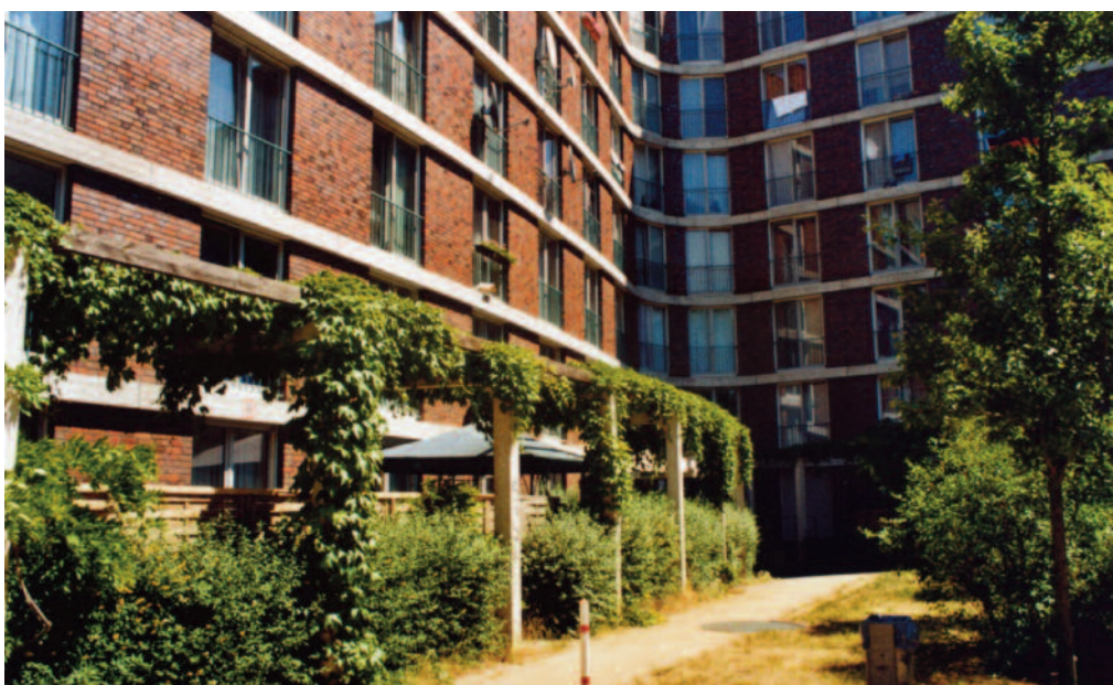
22 particolare del blocco a 'U' che si apre verso ovest, Benedict Tonon, (2008)
