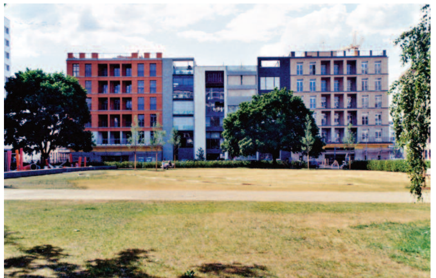
15 Townhouses tra due Eckhaeuser su Alte Leipziger Strasse, in primo piano uno dei due parchi, (2008)
