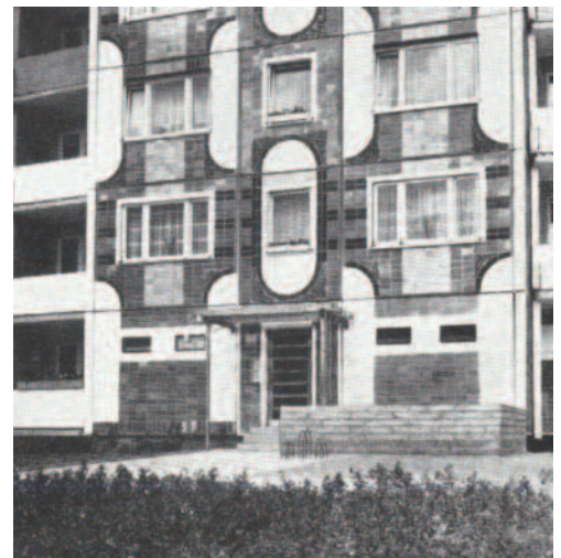
14 particolare della facciata composta da elementi che contengono Klinker
