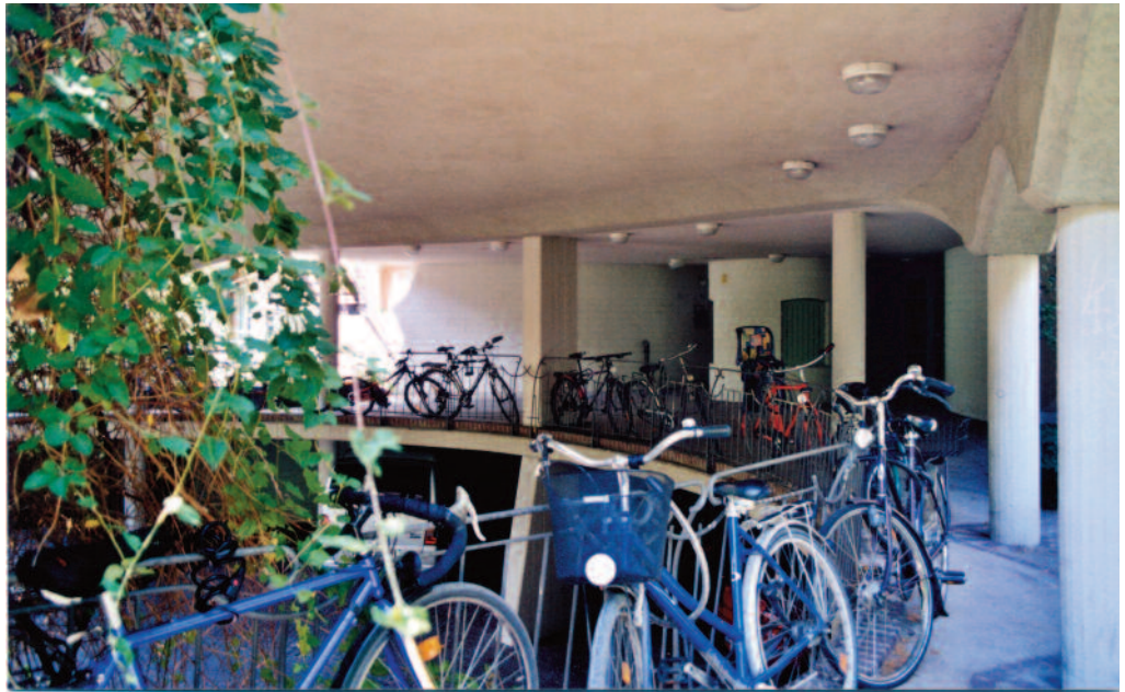
25 soluzione adottata per i parcheggi semiaperti, (2008)
