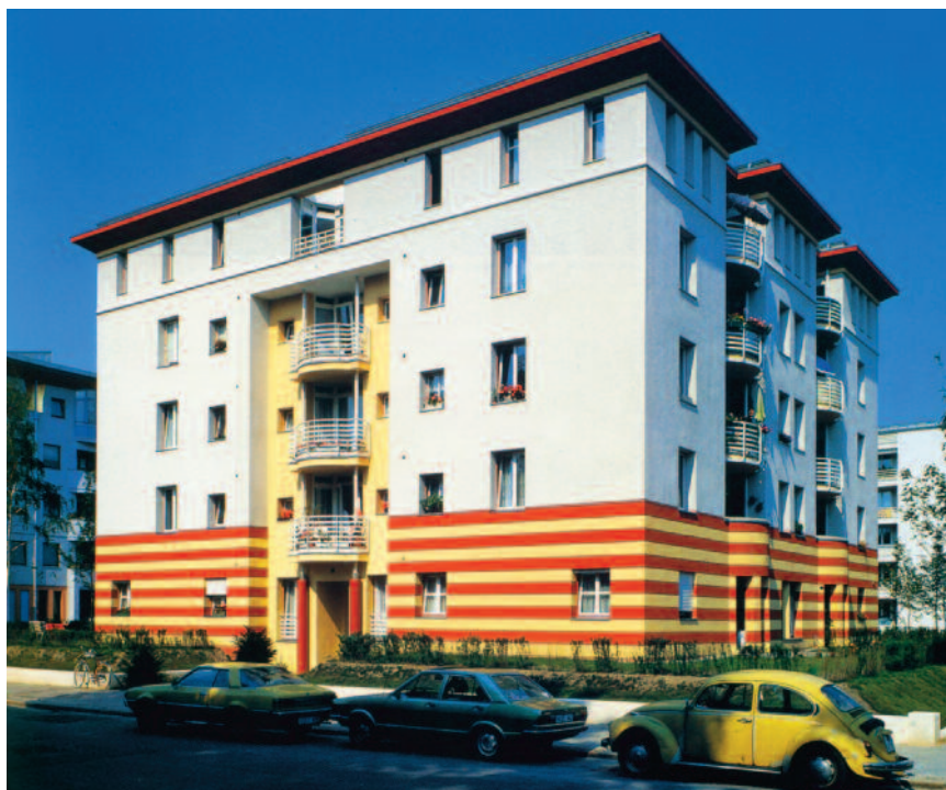
23 edificio 7 - Valentiny / Hermann, vista dalla Rauchstrasse
