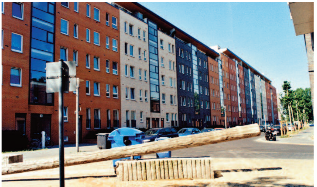
5 scorcio del lato nord del blocco, allusione alle Parzellen (lotti) attraverso differenti colori del materiale di rivestimento, (2008)
