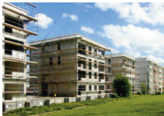
2 demolizione parziale ovvero Rueckbau
