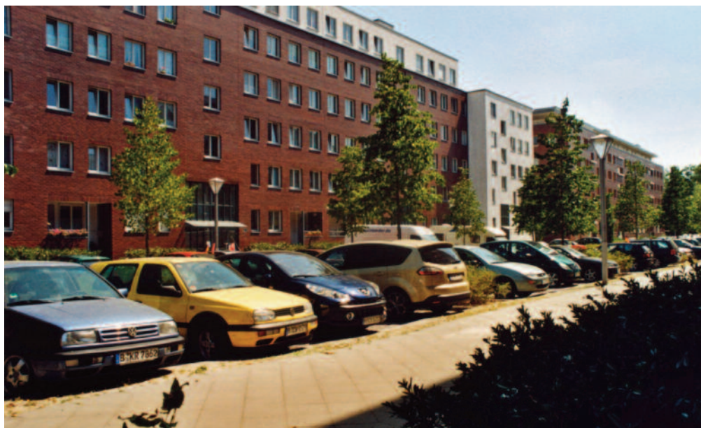
9 vista dei blocchi in linea, (2008)
