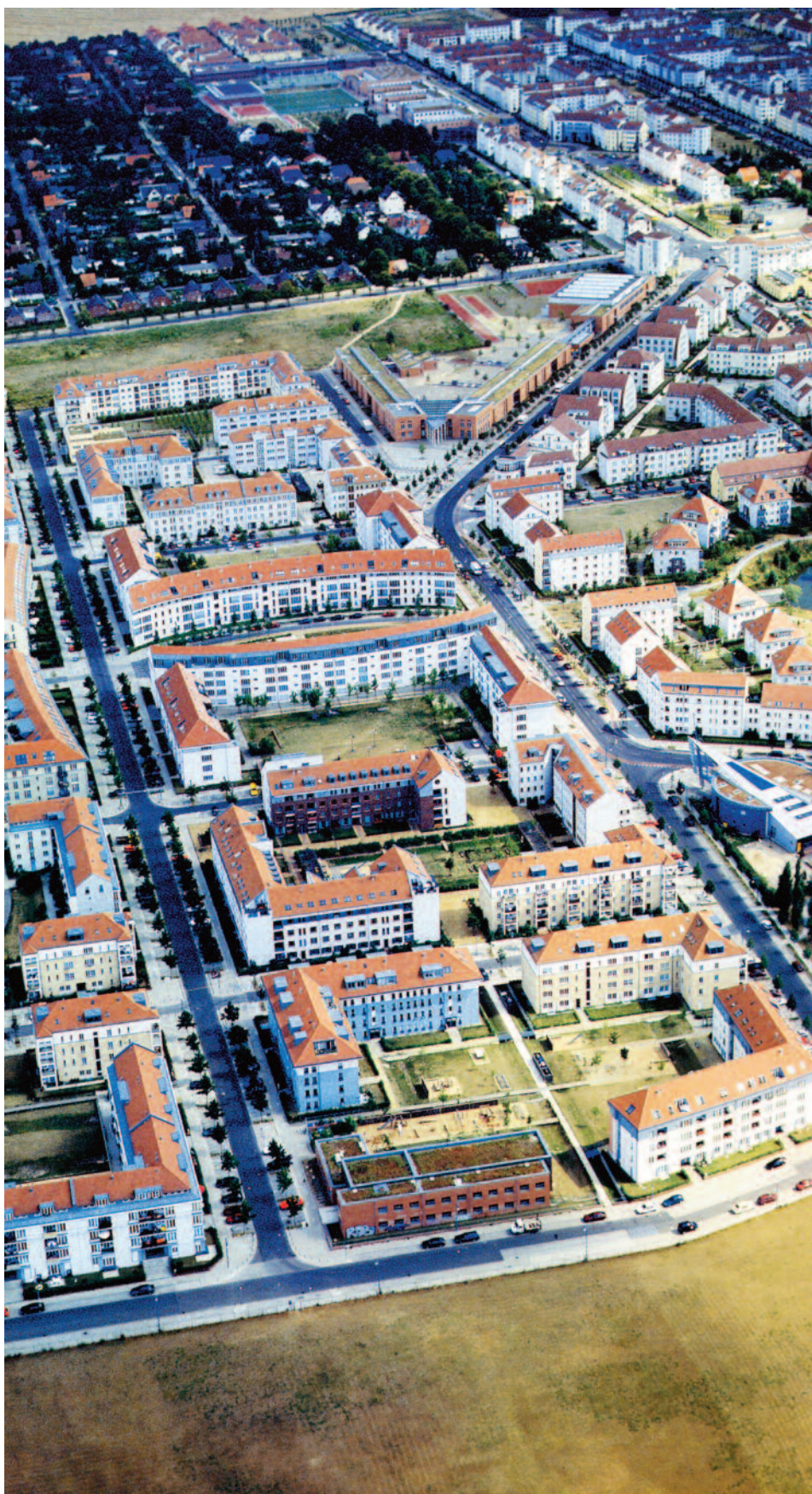
1 vista del quartiere Neu-Karow, in primo piano la parte occidentale, in secondo piano la parte orientale, divise da Alt-Karow Bucher Chaussee
