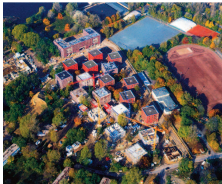
8 Quartier Pulvermühle, vista aerea della parte nord del cantiere
