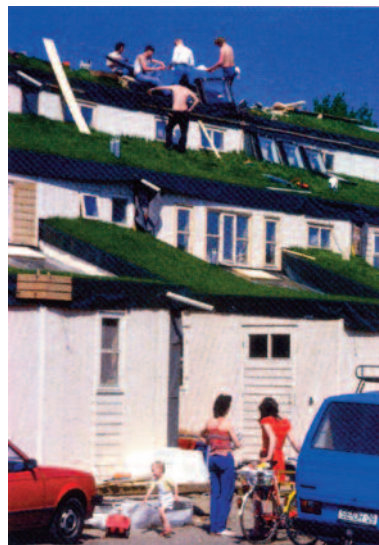
6 partecipazione alla costruzione da parte dei futuri abitanti
