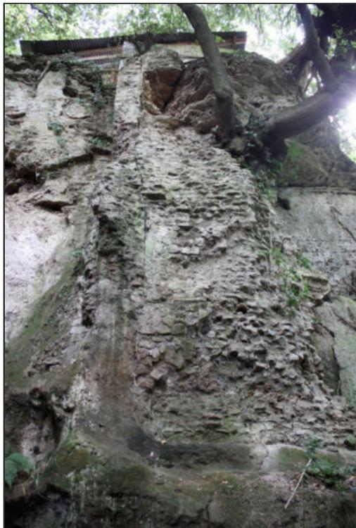
Fig. 39 Sezione della spalla orientale della diga lungo il Fosso di Caipoli con il dettaglio delle fondazioni.
