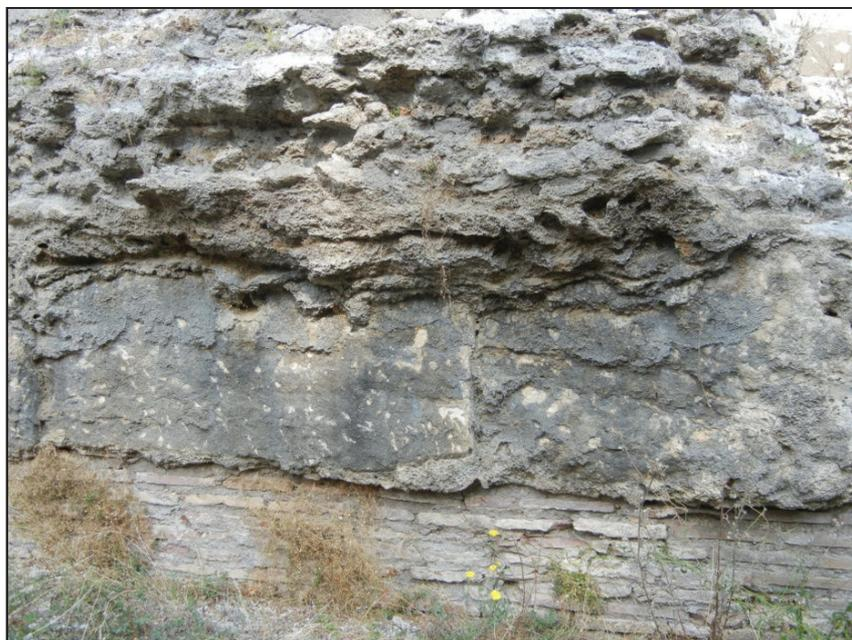
Fig. 57 Particolare delle incrostazioni calcaree depositatesi sulla superficie dell'intradosso di uno degli sfioratori della diga in località S. Clemente.
