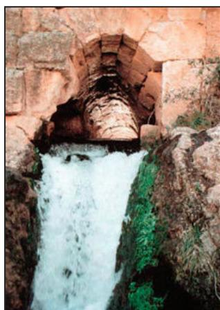
Fig. 19 Apertura a monte dello sfioratore (ARENILLAS PARRA 2002b, fig. 6).
