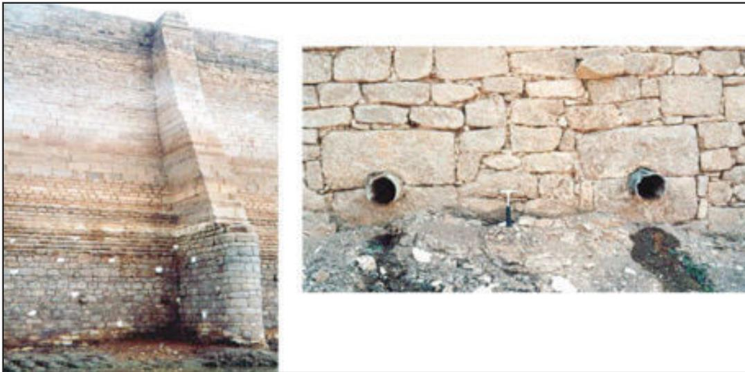
Fig. 27 Lato a monte e prese inferiori della diga di Proserpina, Spagna
