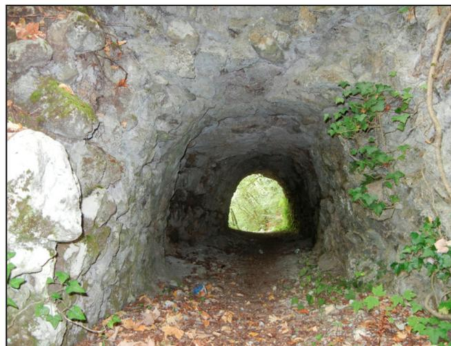
Fig. 66 Canale che attraversa il corpo della diga.
