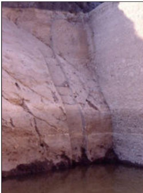
Fig. 32 Uno degli incavi destinati all'ancoraggio delle pareti della diga antica (<http://www.jean.delrieux.free.fr/Barrage/aqueduc.htm>).
