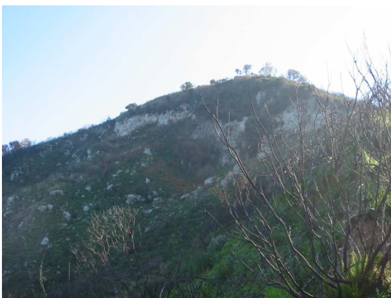
Fig. 2.27 – Detrito di frana costituito da enormi blocchi di breccie di gneiss in matrice calcitica poggianti sul detrito più fine alla base della scarpata di frana. E' presumibile che i blocchi rocciosi in questo settore siano da attribuire ad eventi di crollo dalla scarpata per arretramento della stessa.
