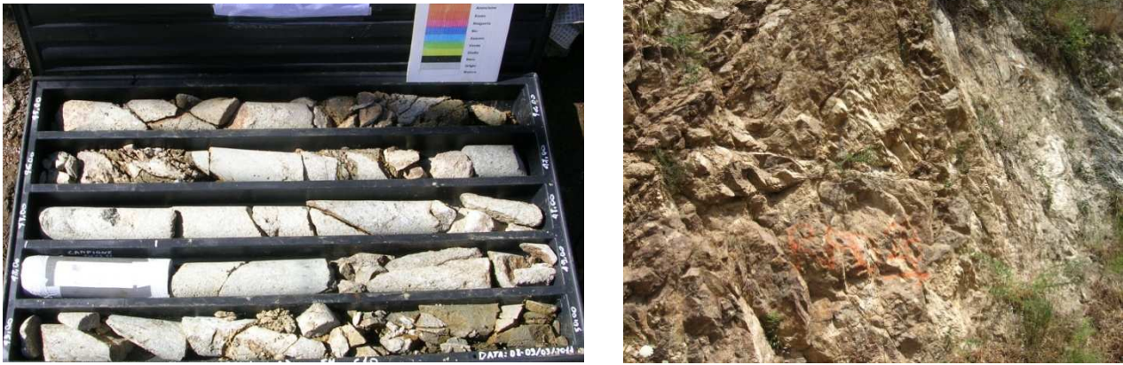
Fig. 2.8 – (A) Carote di gneiss, prelevate a circa 50 m di profondità, mediamente fratturate, ma scarsamente alterate. (B) Gneiss in affioramento, nell'area dove è stato eseguito lo stesso sondaggio, fortemente alterati.
