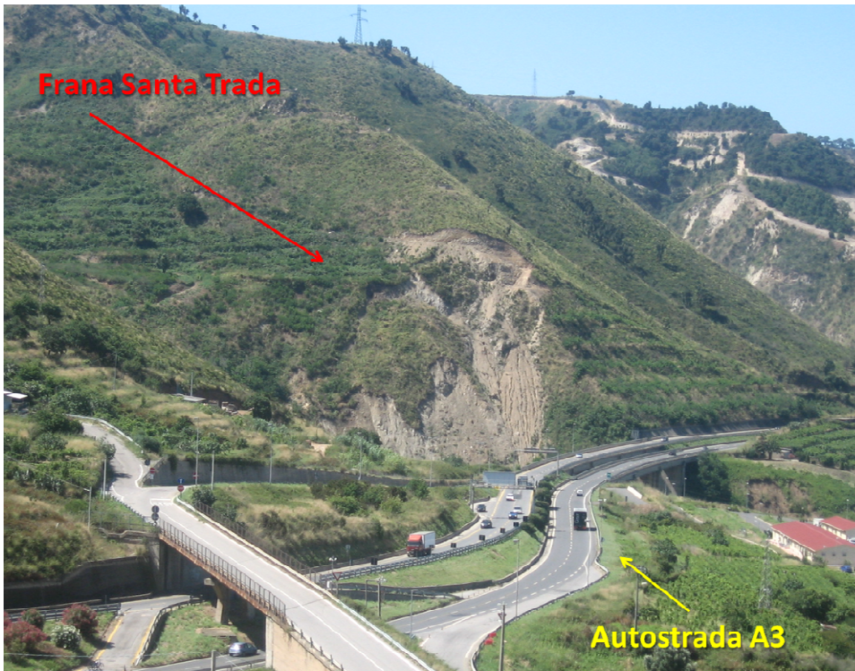
Fig. 2.33 – La frana Santa Trada vista dal versante opposto. Il corpo di frana non intercetta la sede autostradale, ma termina nel sottostante fosso omonimo (Fig. 2.34).
