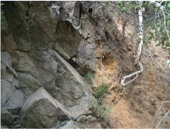
Fig. 2.23 – Ammasso roccioso riferibile al substrato metamorfico (a sinistra), interrotto da un piano perfettamente verticale su cui poggiano i depositi di terrazzo marino (località Catoi).
