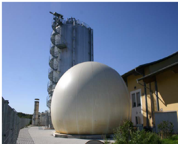
Figura 1.9 Impianto di digestione anaerobica di rifiuti organici di Leonberg, Germania
