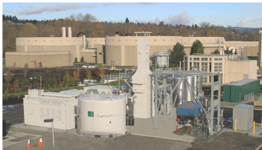
Figura 1.8 Impianto di trattamento delle acque reflue di King County Renton, Washington, USA
