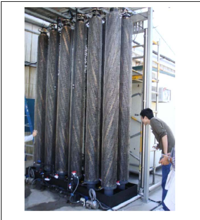
Figura 70 - Impianto pilota di celle a combustibile microbiche alla Foster's Brewery, Australia. Il reattore MFC è costituito da 12 moduli tubulari, e nella figura se ne distinguono 6 tubi su 2 file, dell'altezza di 3 metri, con il catodo all'aria; ha un volume complessivo di circa 1 m 3 ed è già in grado di erogare 1 kW trattando 20 kg di COD da refluo al giorno [146].
