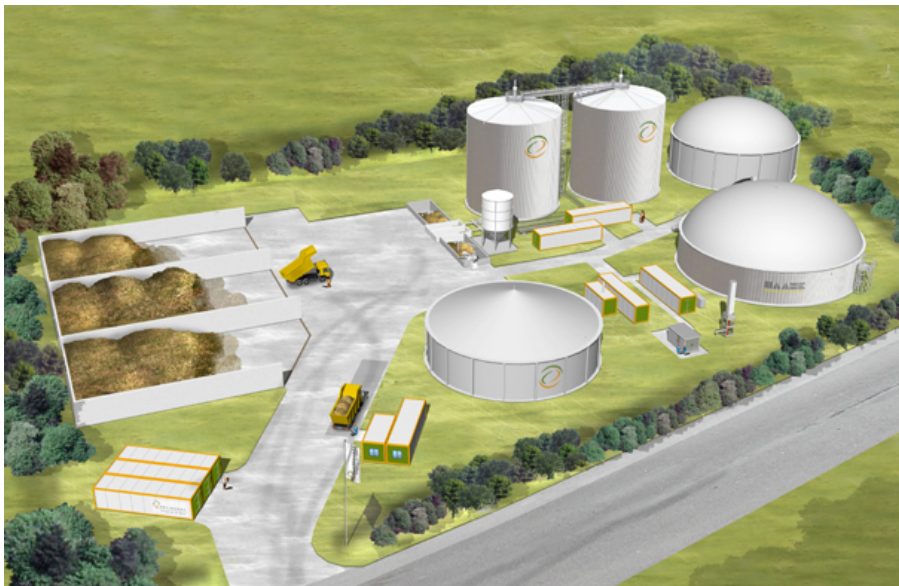
Figura 55 - Impianto di trattamento delle biomasse, dove sono in evidenza i digestori.
