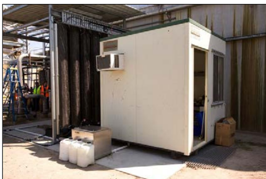
Figura 74 - Immagine con la visione d'insieme dell'impianto con il manufatto della sala di controllo con le pareti di colore bianco, posta nelle immediate vicinanze del reattore.
