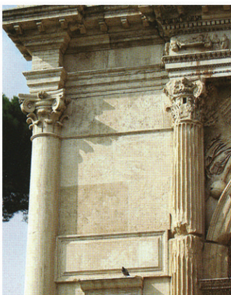
Figg. 53-55 Arco di Tito, Roma : l'intervento cominciato da Raffaele Stern e portato a compimento da Giuseppe Valadier opera differenziando i materiali e semplificando gli ornati.
