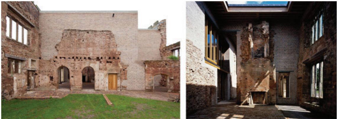
Fig. 5.64 Il nuovo paramento si inserisce nel rudere collimando i lacerti di muratura sopravvissuti all'incendio e al degrado (rispettivamente: a sinistra foto tratta da www.weheart.co.uk e a destra foto di H. Binet tratta da www.europaconcorsi.com ).
