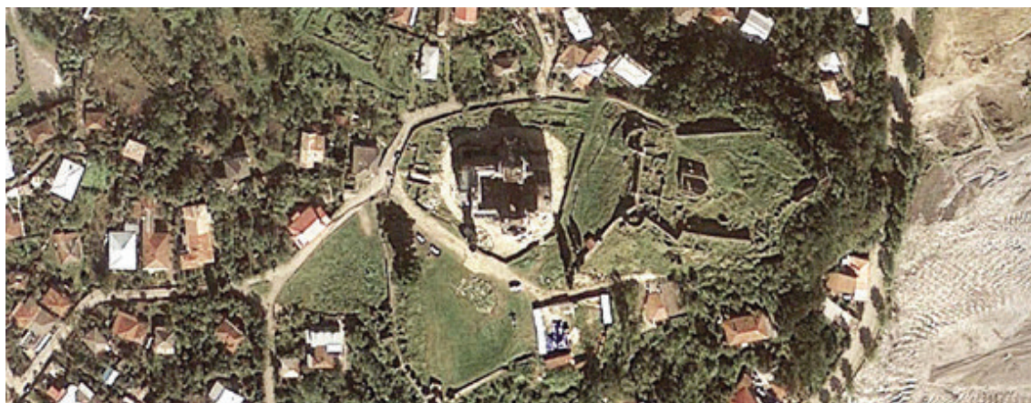
Fig. 5.83 Vista aerea della cattedrale e del suo contesto territoriale prima dell'intervento (foto tratta da: A. BRUNO, Op. cit. , p. 84).
