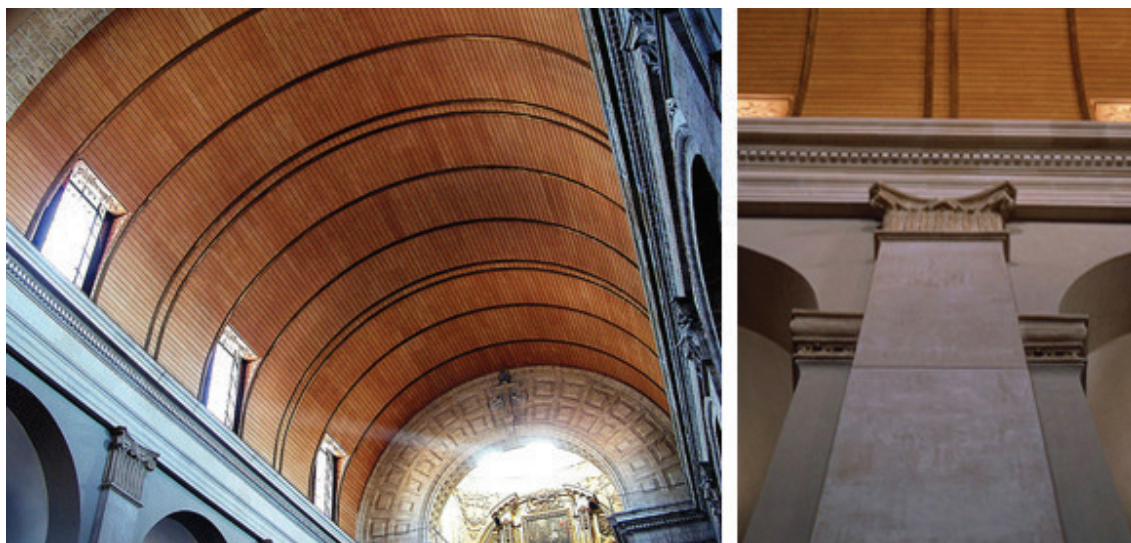
Fig. 5.12 Viste interne d'insieme (sinistra) e di dettaglio (destra) mostrano la riproposizione della volta a botte mediante l'impiego del legno (tratte da www.linazasoro-arquitecto.com ).
