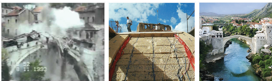
Figg. 146-48 Ponte di Mostar sul fiume Neretva, Bosnia : intervento General Engineering WorkGroup di Firenze (2002-04).
