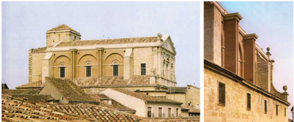
Fig. 5.11 Da sinistra: vista laterale della chiesa dopo la chiusura della lacuna e dettaglio del paramento esterno in corrispondenza della reintegrazione muraria (immagini tratte da www.linazasoro-arquitecto.com ).
