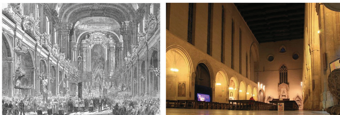
Figg. 81-82 Chiesa di Santa Chiara, Napoli : la fastosa veste barocca risulta gravemente danneggiata in seguito al bombardamento del 1943 e al conseguente incendio; nel corso dei restauri viene messa in luce da Giorgio Rosi e Antonino Rusconi la facies trecentesca, di cui si restituisce il severo aspetto.
