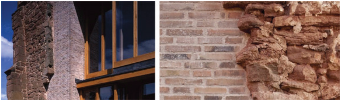
Fig. 5.70 Dettagli dell'attacco fra rudere e nuovo paramento murario (foto tratte rispettivamente da: www.landmarktrust.org.uk e da www.architectural-review.com ).
