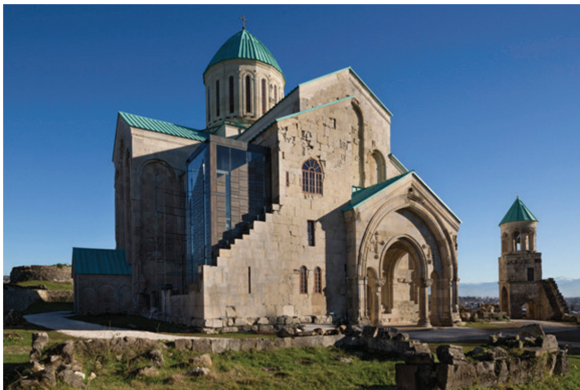
Fig. 5.81 La cattedrale di Bagrati dopo l'intervento di restauro (foto tratta da: A. BRUNO, Cattedrale di Bagrati a Kutaisi in Georgia in "Paesaggio urbano", Maggioli, Santarcangelo di Romagna (RN) 2013, anno XXII, n. 2 (marzo-aprile), p. 90).
