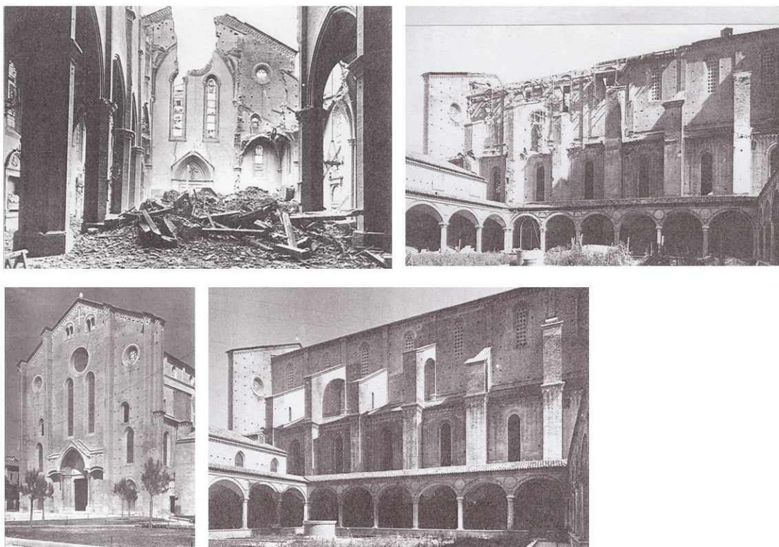
Figg. 77-80 Basilica di San Francesco, Bologna : bombardata ripetutamente nel 1943, la fabbrica viene mutilata di gran parte della navata, riportando gravissimi danni anche alla facciata. Il soprintendente Alfredo Barbacci riutilizza quanto recuperabile, impiegando anche cemento armato.
