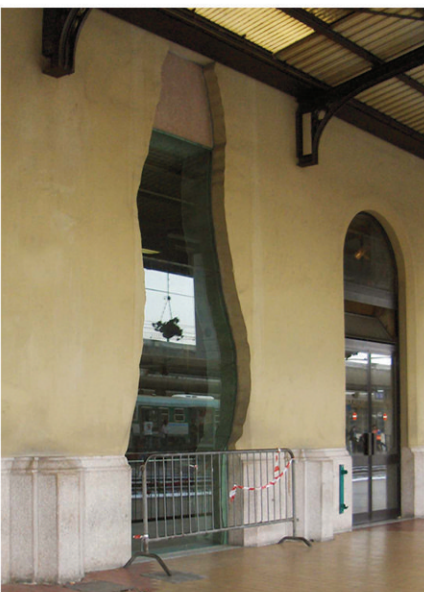
Figg. 18-19 Stazione ferroviaria centrale, Bologna . Dopo l'attentato dell'agosto 1980, in fase di ricostruzione si decide di tenere memoria dell'evento attraverso la conservazione del profilo lacerato della muratura in corrispondenza dello scoppio della bomba.
