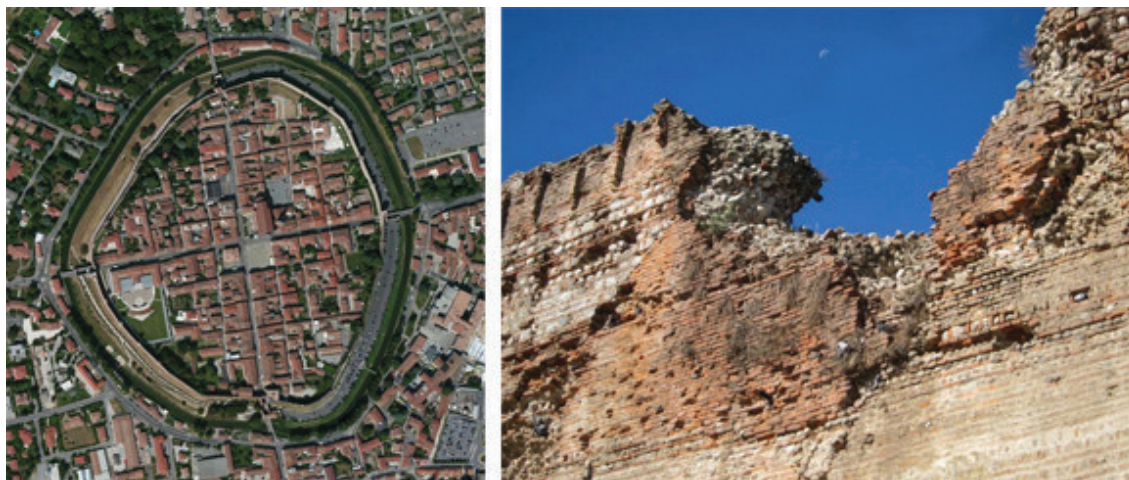
Fig. 5.15 A sinistra: ortofotopiano dell'abitato di Cittadella con evidenziazione delle mura (foto tratta da: www.vallearchitettura.it ). A destra: le condizioni delle mura prima dell'intervento mostrano la presenza di ampie lacune nel paramento (foto tratta da: www.lares-restauri.it ).
