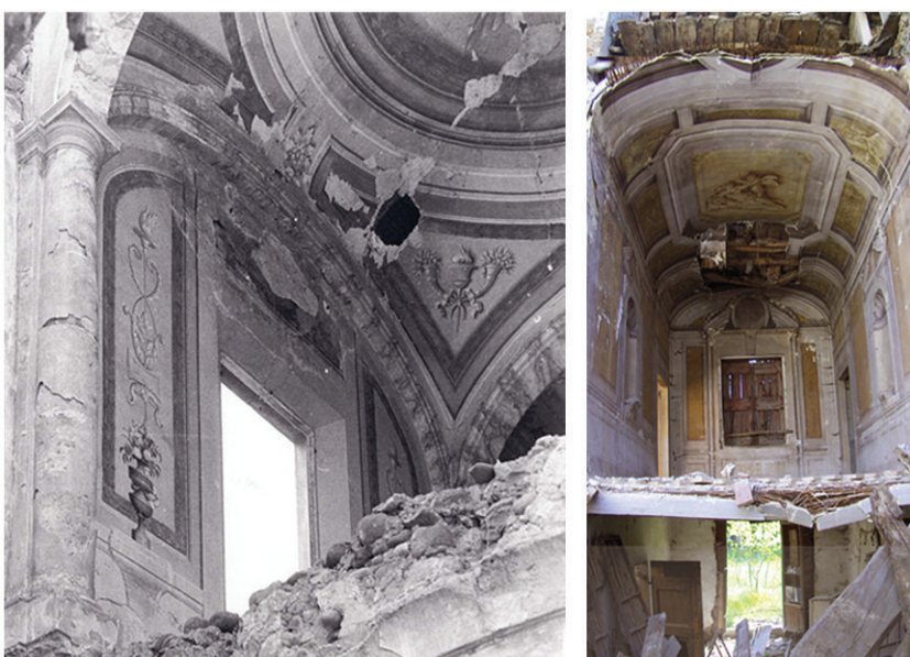
Figg. 12-13 Complesso monumentale di Colle Ameno a Sasso Marconi (BO) , ala sud e palazzina Davia: la perdita fisica di materia può innescare svariati problemi di conservazione.
