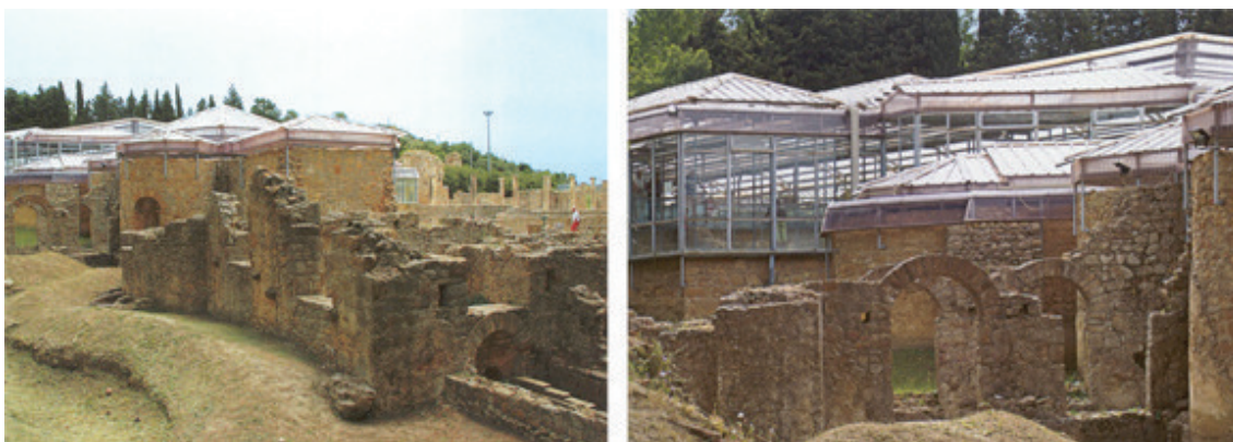
Fig. 5.4 Viste esterne dei ruderi della villa, sormontate dalle strutture metalliche e dagli elementi in perperx (foto B. Vivio, 2005 tratta da G. CARBONARA, Restauro del moderno e archeologia a Piazza Armerina. La sistemazione di Franco Minissi della Villa Romana del Casale in "Paesaggio urbano", Maggioli, Santarcangelo di Romagna (RN) 2006, anno XV, n. 1 (gennaio/febbraio), p. 33 e foto tratta da N. SANTOPUOLI, Op. cit. , p. 41).
