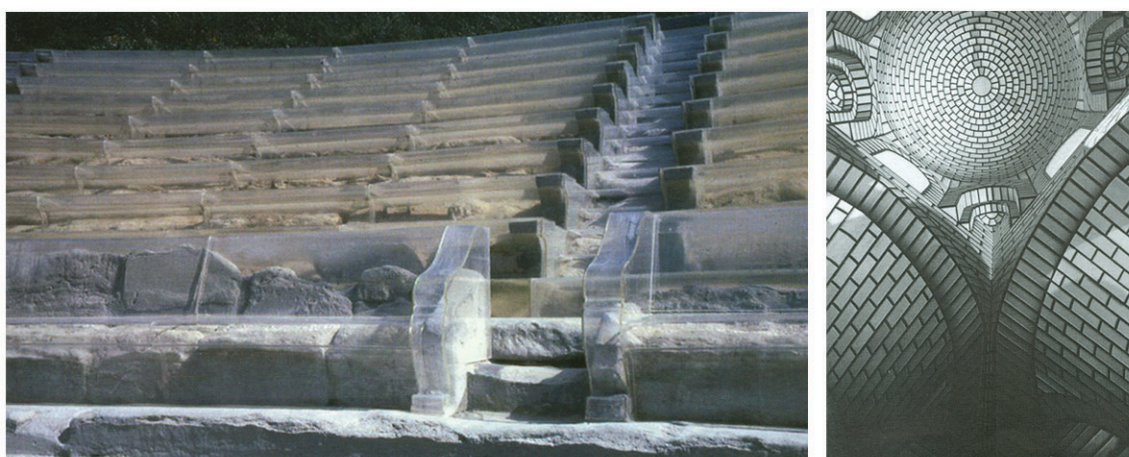
Fig. 121 Teatro greco di Eraclea Minoa (AG) : intervento di protezione realizzato da Franco Minissi (1960-63).
