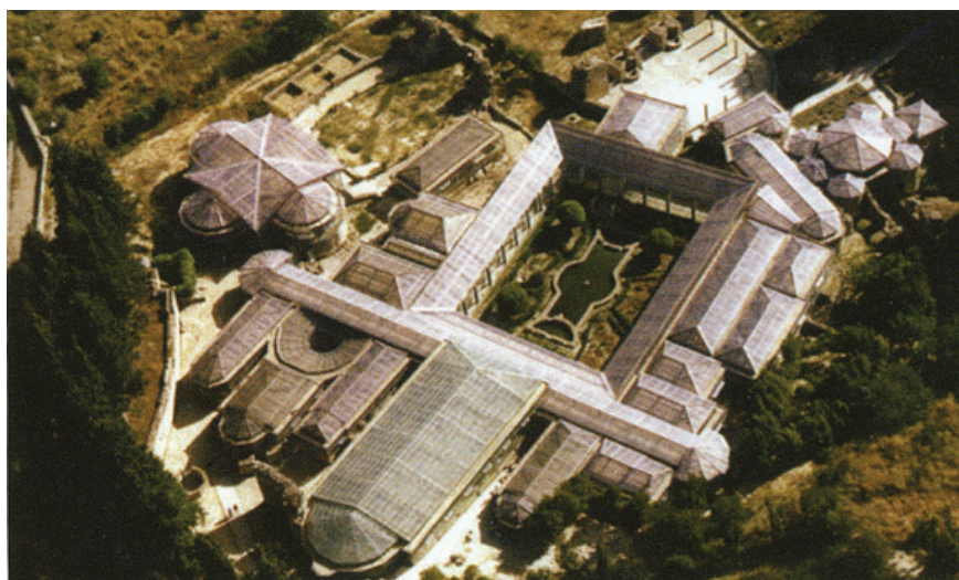
Fig. 5.2 Vista d'insieme dell'intervento dall'alto (foto tratta da G. CARBONARA, Architettura d'oggi e restauro. Un confronto antico-nuovo , UTET, Torino 2011, p. 121).
