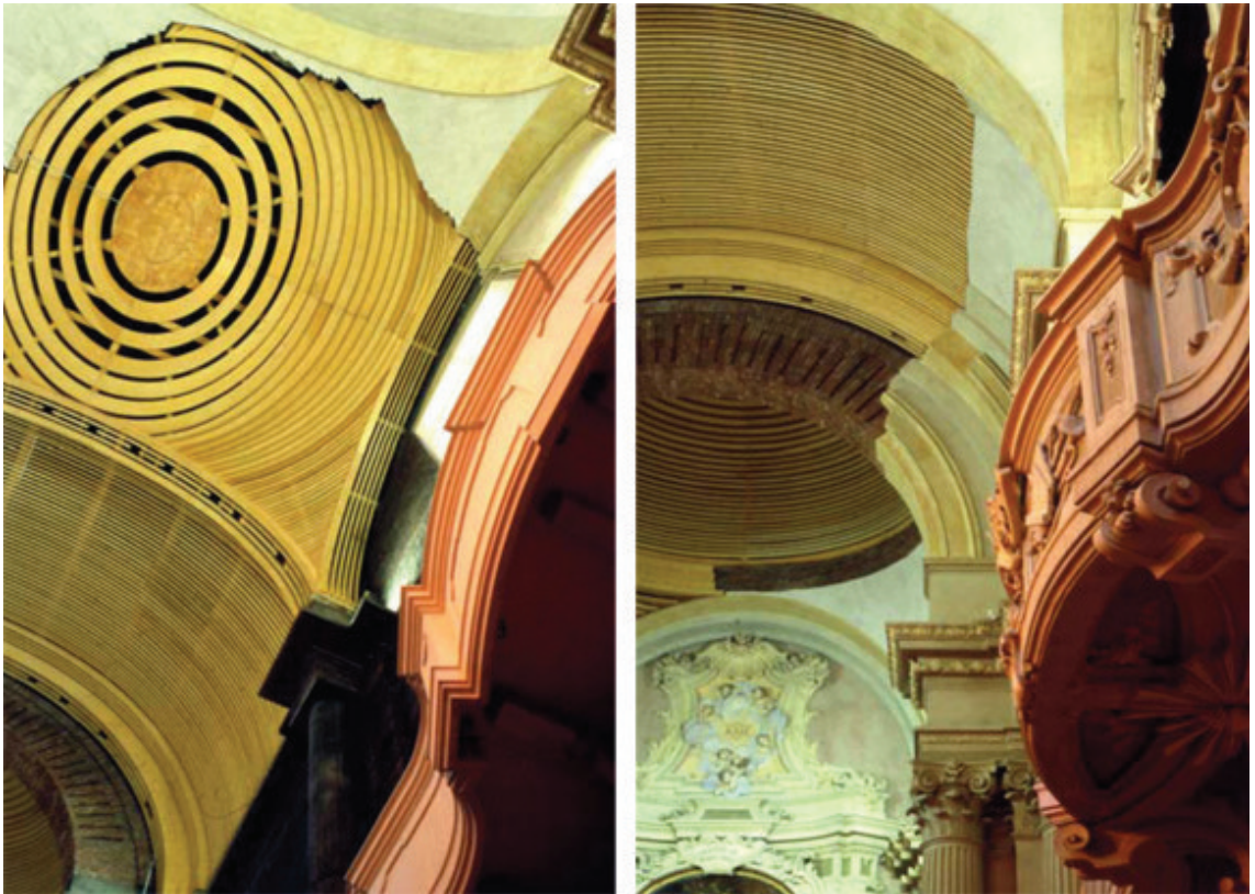
Fig. 5.32 Dettagli delle volte alla fine dei lavori (immagini tratte dalla presentazione del contributo di P.L. Cervellati dal titolo Auditorium San Filippo Neri. Un intervento di recupero e di reinterpretazione del patrimonio storico nell'ambito del convegno "Costruite in sicurezza con il legno su terreni sensibili" , Perugia 8 maggio 2009).
