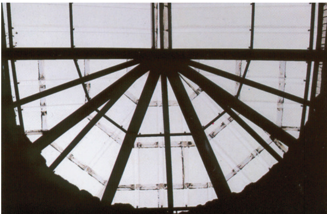
Fig. 5.7 Vista della struttura di copertura dal basso (foto tratta da N. SANTOPUOLI, Op. cit. , p. 45).
