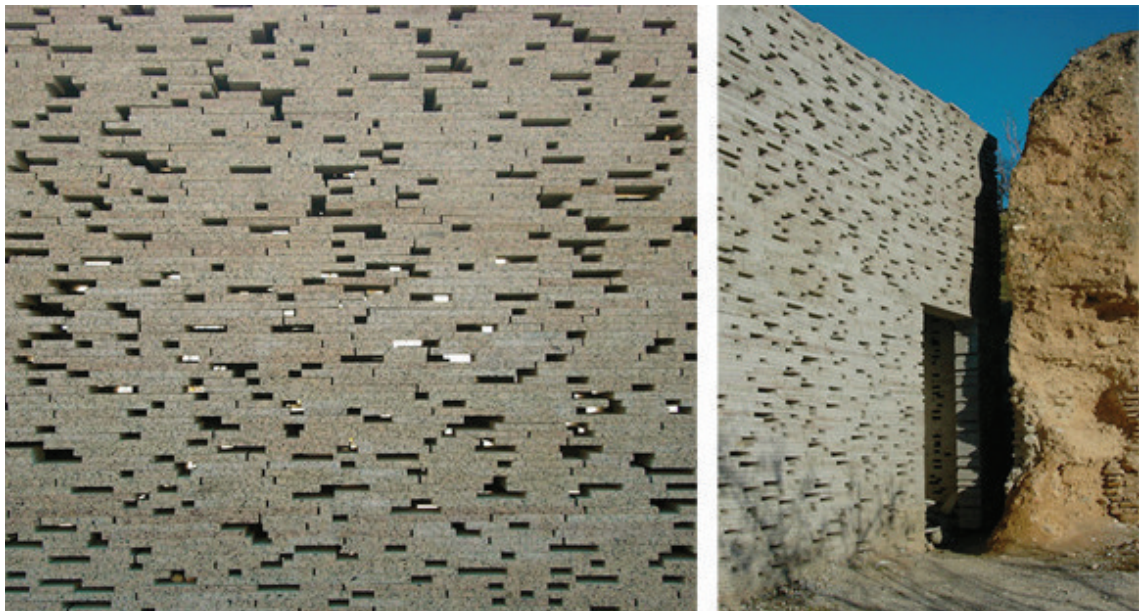
Fig. 5.40 Il nuovo paramento visto dall'esterno e il rapporto fra muratura antica ed elemento aggiunto (foto tratte da: www.urbanity.es ).
