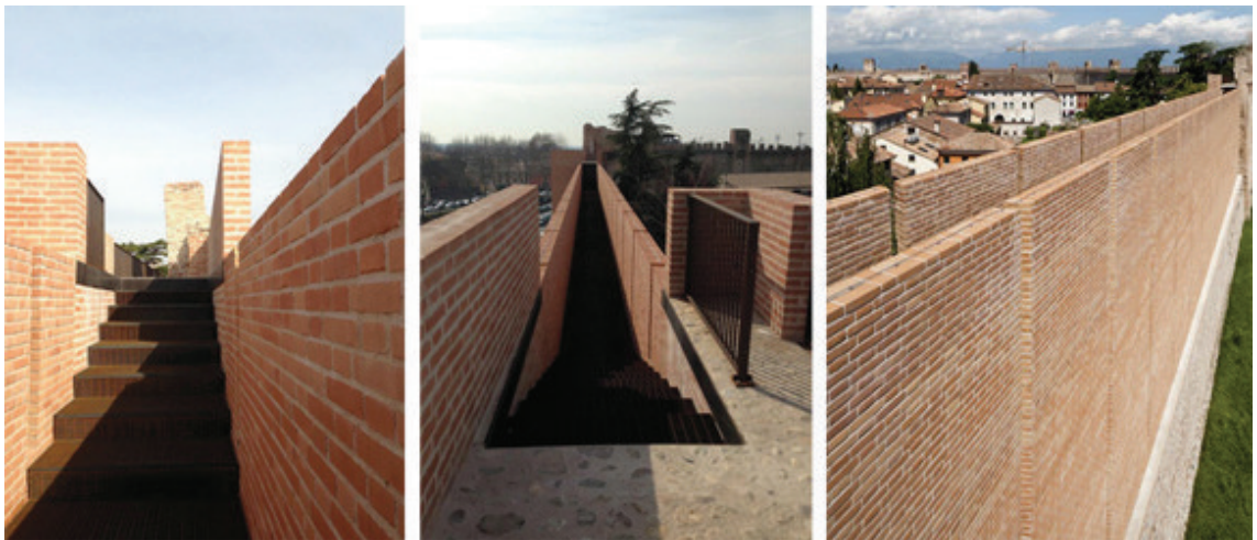
Fig. 5.21 Particolari delle mura restaurate, in corrispondenza del tratto reintegrato ( www.vallearchitettura.it ).
