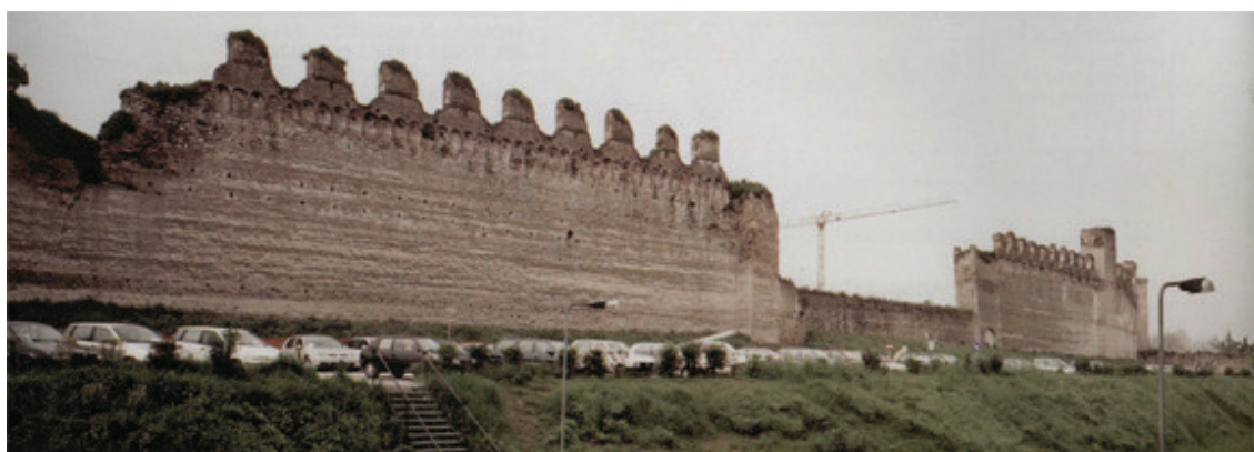
Fig. 5.16 Le mura di Cittadella prima dell'intervento. Si noti la vasta lacuna che affligge un'intera porzione di muro (foto tratta da: M. MONTUORI, Masse fabbricative e reintegrazione delle lacune in "Paesaggio urbano", Maggioli, Santarcangelo di Romagna (RN) 2014, anno XXIII, n. 2 (aprile), p. 24).
