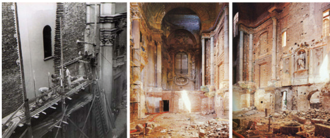
Fig. 5.27 A sinistra: i lavori di restauro avviati nel 1949 e sospesi nel 1953 per mancanza di fondi. Al centro e a destra: le condizioni dell'oratorio cinquant'anni dopo, prima dell'inizio dell'intervento finanziato dalla Fondazione del Monte (foto tratte da: P. L. CERVELLATI, Op. cit. , 2000b, rispettivamente pp., 60, 64 e 65).
