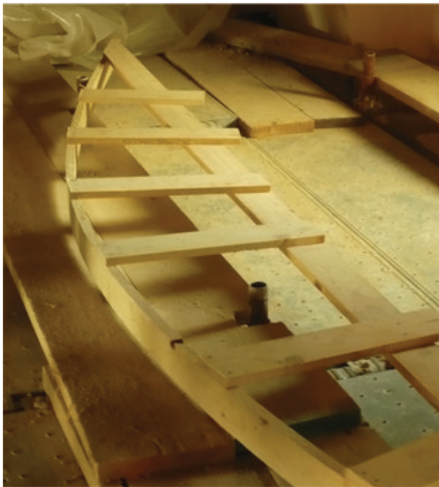
Fig. 5.78 Sopra: schizzi di studio della struttura di centine lignee; sotto, da sinistra: sagoma realizzata in cantiere per il taglio delle tavole di legno in modo da ottenere la curvatura voluta e centine pronte per la messa in opera (foto A. Alvisi, 2011).
