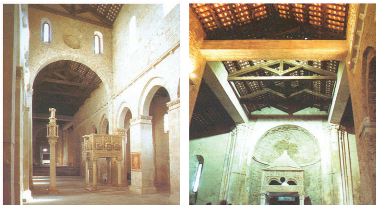
Figg. 65-66 Badia di San Clemente a Casauria (PE): nell'ambito dell'intervento di restauro, dopo aver elaborato un'ipotesi ricostruttiva del suo stato originario, Carlo Ignazio Gavini si attiene al postulato del minimo intervento, evitando di riproporre le parti perdute e risolvendo la connessione fra le navate e il transetto con l'inserimento di travi in cemento armato a vista.
