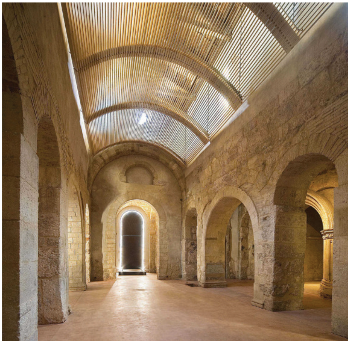
Fig. 5.44 Vista della navata principale dall'abside in direzione dell'ingresso est; in primo piano il controsoffitto ligneo di reintegrazione della lacuna (foto L. Rubino, tratta da: www.europaconcorsi.com ).
