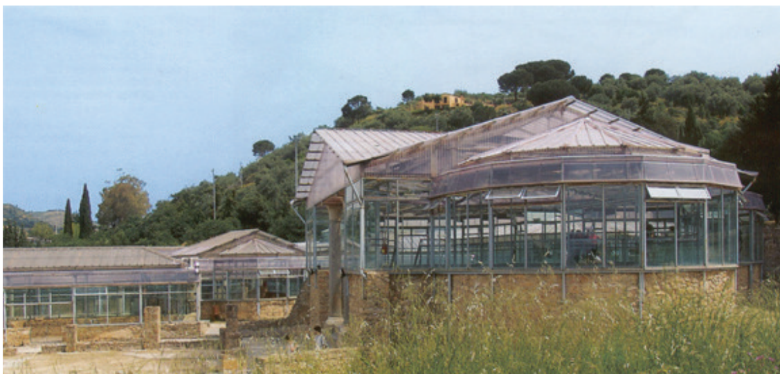
Fig. 5.1 Vista generale del complesso archeologico di Villa Casale a Piazza Armerina, dopo l'intervento di Franco Minissi (immagine tratta da N. SANTOPUOLI, Il restauro della Villa Romana del Casale di Piazza Armerina. Struttura e aggiornamento tecnologico in "Paesaggio urbano", Maggioli, Santarcangelo di Romagna (RN) 2006, anno XV, n. 1 (gennaio/febbraio), p. 41).
