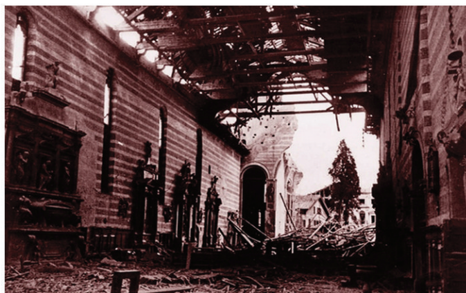
Figg. 74-76 Chiesa degli Eremitani di Sant'Agostino, Padova : la fabbrica costruita fra il XIII e il XIV secolo, bombardata nel 1944, perde gran parte della decorazione pittorica parietale. Le parti crollate vengono ricostruite, ancora ad opera di F. Forlati, mentre la reintegrazione dei dipinti viene forse eccessivamente semplificata.
