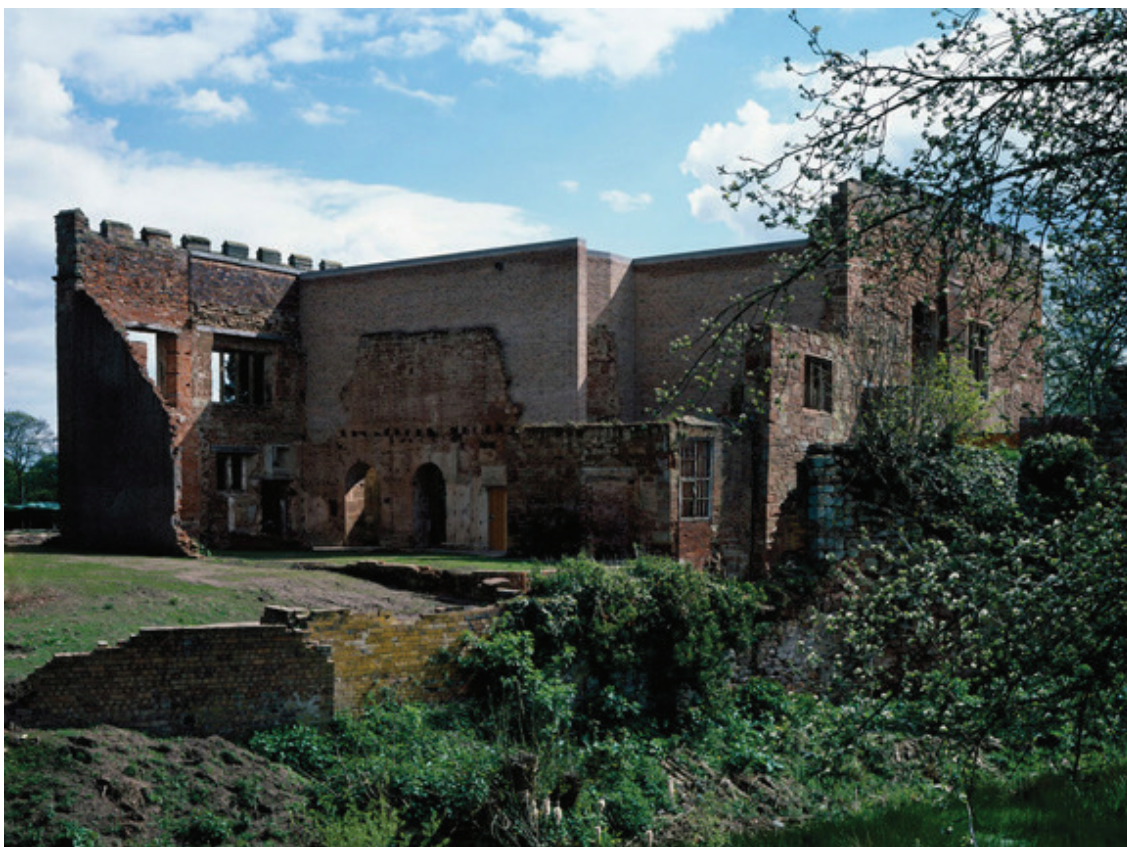
Fig. 5.58 Vista del castello dopo l'intervento (foto H. Binet, tratta da: www.europaconcorsi.com ).
