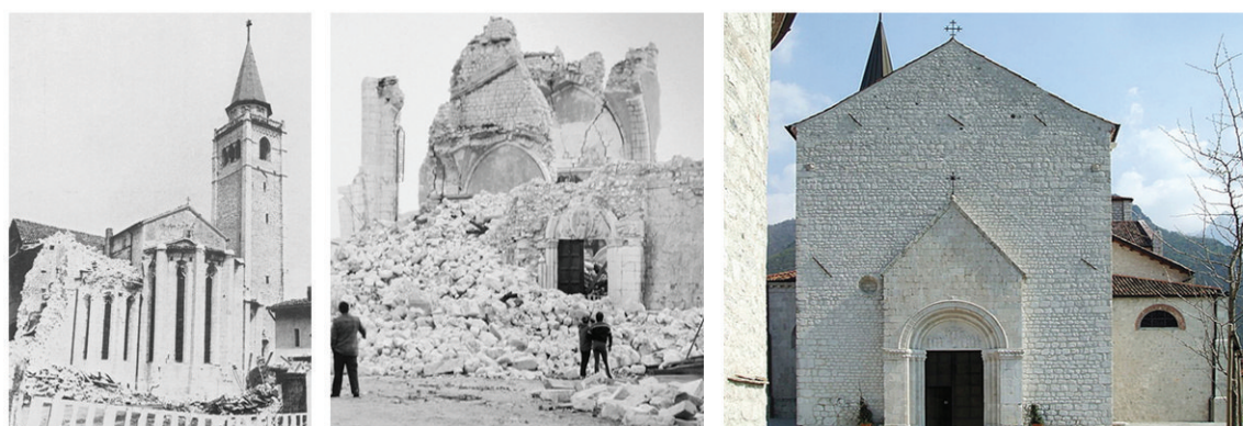
Figg. 105-107 Duomo di Venzone (UD) : intervento di ricostruzione di Francesco Doglioni (1988-95). Le immagini mostrano la situazione successiva al sisma e quella a fine lavori.
