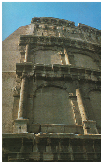
Figg. 50-52 Colosseo, Roma : intervento di Raffaele Stern sullo sperone orientale successivamente alla scossa sismica del 1806.
