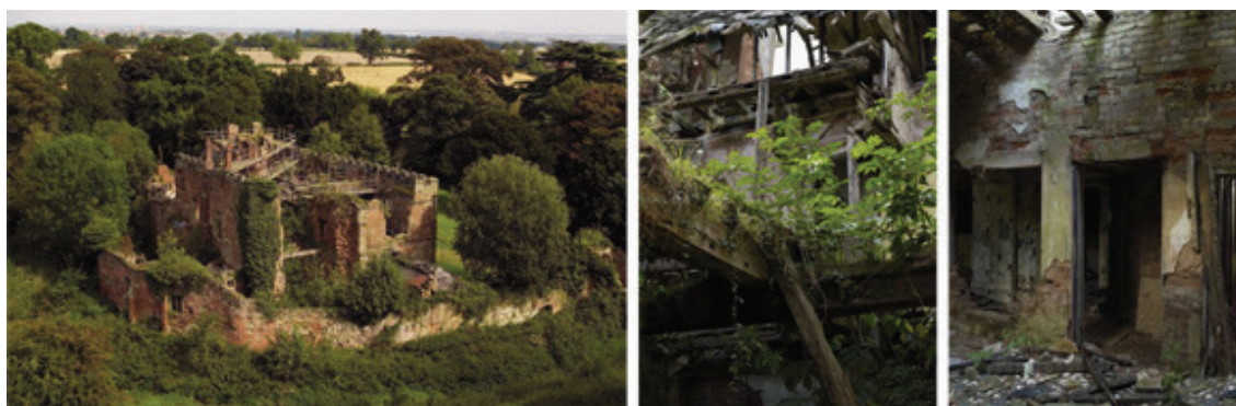
Fig. 5.62 Documentazione delle condizioni del castello dopo l'incendio del 1978 (immagini tratte da www.landmarktrust.org.uk ).
