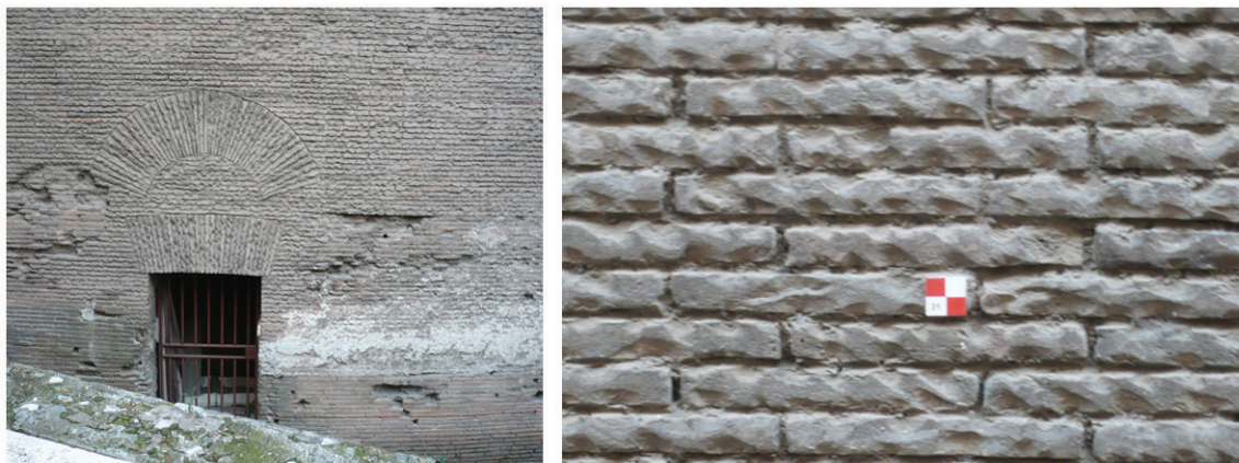
Figg. 34-35 Pantheon, Roma : il restauro condotto dal soprintendente Alberto Terenzio (1929-34) opera integrazioni del paramento impiegando nuovi mattoni con le stesse dimensioni e caratteristiche di quelli antichi ma opportunamente scalpellati in superficie per renderli riconoscibili ad una vista ravvicinata.
