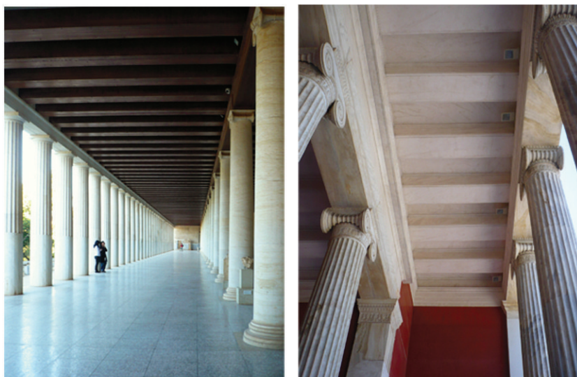
Figg. 103-104 Stoà di Attalo, Atene : intervento di ricostruzione (1953-56).
