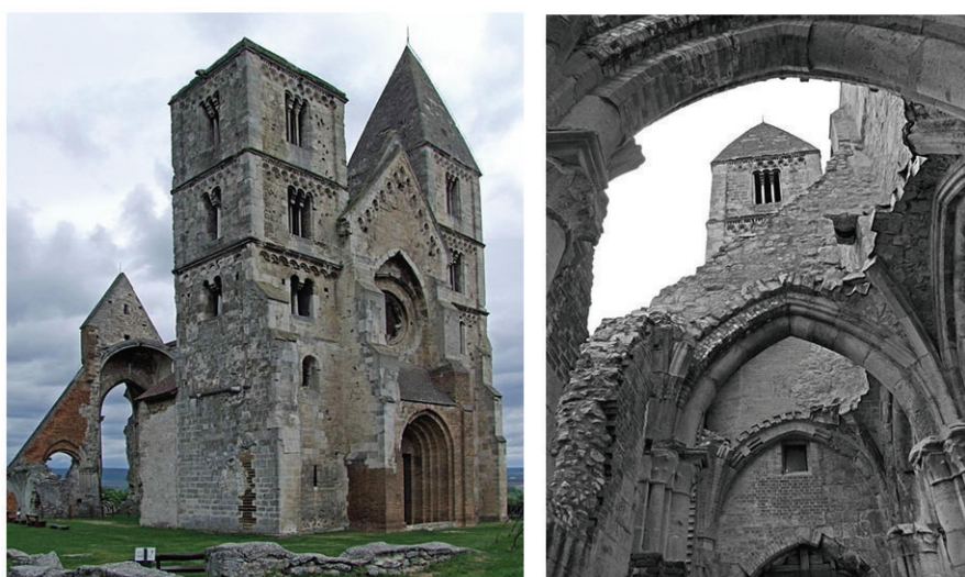
Figg. 69-70 Abbazia premostratense di Zambek , Ungheria (XIII-XIV secolo con aggiunte successive): in seguito a un evento bellico (1581) e uno sismico (1763), l'edificio del monastero è distrutto e la chiesa cade in rovina. Nel 1899 Istvan Möller interviene con operazioni di consolidamento limitate a garantire la permanenza dei resti, realizzando speroni e rinfianchi e reintegrando archi, piedritti e settori murari.
