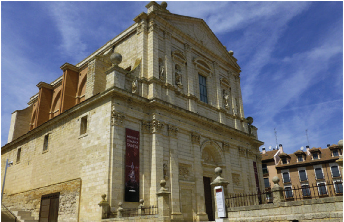
Fig. 5.10 Vista esterna dell'edificio monumentale dopo l'intervento: si noti la porzione di muratura reintegrata sul fianco sinistro della chiesa (tratta da www.trapatroles.wordpress.com ).
