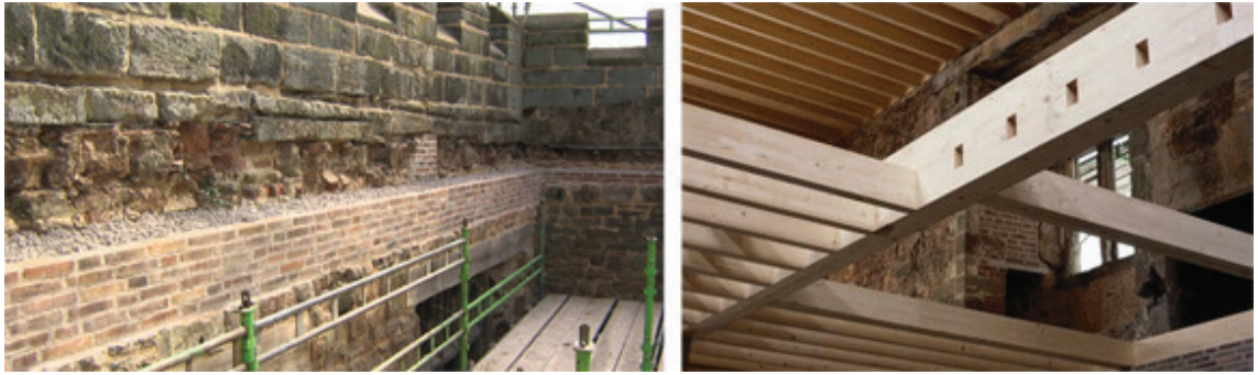
Fig. 5.69 Realizzazione della nuova muratura in mattoni allungati e messa in opera del solaio ligneo al primo livello (foto tratte rispettivamente da: www.landmarktrust.org.uk e da www.architectural-review.com ).
