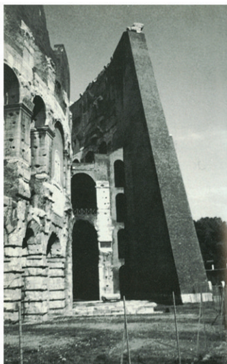
Figg. 50-52 Colosseo, Roma : intervento di Raffaele Stern sullo sperone orientale successivamente alla scossa sismica del 1806.
