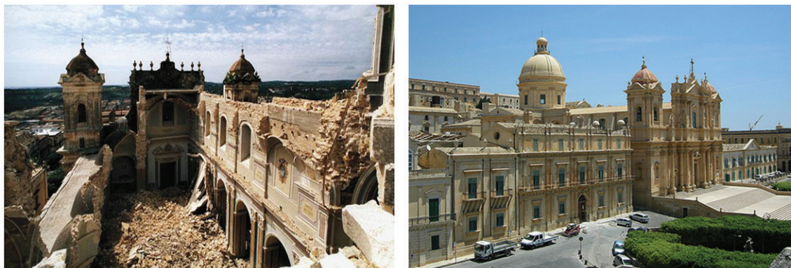
Figg. 144-45 Cattedrale di Noto (SR) : intervento Salvatore Tringali (1996-2008).
