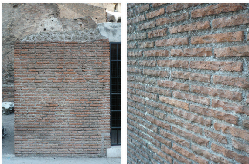
Figg. 36-37 Colosseo, Roma : le parti reintegrate vengono distinte da quelle antiche attraverso scalpellature sulla superficie del paramento laterizio, similmente a quanto condotto al Pantheon.
