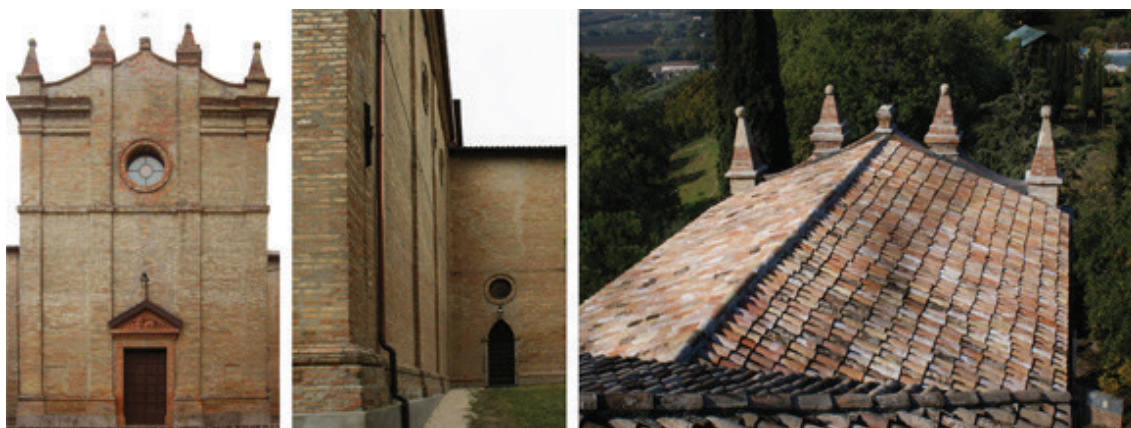
Fig. 5.73 Da sinistra: la facciata principale, il fianco esterno destro della navata con un ingresso secondario in corrispondenza del braccio destro del transetto e la copertura della navata immediatamente dopo l'intervento di restauro conservativo e di manutenzione effettuato nel corso del 2009 (foto M. Zanetti).
