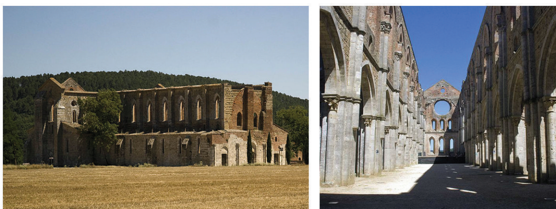
Figg. 67-68 Abbazia di San Galgano, Chiusdino (SI): in seguito a numerosi crolli dovuti a incuria e abbandono, l'edificio giunge all'inizio del secolo scorso privo di copertura. Intervento di conservazione "a rudere" della fabbrica duecentesca progettato dal soprintendente Gino Chierici nel 1926.
