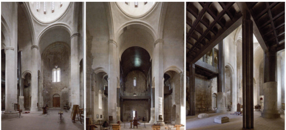
Fig. 5.87 La nuova struttura di completamento in acciaio e il volume della cattedrale reintegrato (foto tratte da: A. BRUNO, Op. cit. , p. 92).
