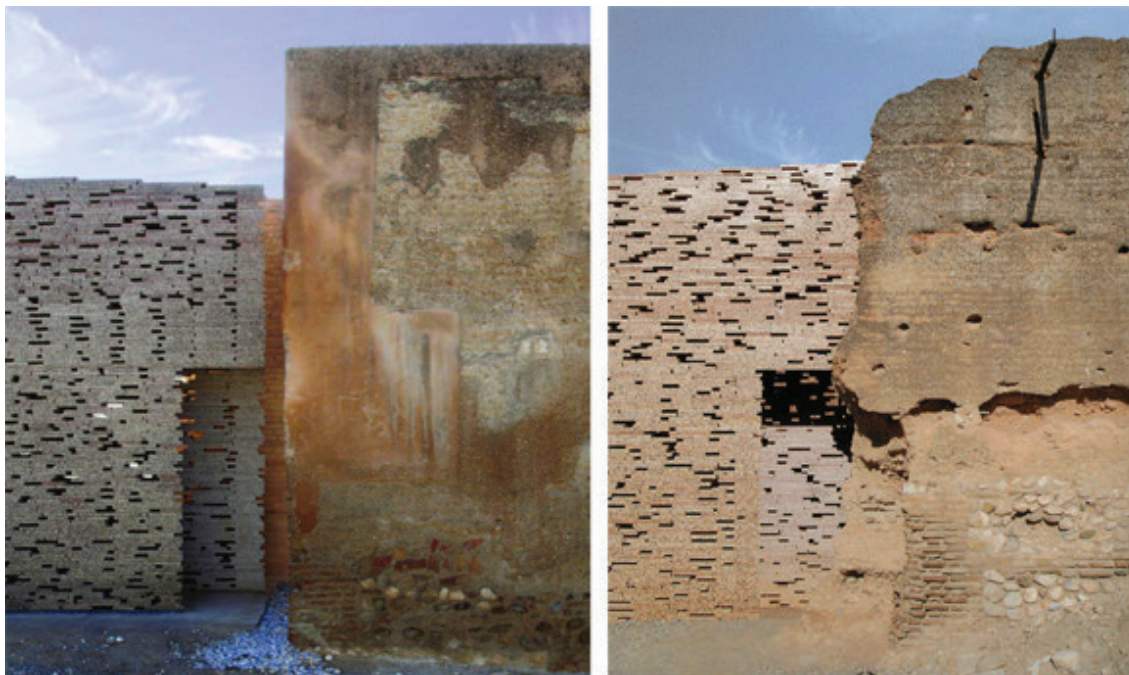
Fig. 5.41 Il nuovo paramento sui due fronti nel punto in cui si rapporta alla muratura antica (foto tratte rispettivamente da: www.newcosmopolis.wordpress.com e da: A. J. TORRECILLAS, Op. cit. p. 107).
