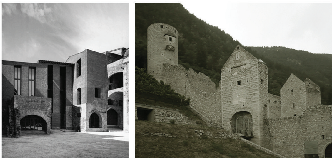
Figg. 149-50 Complesso di San Michele in Borgo, Pisa : intervento Massimo Carmassi (1985-2002); torre della chiesa di Rio Pusteria (BZ) : intervento Josef Rieder (1998-99).
