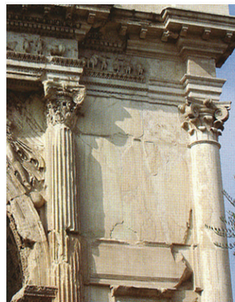
Figg. 53-55 Arco di Tito, Roma : l'intervento cominciato da Raffaele Stern e portato a compimento da Giuseppe Valadier opera differenziando i materiali e semplificando gli ornati.
