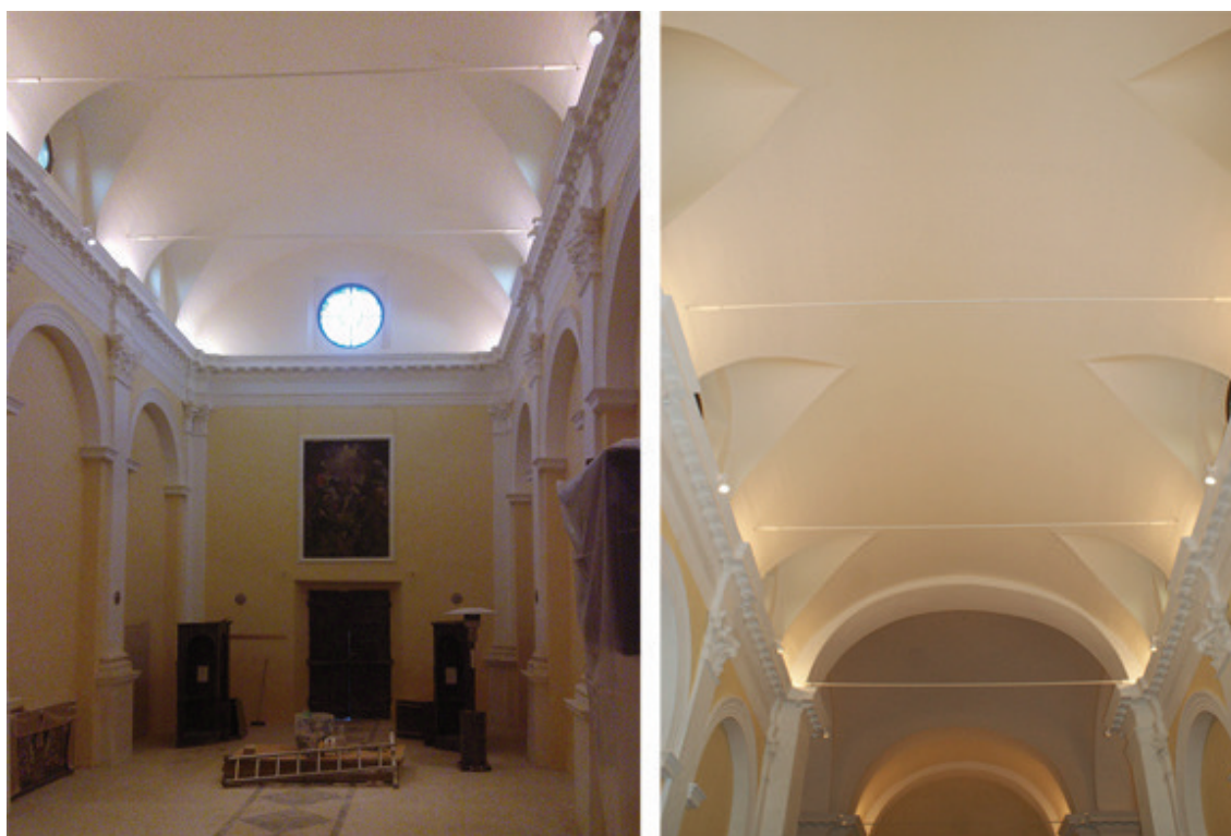
Fig. 5.80 L'interno del santuario, al termine dei lavori, durante lo studio dell'assetto delle luci (foto A. Alvisi, 2011).
