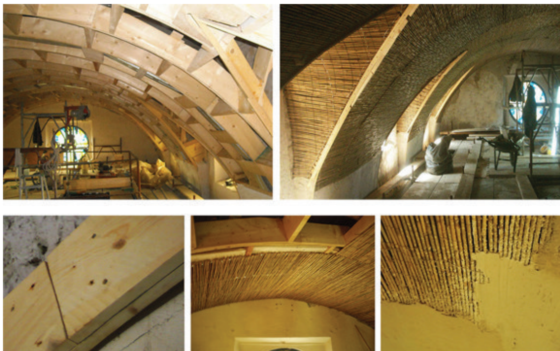
Fig. 5.79 Sopra: fasi del cantiere: messa in opera delle centine lignee e fissaggio delle arelle; sotto: dettagli costruttivi (foto A. Alvisi, 2011).
