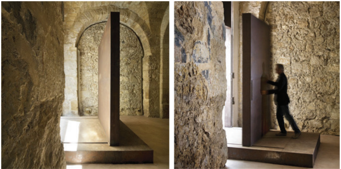
Fig. 5.55 Funzionamento del portale in corten di accesso all'endonartece (foto tratte dalla Tavola 2 di partecipazione al concorso Domus restauro e conservazione ).
