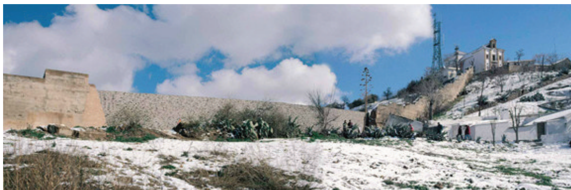
Fig. 5.36 La muralla Nazari dopo l'intervento (foto tratta da www.antoniojimeneztorrecillas.com ).
