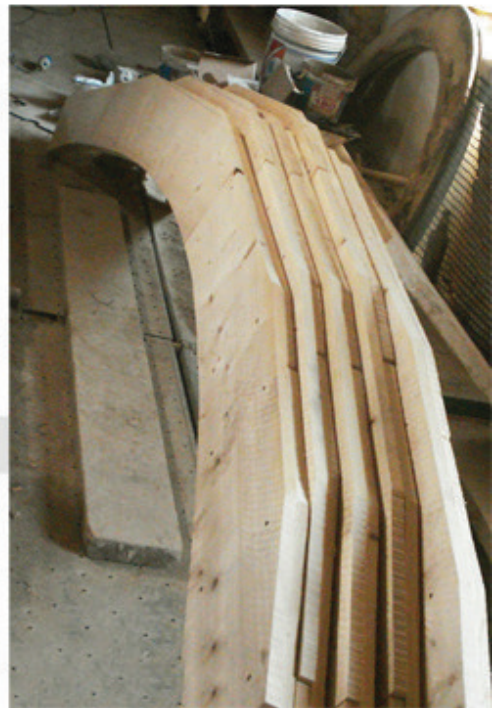
Fig. 5.78 Sopra: schizzi di studio della struttura di centine lignee; sotto, da sinistra: sagoma realizzata in cantiere per il taglio delle tavole di legno in modo da ottenere la curvatura voluta e centine pronte per la messa in opera (foto A. Alvisi, 2011).
