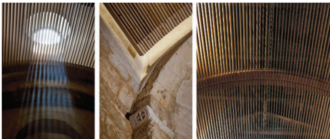
Fig. 5.54 Dettagli delle lamelle lignee del controsoffitto (foto L. Rubino, tratte da: www.europaconcorsi.com ).
