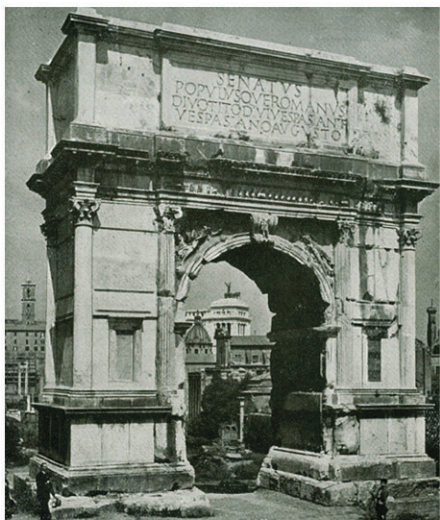
Figg. 53-55 Arco di Tito, Roma : l'intervento cominciato da Raffaele Stern e portato a compimento da Giuseppe Valadier opera differenziando i materiali e semplificando gli ornati.
