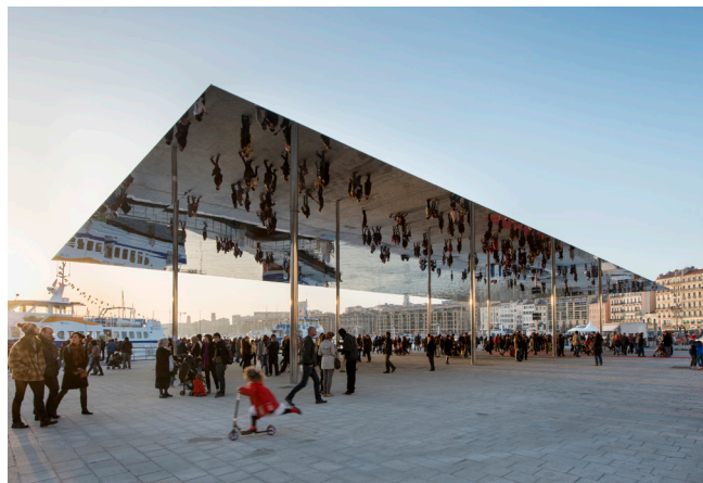
Fig. 37 – Tettoia realizzata da Norman Foster nell'ambito del progetto di riqualificazione del vecchio porto di Marsiglia, in Francia.
