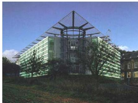
**Peculiarità:** Si tratta dell'ampliamento di una struttura residenziale per anziani, in una zona molto piovosa della Francia. Il progetto è caratterizzato dalla facciata "sensoriale", in grado di recepire tramite sensori i livelli di illuminamento ed adattare la luce interna di conseguenza, garantendo un comfort luminoso ottimale.
