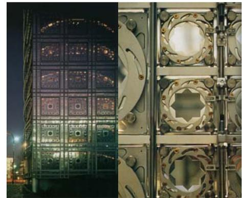
una quantità di illuminamento costante. Il progetto di Jean Nouvel ha il doppio pregio di risolvere brillantemente un problema funzionale, legato al comfort interno, e allo stesso tempo, caratterizzare formalmente l'edificio con le componenti tecnologiche, che rimandano alle forme dell'architettura tipica della cultura della committenza.
